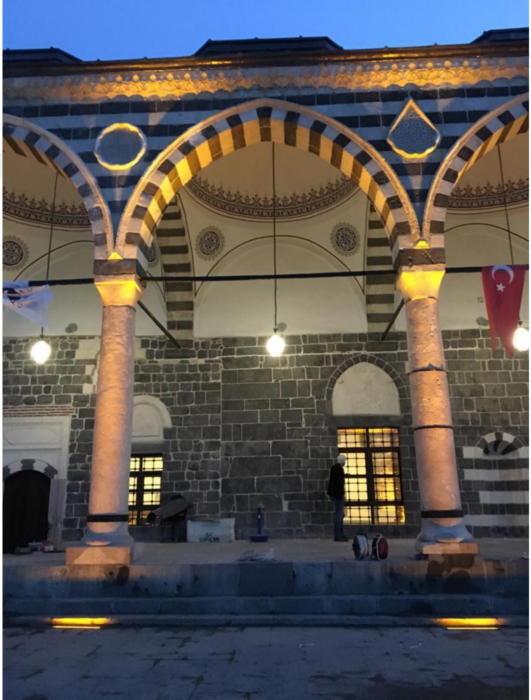
Şekil 7.19. Dış Sütun wallwasher montajı
