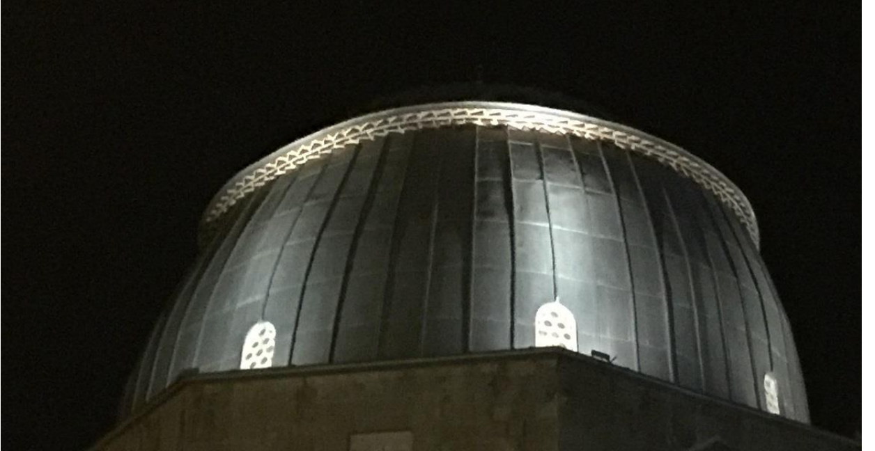
Şekil 7.39. Kubbe aydınlatılması görünümü
