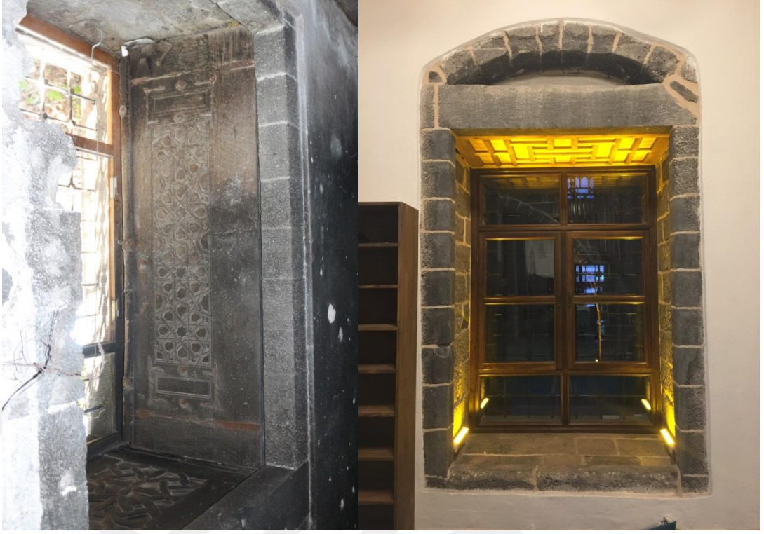
Şekil 7.14. Restorasyon Öncesi ve Restorasyon Sonrası Pencere içlikleri
