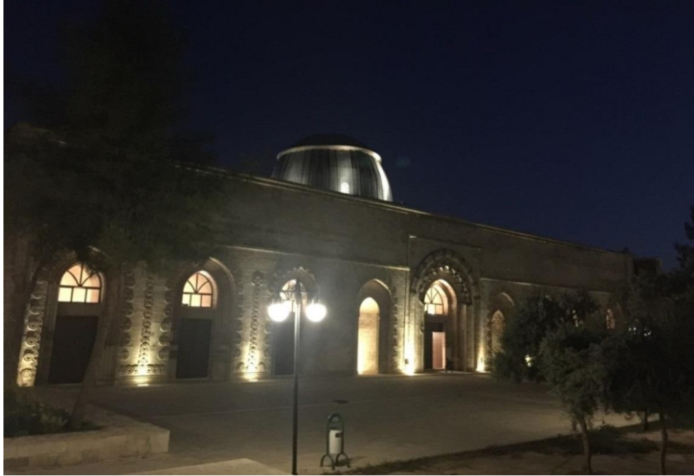
Şekil 7.37. Dış Aydınlatma genel görünümü
