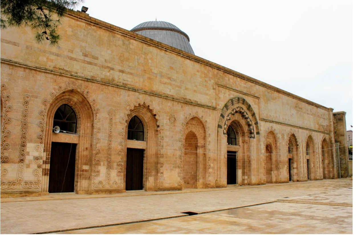
Şekil 7.35. Restorasyon sonrası genel görünüm
