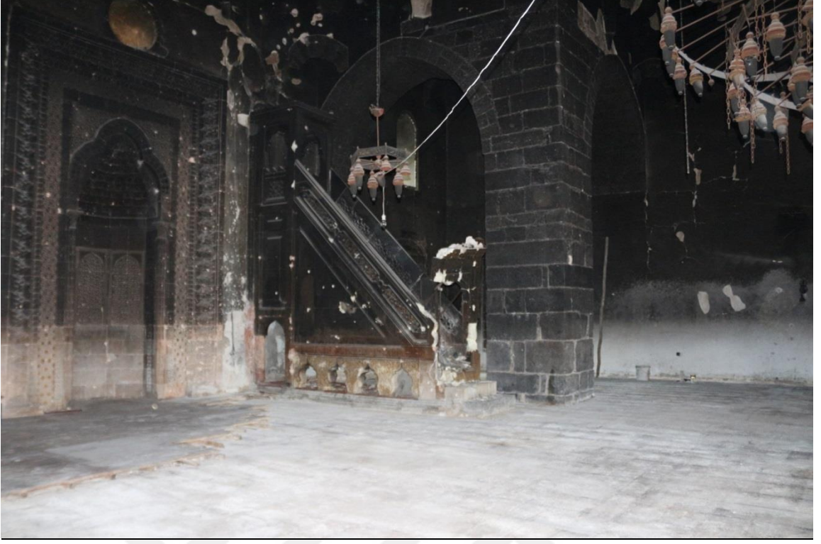
Şekil 7.7. Yangın sonrası minberin görünümü
