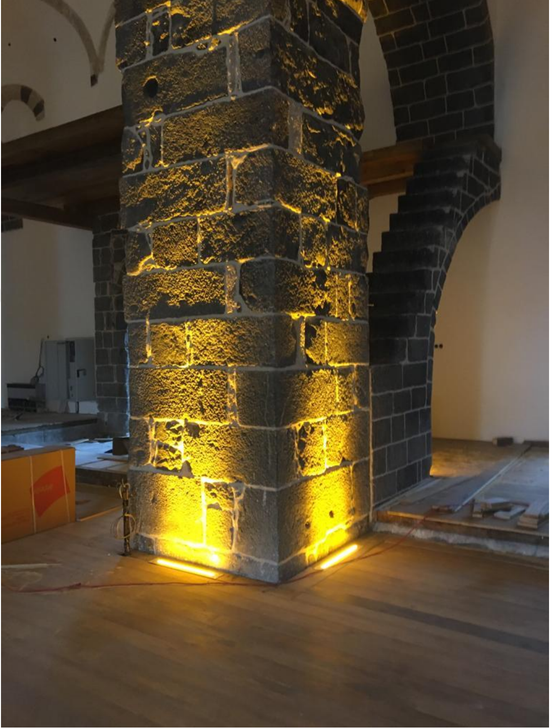
Şekil 7.15. Ana mekan sütun wallwasher montajı
