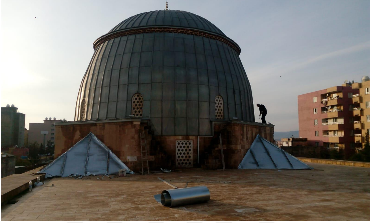
Şekil 7.38. Cami kubbe dış aydınlatılması için led yerleştirilmesi
