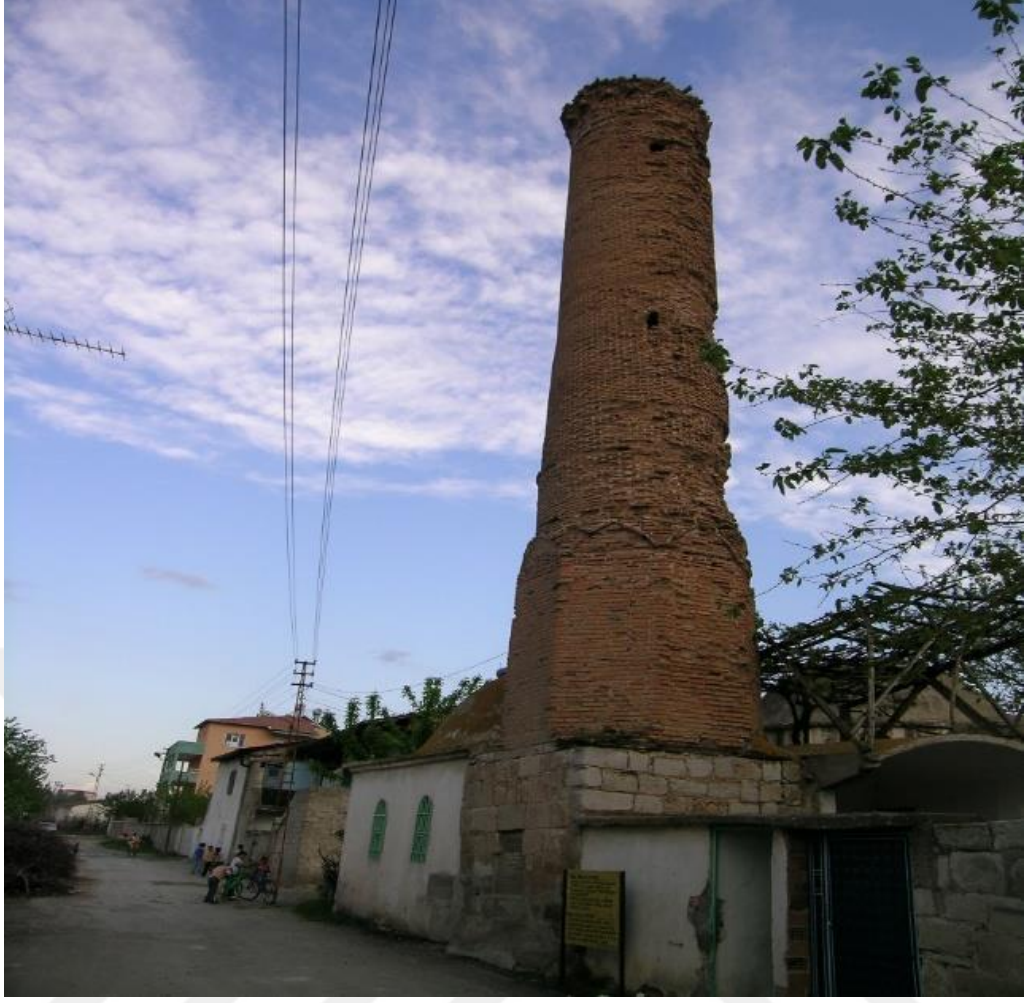
Şekil 7: Melik Sunullah Camii Minaresi'nin Restorasyon Öncesi Fotoğrafı (Malatya Vakıflar Bölge Müdürlüğü, 2017)
