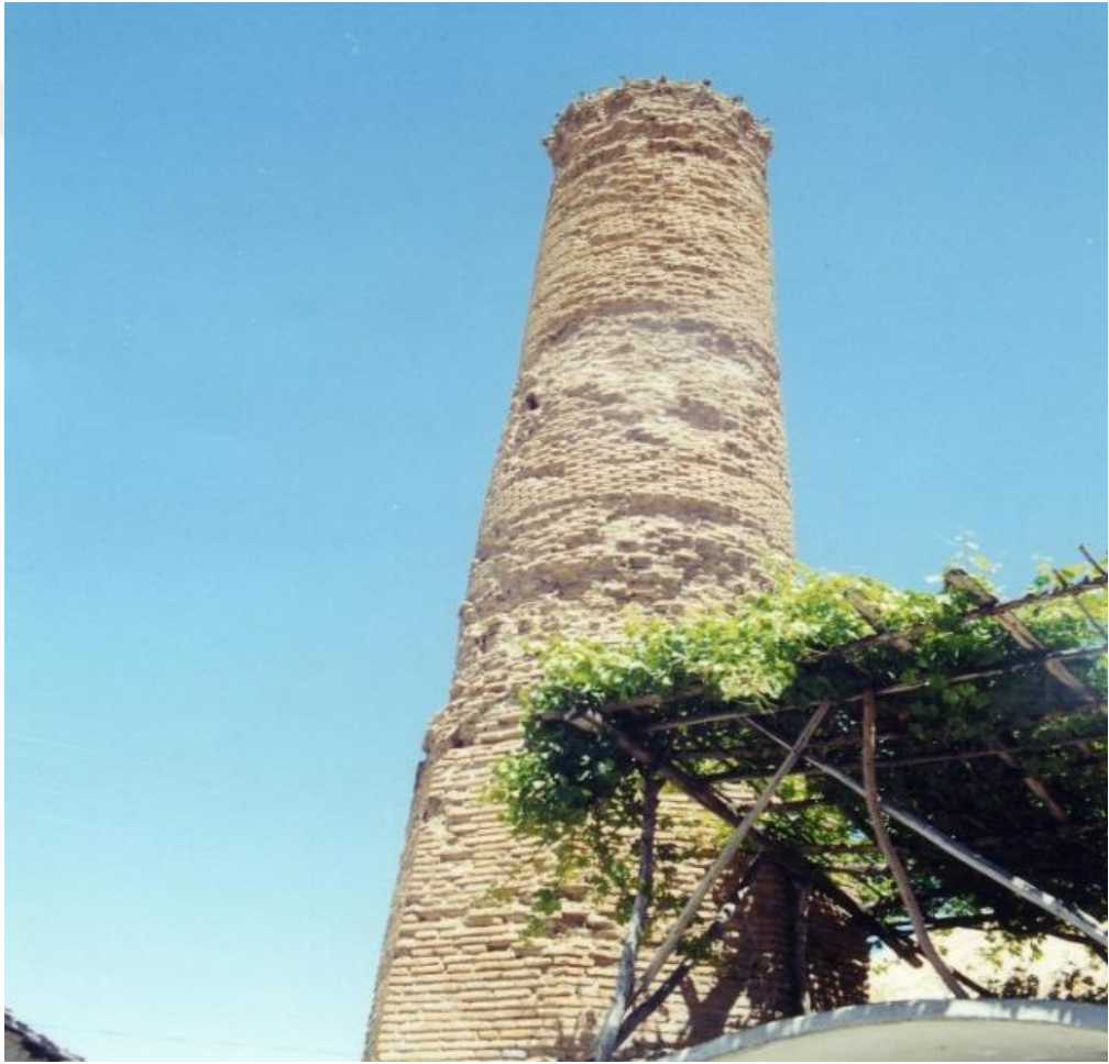
Şekil 6: Melik Sunullah Camii Minaresi’nin Restorasyon Öncesi Fotoğrafı (Malatya Vakıflar Bölge Müdürlüğü, 2025)
