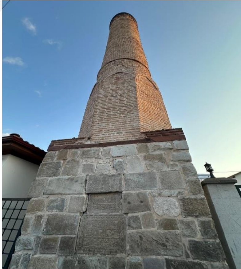
Şekil 10: Melik Sunullah Camii Minaresi'nin Kahramanmaraş Depremi Sonrası Fotoğrafı
