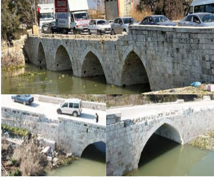
Şekil 1.2. Hatay ilinde bulunan tarihi bir köprüye ait hasarlar (Altunışık ve ark., 2023)
