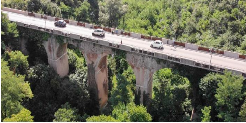
Şekil 2.4. San Ferdinando II köprüsü
