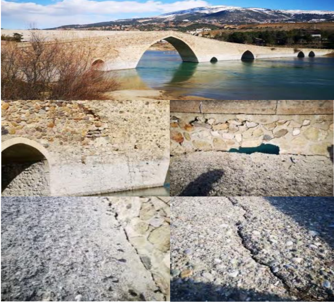
Şekil 1.1. Kahramanmaraş ilinde bulunan tarihi Ceyhan Köprüsüne ait hasarlar (Altunışık ve ark., 2023)
