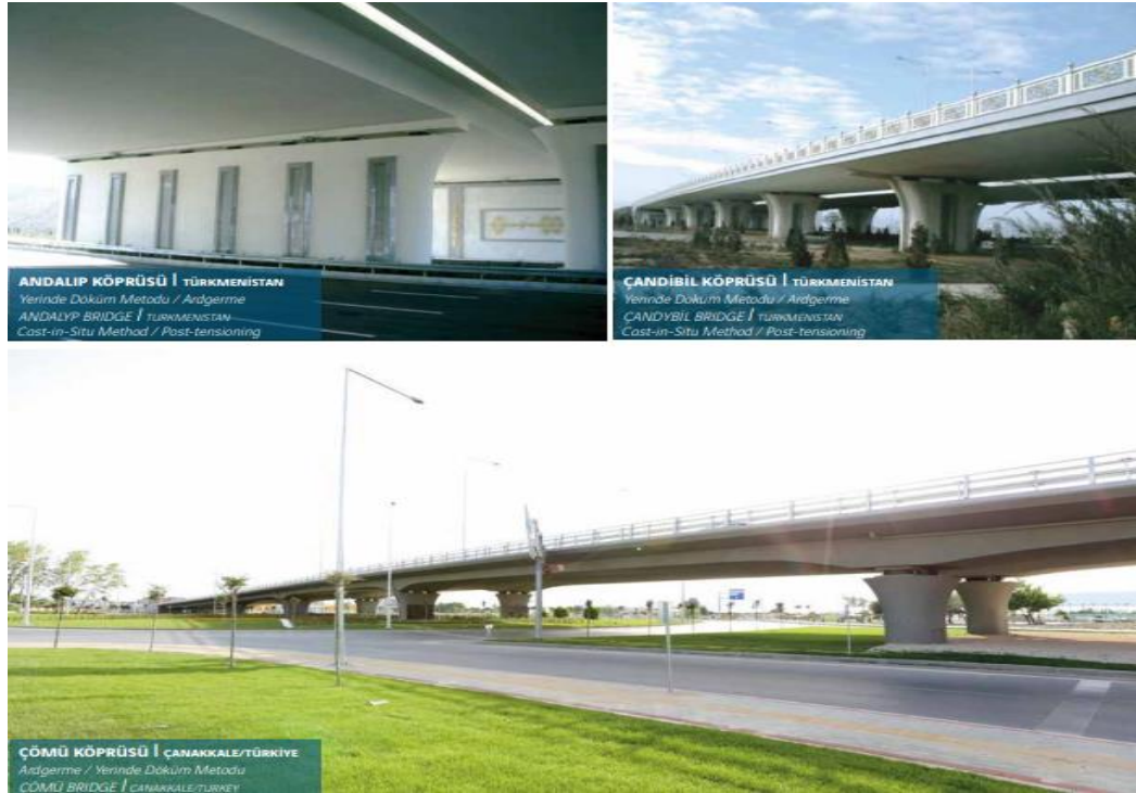
Şekil 3.14. Dünyada yerinde dökme köprü metoduyla yapılan köprülere örnekler
