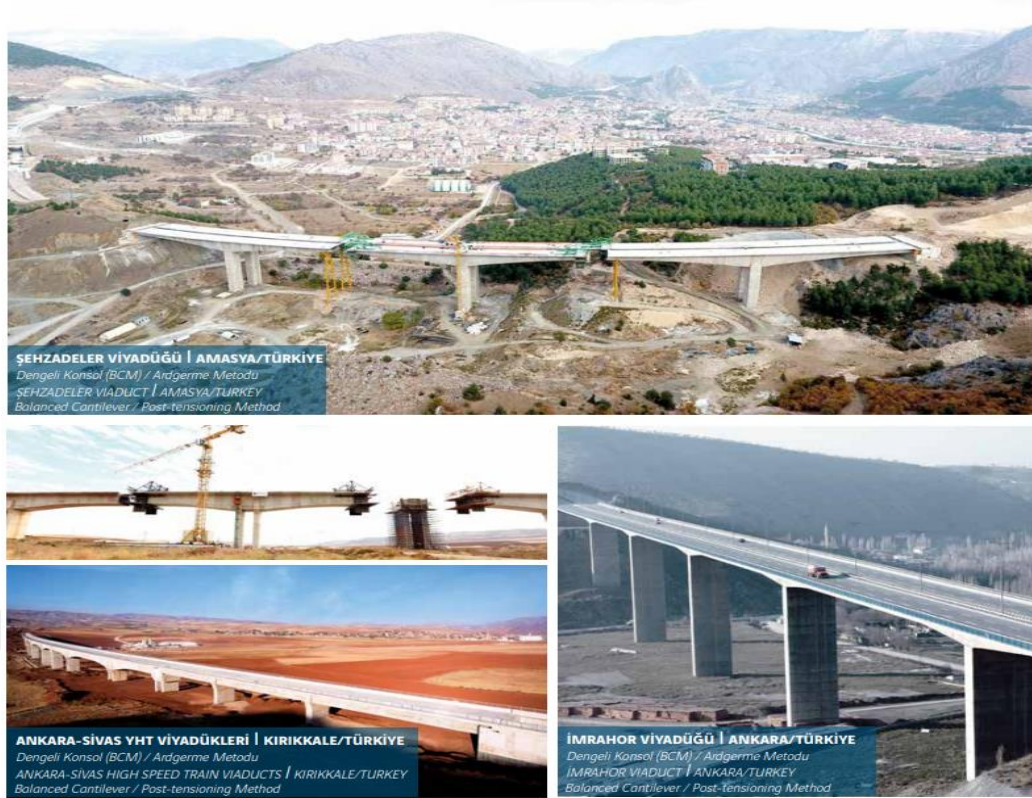
Şekil 3.12. Türkiye'de dengeli konsol yöntemiyle inşa edilmiş viyadüklere örnekler
