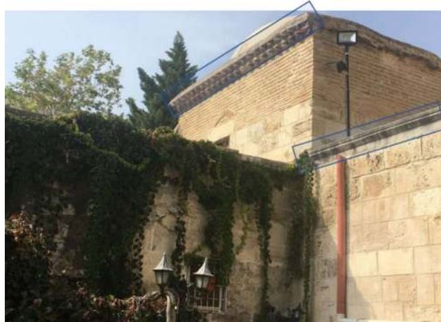
Görsel 5.27. Kirpi saçak, tuğla duvar ve düz taş silme
