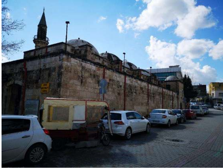
Görsel 5.13. Dış cephede kullanılan kesme taş
