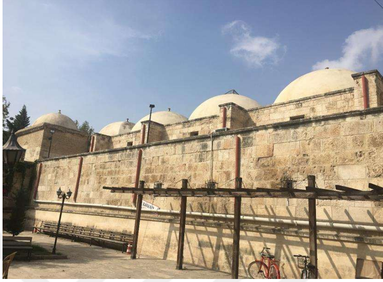
Görsel 5.25. Cephedeki pencereler ve kullanılan kesme taş
