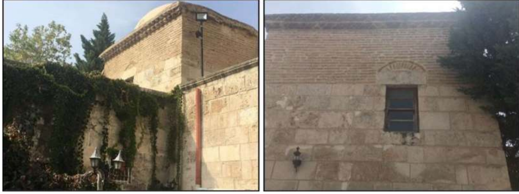
Görsel 5.12. Dış duvarda kullanılan tuğla malzeme
