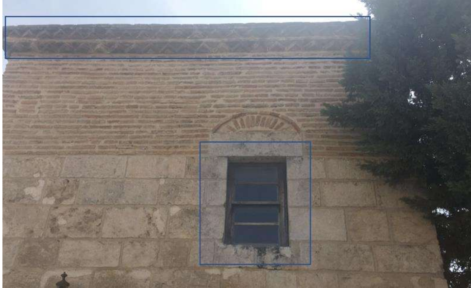
Görsel 5.24. Hücre kubbelerinin altındaki kirpi saçak ve ahşap pencere
