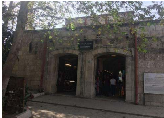
Görsel 5.18. Doğu cephesindeki kemerli kapılar
