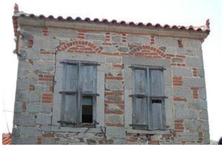
Şekil 3.44 Taş ve tuğla duvar, Skalochoori'de bir evin ön cephesi (Hatzilias, 2009)
