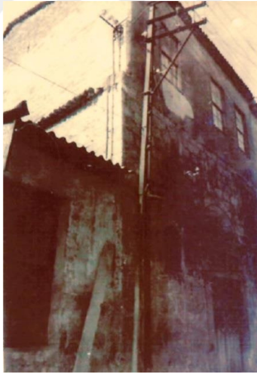
Şekil 3.15 KVKBK 519 tescil nolu yapı (Ayvalık Belediyesi arşivi)
