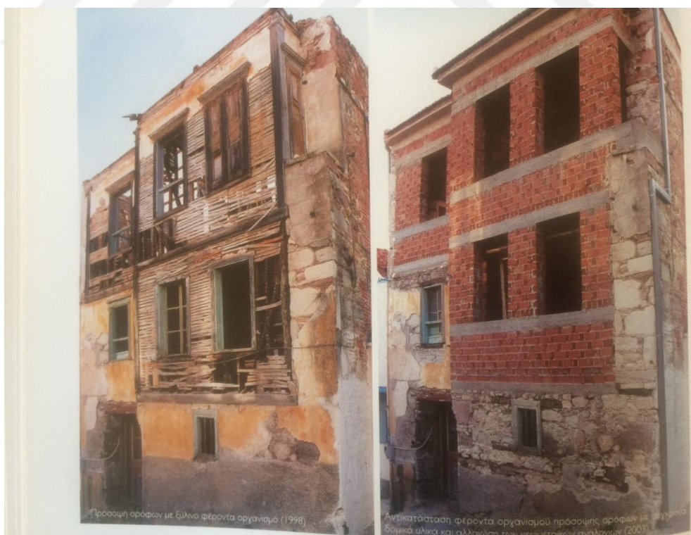
Şekil 3.82 Mahalledeki konut yapılarındaki onarım sonrası değişim (Karatzas, 2004)
