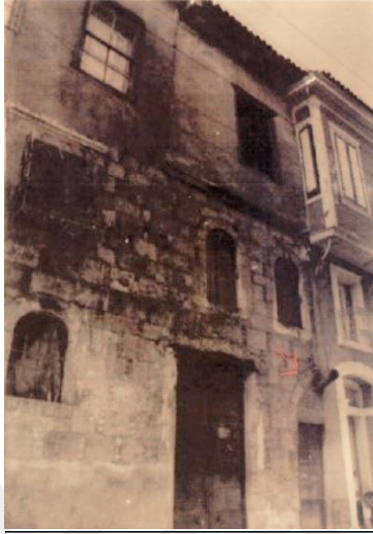
Şekil 3.14 KVKBK 517 tescil nolu yapı (Ayvalık Belediyesi arşivi)
