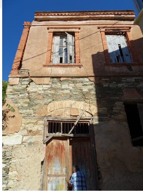
Şekil 3.32 Beden duvarında yeşil renkli taşın görüldüğü bir yapı (Kişisel arşiv, 2022)
