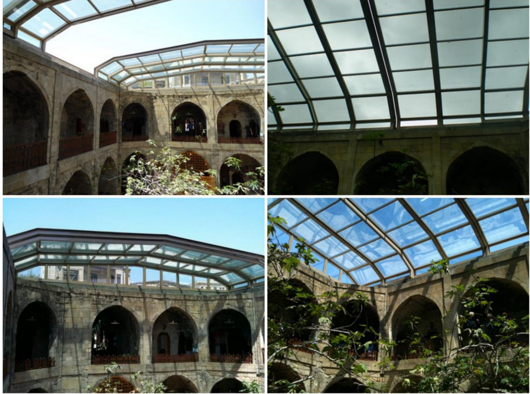
Şekil 5.16 : Açılır-Kapanır Çatı Sistemi Örneği
