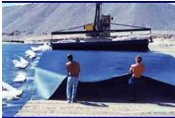
Şekil 5.14. Geomembran yerleştirimi (URL-5).
