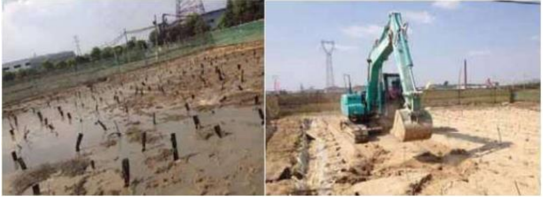
Şekil 5.13. Elektro osmoz öncesi ve sonrası (Şahan, 2016).
