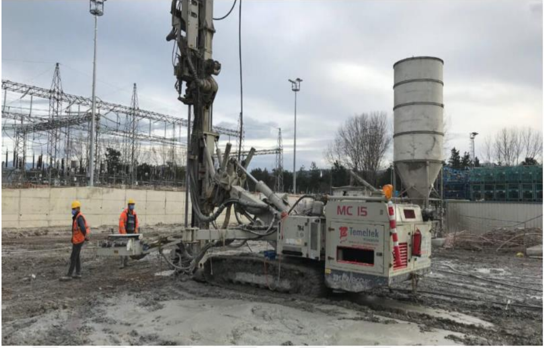
Şekil 5.3. Jet grout yöntemi (URL-4).
