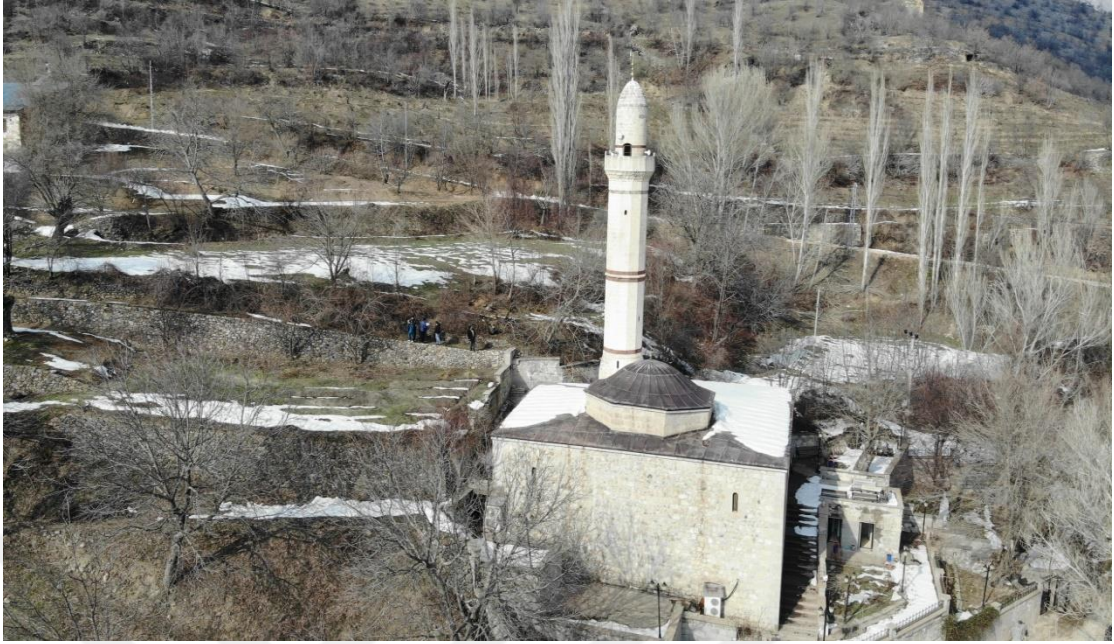
Şekil 2.2. Caminin dışarıdan görünüşü.
