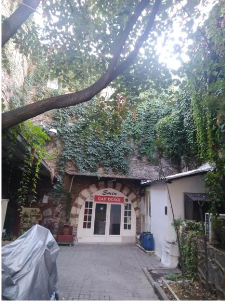
Şekil 120 Eski İpek Han Güney Cephesi Sarmaşık Oluşumları (Hoş Ulusoy, 2021)
