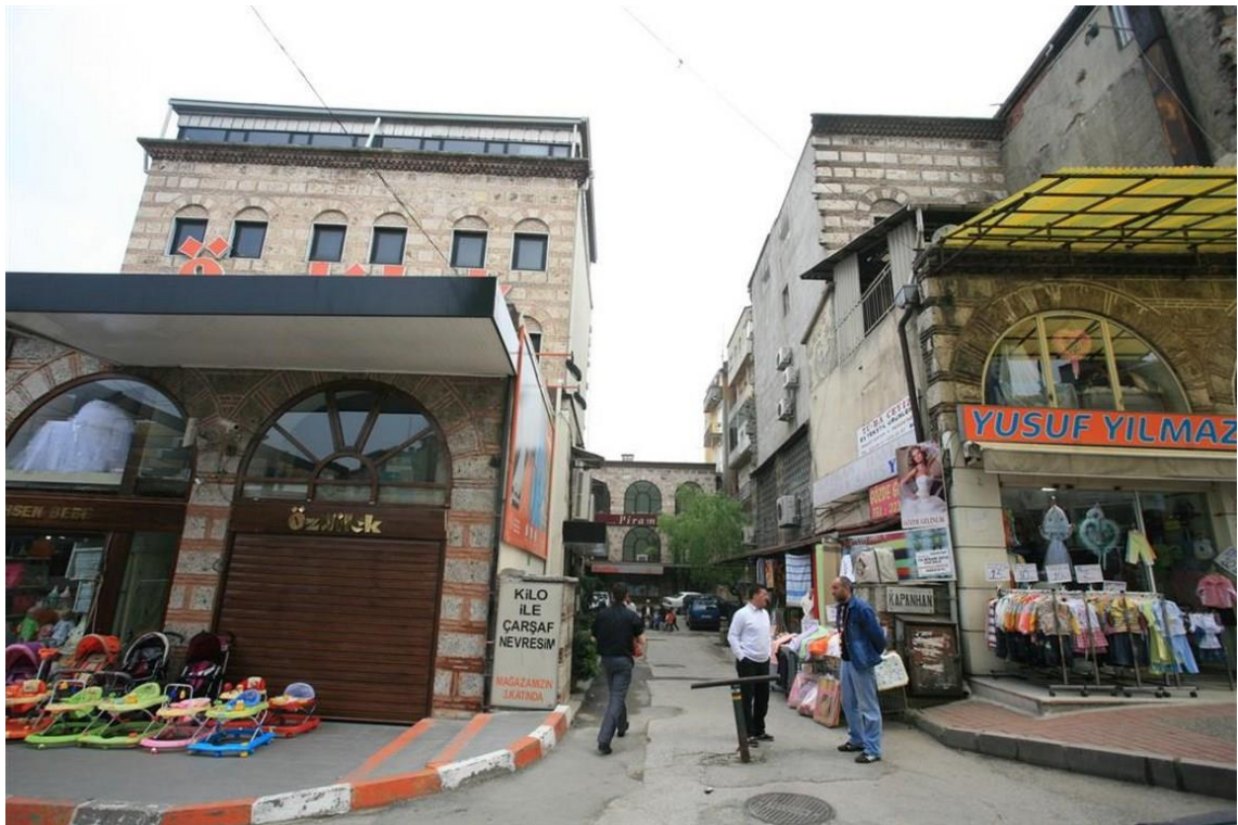
Şekil 42 Bursa Kapan Han'ın mevcut durumu, Url 18
