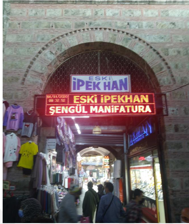
Şekil 87 Eski İpek Han Doğu Cephesinden Avluya Giriş Sağlayan Ana Kapısı (Hoş Ulusoy, 2021)
