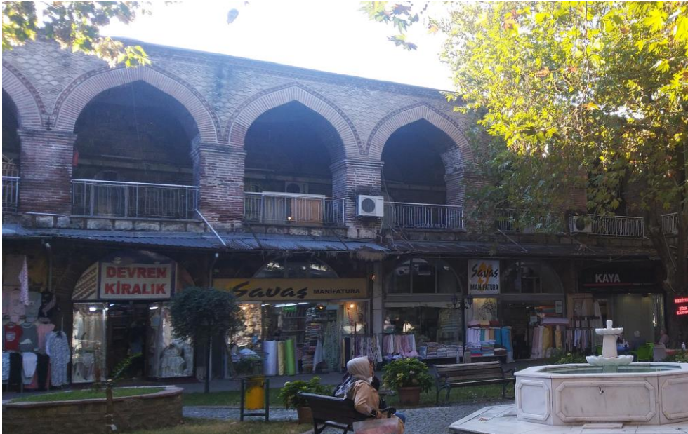
Şekil 100 Eski İpek Han, İç Cephe Batı Görünüşü (Hoş Ulusoy, 2021)
