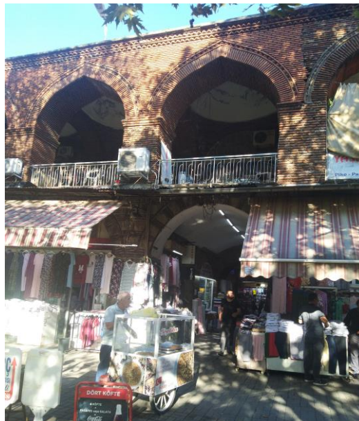
Şekil 98 Eski İpek Han İç Avlu Doğu Cephesi, Ana Giriş Kapısı (Hoş Ulusoy, 2021)
