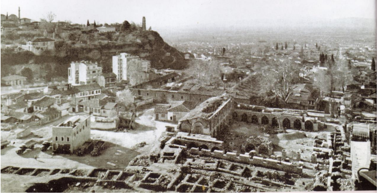
Şekil 106 Bursa İpek Hanı ve Çevresi, 1958 Yangınında Çekilmiş Hava Fotoğrafı (Bursa Belediye Arşivi)
