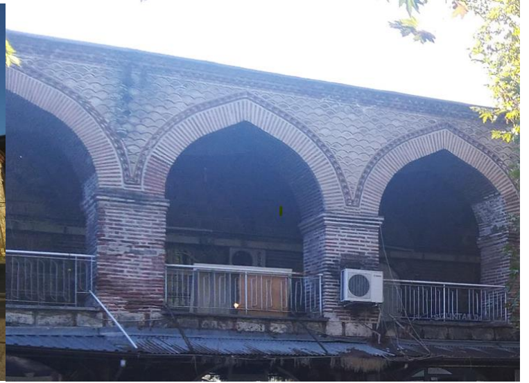
Şekil 79 Eski İpek Han Batı Cephesi Dış Duvarları (Hoş Ulusoy, 2021)
