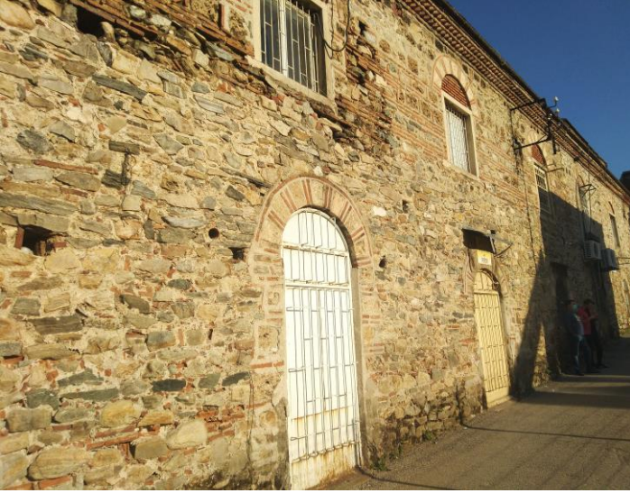
Şekil 78 Eski İpek Han Batı Cephesi Dış Duvarları (Hoş Ulusoy, 2021)
