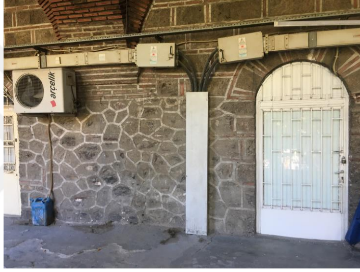
Şekil 116 Eski İpek Han Cephe Estetiğini Bozan Elemanlar (cephedeki malzeme farklılıkları, metal elektrik aksamı, klima dış ünitesi, tarihi yapıya uyumsuz demir kapı), (Hoş Ulusoy, 2021)
