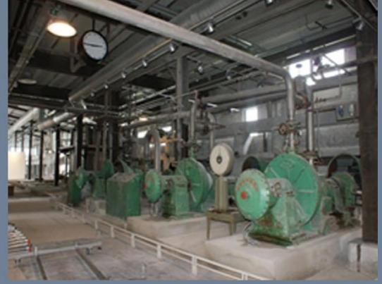
Şekil B: Hamur hazırlama dairesinde bulunan Emerson makinalarının restore edilip yerinde sergilenmesi Kaynak: Çakır arşivi
