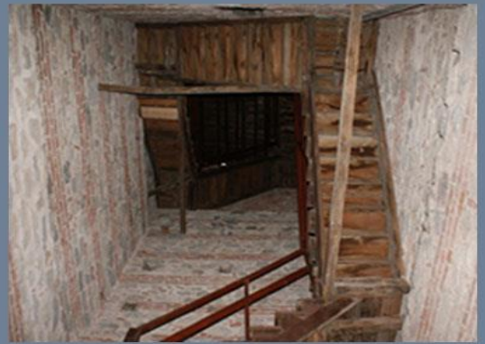
Şekil D: Çan kulesinin içinden görünüm, kaynak Çakır arşivi
