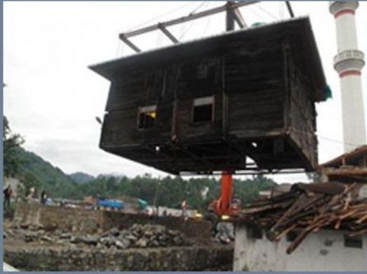
Şekil A: Kalkandere camisinin söküm aşamasından görünüm, kaynak: URL 25
