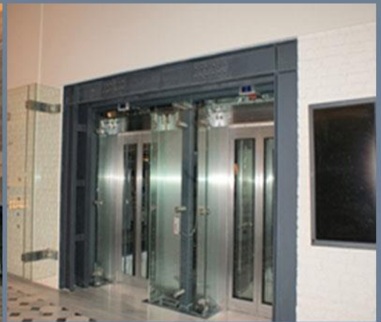
Şekil D: Çift taraflı tasarlanan asansör, kaynak Çakır arşivi
