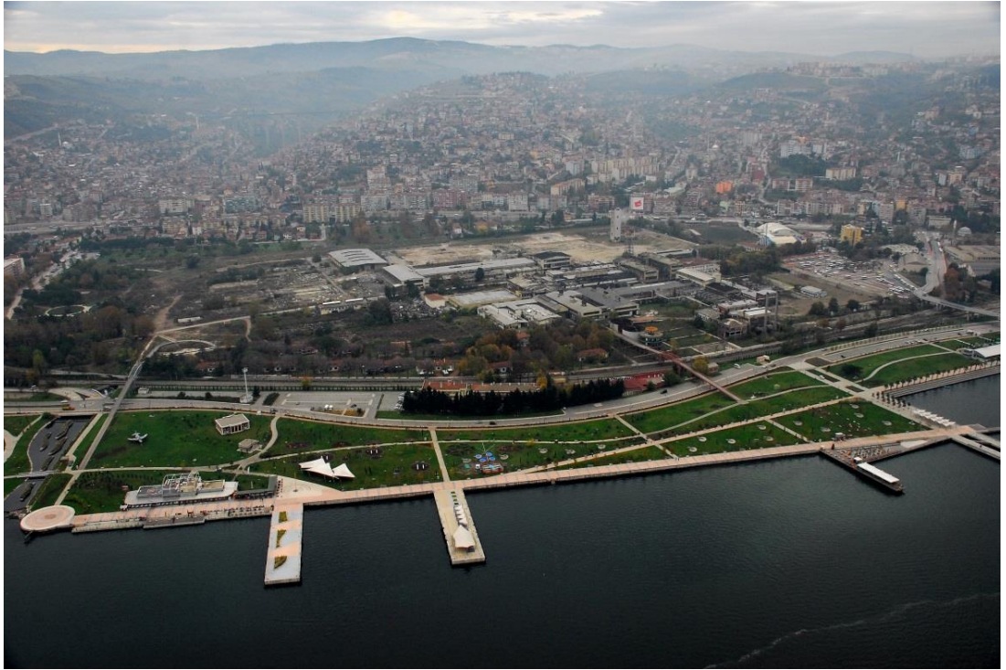
Şekil 47: SEKA dönüşüm sonrası fabrika kompleksi havadan görünüm (SEKA arşiv dokümantasyon merkezi,2008)
