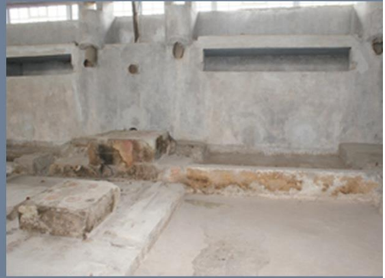
Şekil D: Polidisk teksif eleğinin yanında bulunan hamur akışını ayarlayan kanalların yerinde korunması Kaynak Çakır arşivi
