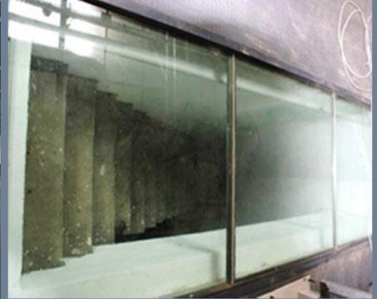
Şekil D: Özgün merdivenin korunması için yapılan Cam döşeme Kaynak: Çakır arşivi
