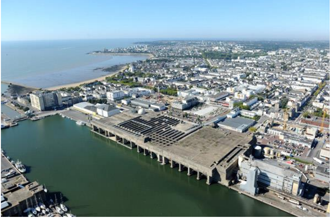
Şekil 14: Alveole 14 denizaltı hangarı dönüşüm sonrası bağlamsal ilişkisi ( URL 24)
