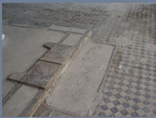
Şekil A: Özgün döşeme ve makina kalıntılarının mekansal gösterge olarak korunması kaynak: Çakır arşivi
