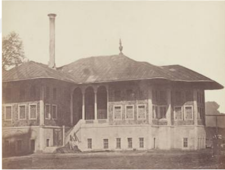
Şekil 1.11. Dolmabahçe sahil sarayında yer alan yıkılan köşk.
