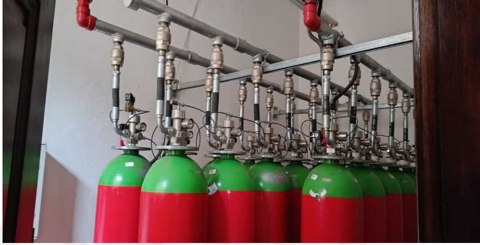
Şekil 4.5. Arşiv depo argon gazlı söndürme tüpleri.
