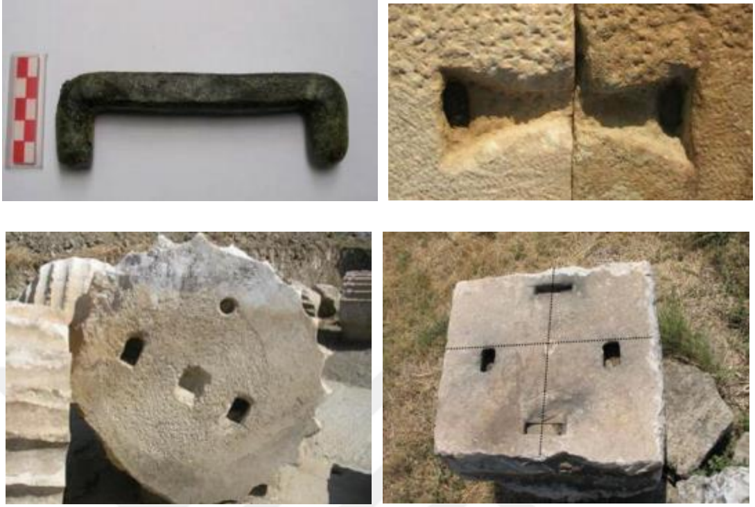
Şekil 2.3 (devam). Metal Bağlantı Uygulamaları (Demirtaş, 2006).
