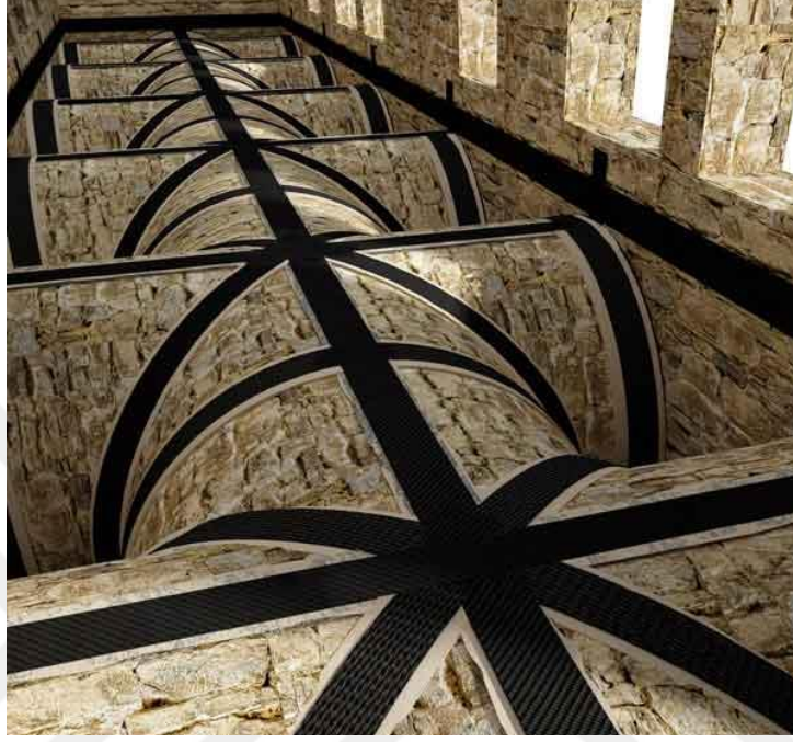
Şekil 1.2. Karbon elyaflar (FRP) kullanılarak takviye edilen tonozlar (URL-1).
