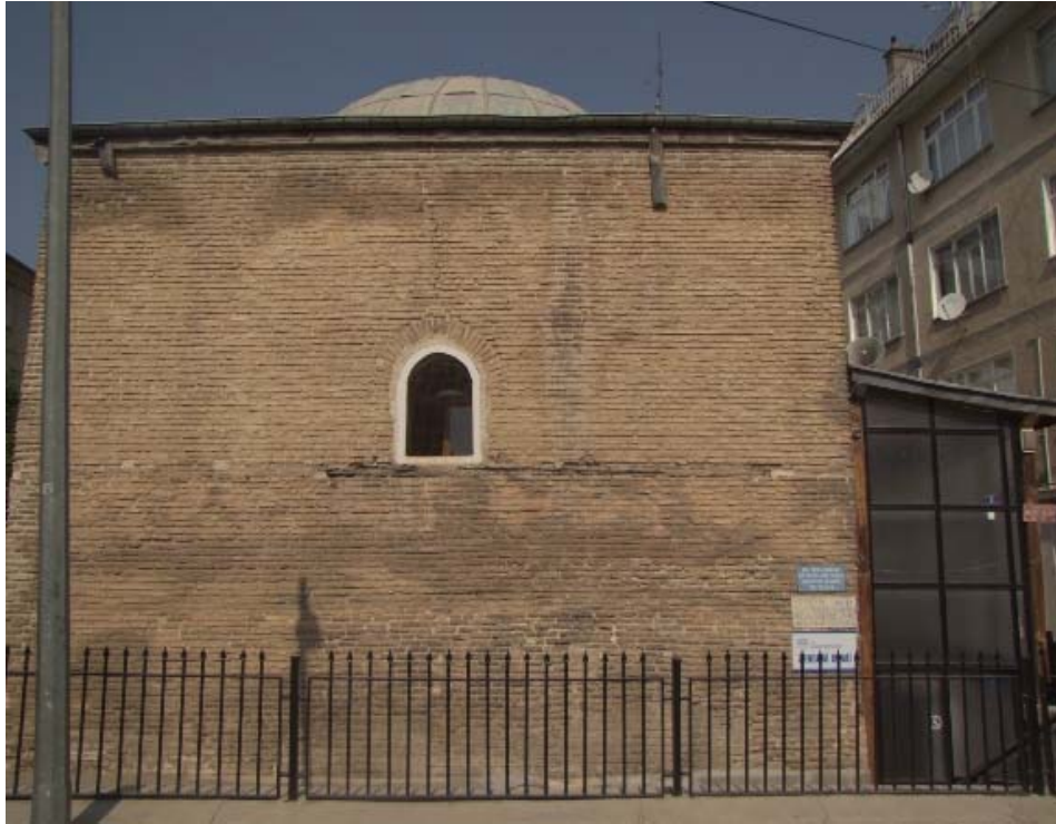
Şekil 8.4 Mescidin doğu cephesi
