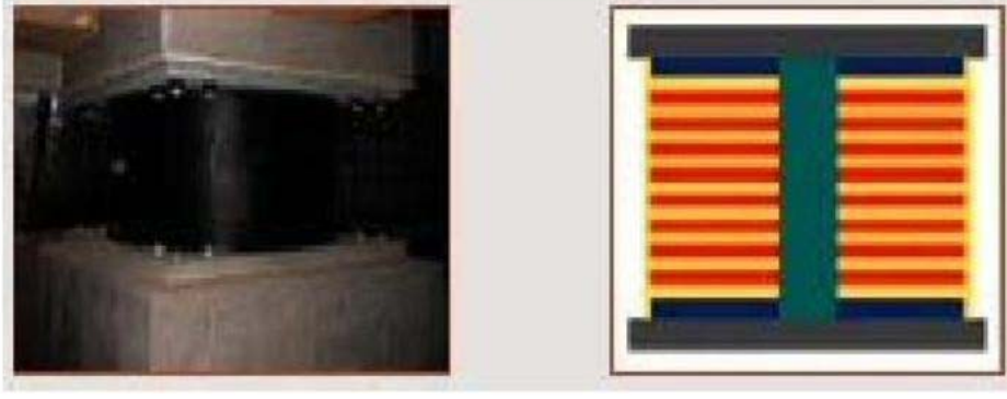
Şekil 7.20 Kauçuk esaslı kurşun çekirdekli izolatör
