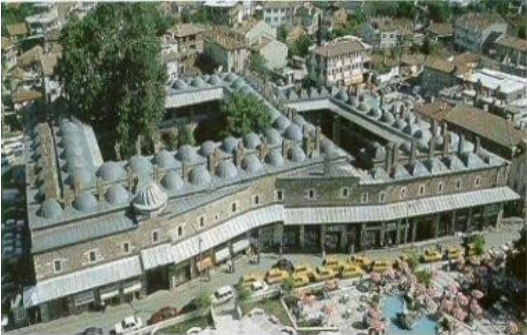
Şekil 3.22 Rüstem paşa kervansarayı-Edirne
