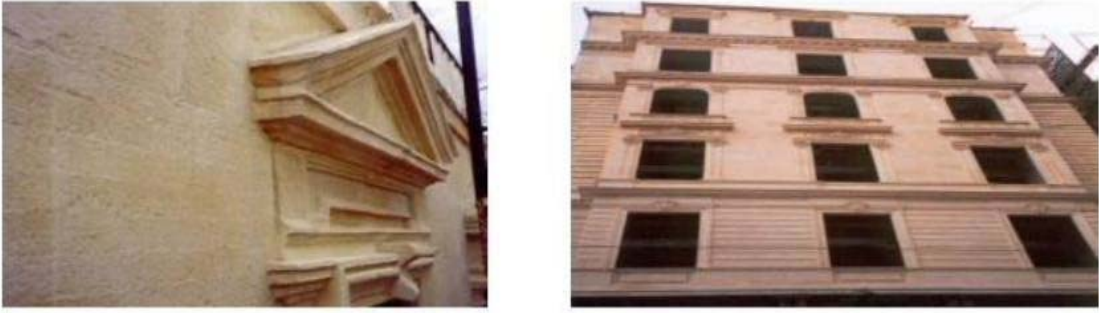
Şekil 7.30 Cephe temizliği yapılmış binalar
