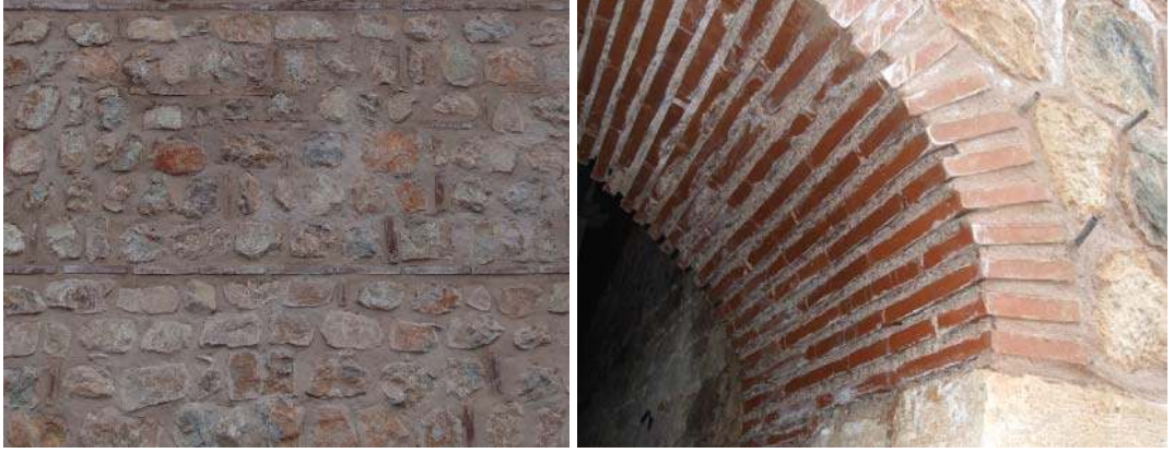
Resim 2.1. Harcın duvar örülmesinde ve kemer yapımında kullanılması (Tokat Hatuniye Medresesinde tuğla ve harç görüntüsüne ait bir kesit)
