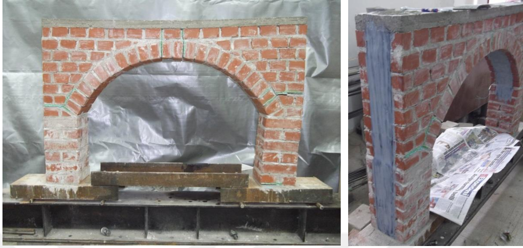
Şekil 4.8. FRP uygulaması öncesi hasarlı hali ve FRP uygulanmış hali.
