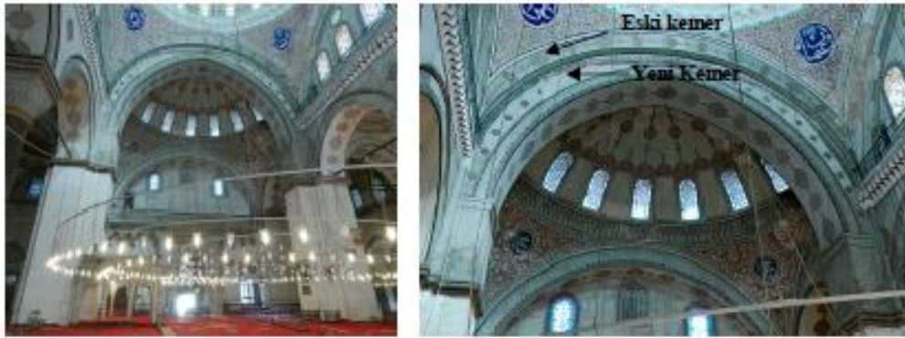
Şekil 2.10. Mimar Sinan'ın II. Beyazid Camii kemerinde yaptığı güçlendirme.
