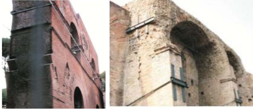
Şekil 2.9. Kemerlerde ve duvarlarda gergi düzenlenmesi (Sesigür vd., 2007).
