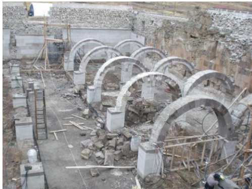
a) Restorasyon esnası
