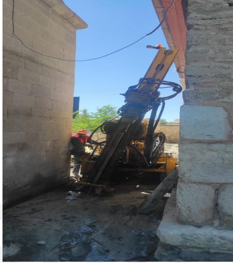
Şekil 4.34. Minare temeline uygulanan eğimli enjeksiyon örneği
