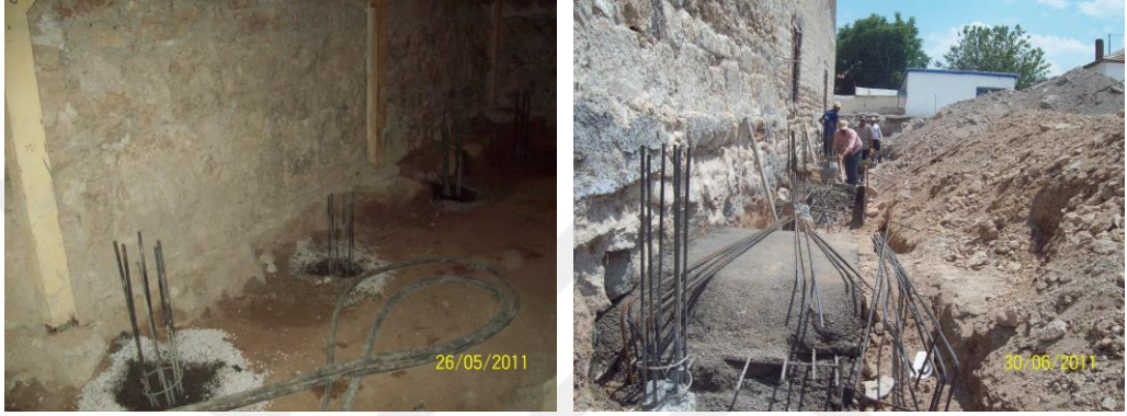
Şekil 4.3. Eski Ulu Cami mini kazık ve enjeksiyon uygulama fotoğrafları
