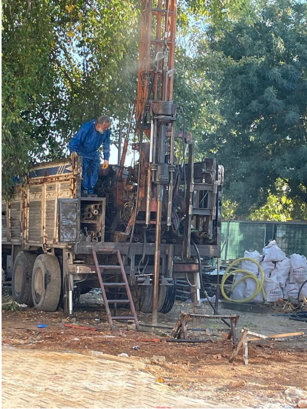
Şekil 2.3. Tarihi yapı civarında yapılan sondaj çalışmaları
