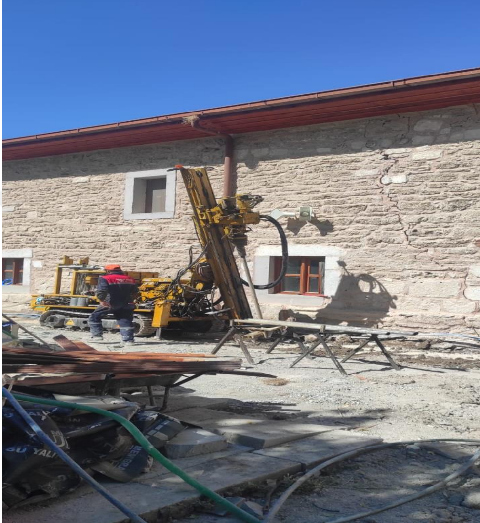
Şekil 4.33. Batı Cephesinde uygulanan eğimli enjeksiyon örneği
