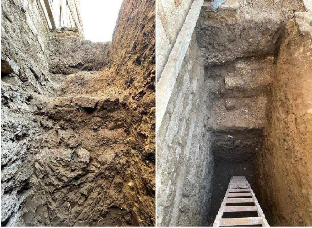
Şekil 2.1. Tarihi bir yapı etrafında muayene çukuru açılması (Konya Şerafettin Cami payanda temeli)
