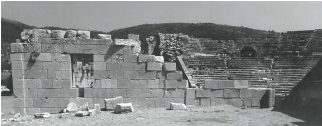
Şekil 4.9. Sahne yapısı batı cephesi dış görünüm
