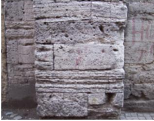
Şekil 3.13. Sıfır derz taş duvar
