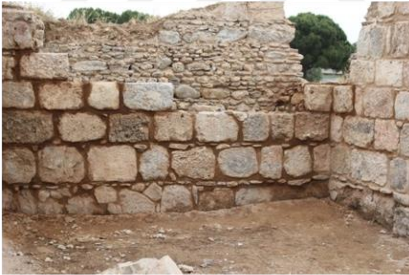
Şekil 3.12. Kaba yönlü taş duvar
