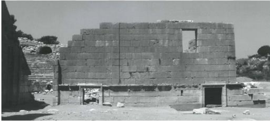
Şekil 4.11. Sahne yapısı doğu cephesi dış görünüm
