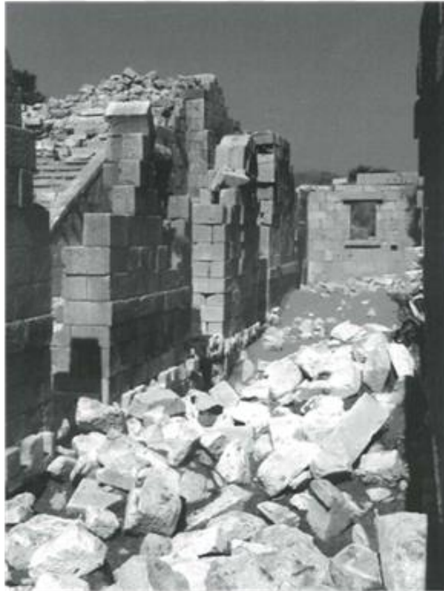
Şekil 4.6. Sahne yapısı güney cephesi iç görünüm
