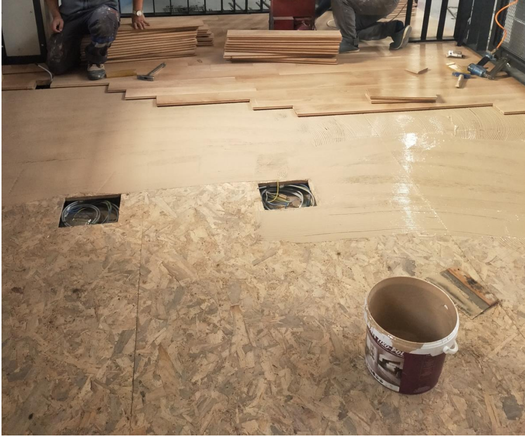
Görsel 53: Asma Kat Zemin Malzemesi, Proje Şantiye Şefi Murat Karşlı
