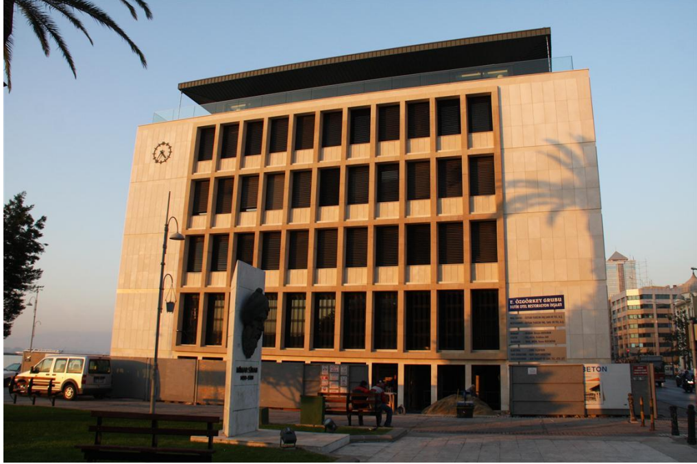
Şekil 5.48 Eski Merkez Bankası binası.
