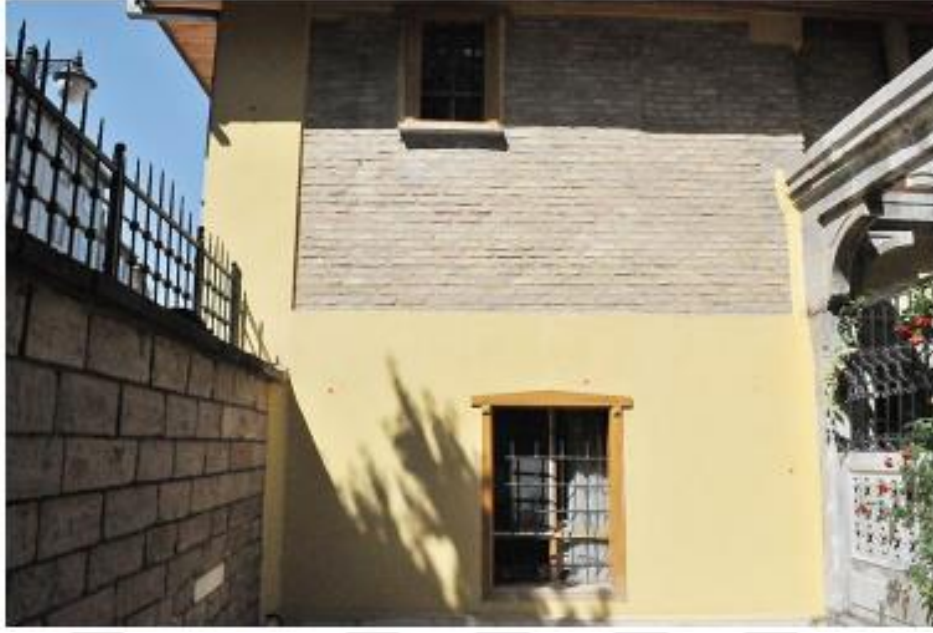
Şekil 8. 16. Şeyh Sadreddin Konevi Cami doğu cephesi tuğla duvar
