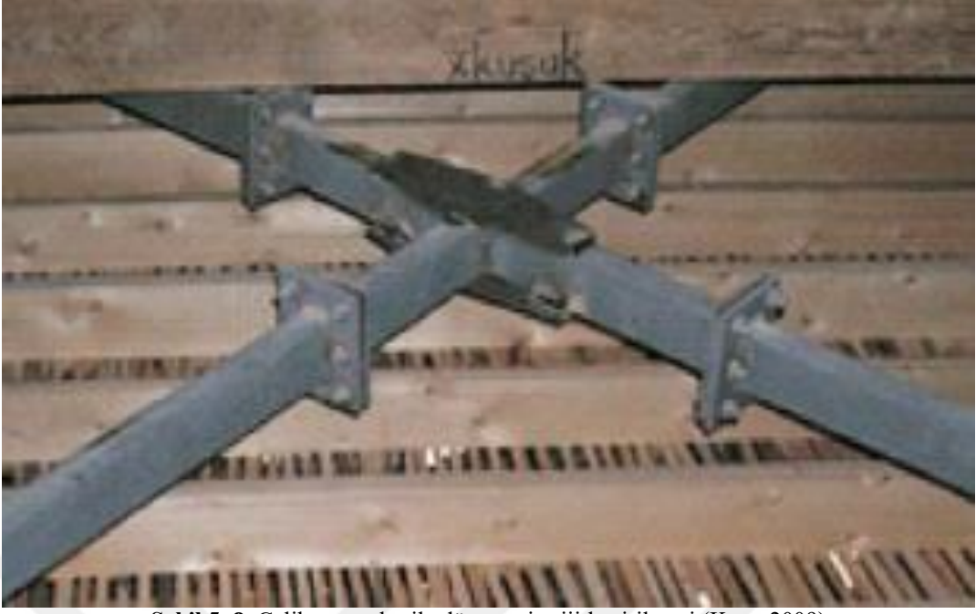
Şekil 5. 8. Çelik çaprazlar ile döşemenin rijitleştirilmesi (Kara, 2009)
