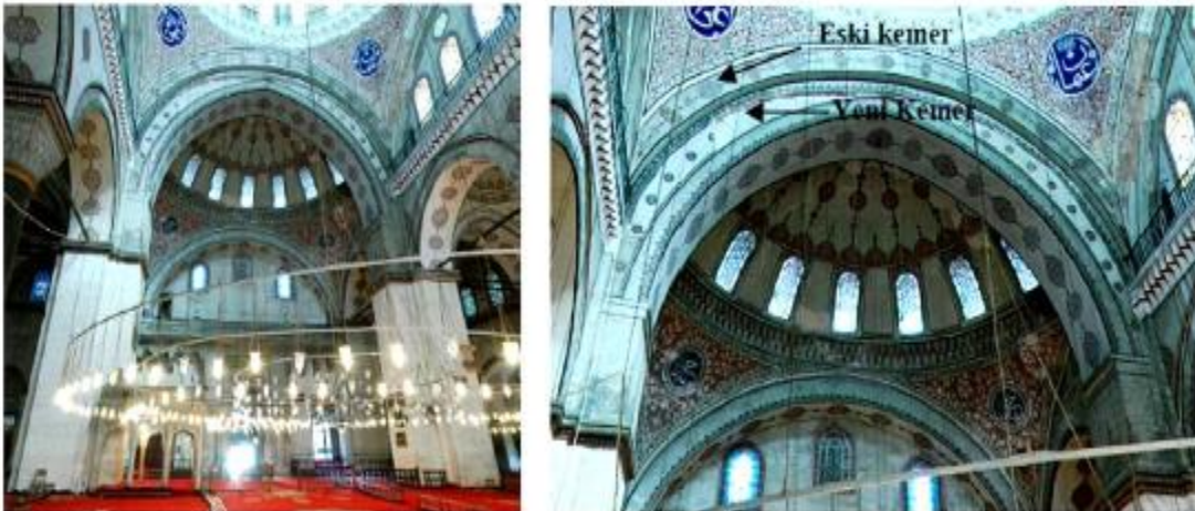
Şekil 5. 5. İstanbul II. Beyazıt Camii kemerinde Mimar Sinan tarafından yapılan güçlendirme (Şişik, 2017)
