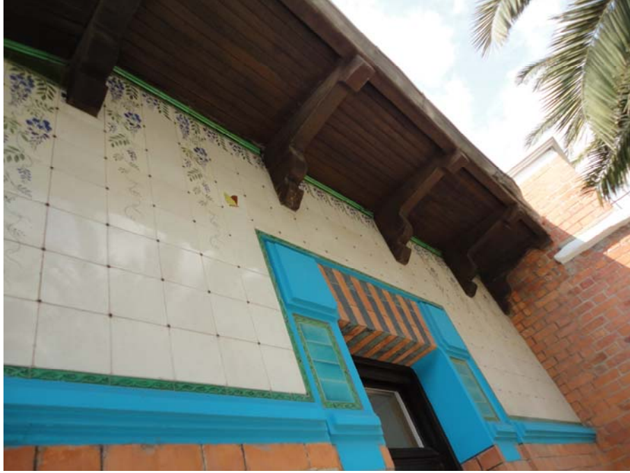
Şekil 3.16 Saçak ve seramik cephe kaplamalarından detay.
