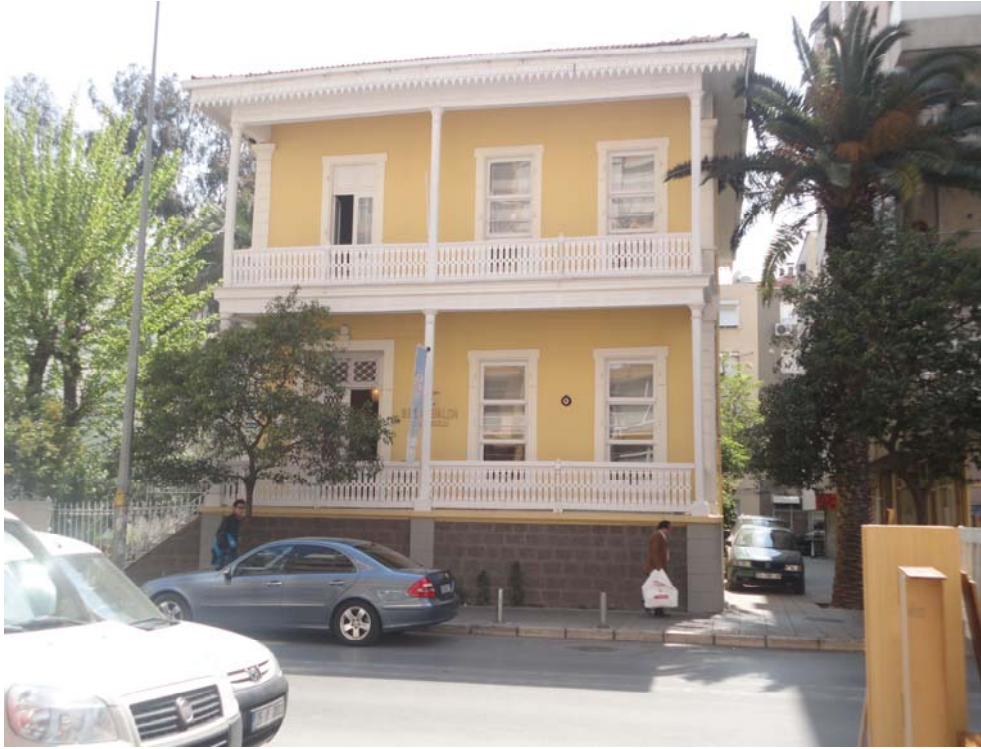
Şekil 3.24 Onarım sonrası yapı
