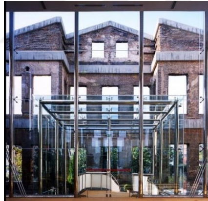
Şekil 4.50 Düşey sınırlayıcılar üzerindeki camekanın yansıma etkisi, Esmâ Sultan Yalısı ( https://www.gadarchitecture.com/ )
