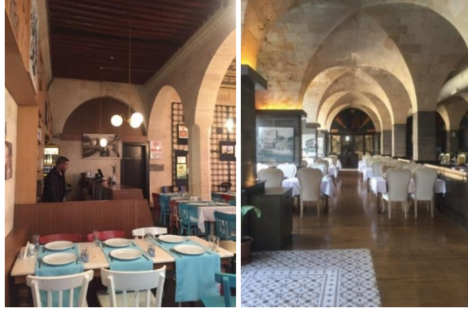
Şekil 5.6 Önem derecesine göre farklı sistem ve malzemeye örtülü tavanlar; soldaki şekil işleviyle meyhane, sağdaki şekil yeni işleviyle restoran bölümü
