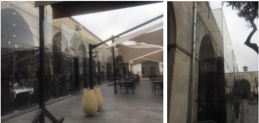
Şekil 6.90 Güney kanattaki revaklı alanın şeffaf camlarla dışarıya, avluya taşırılması, Hışvahan
