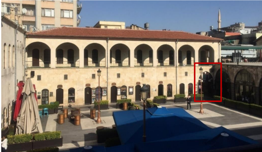
Şekil 6.109 Yapı merkezinde olmayıp uç kısımda yer alan iki taraftaki merdivenlerden doğu kanatta bulunan, Bayazhan
