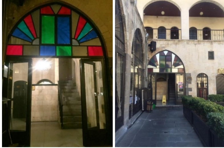
Şekil 6.110 Yapının doğu ve batı kanadının en ucundan bulunan merdivenlerden batı kanattaki ve yapının boyutuyla karşılaştırılması, Bayazhan
