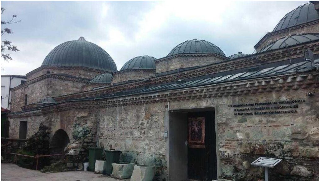
Resim 2.26. Davut Paşa hamamı genel görünüm
