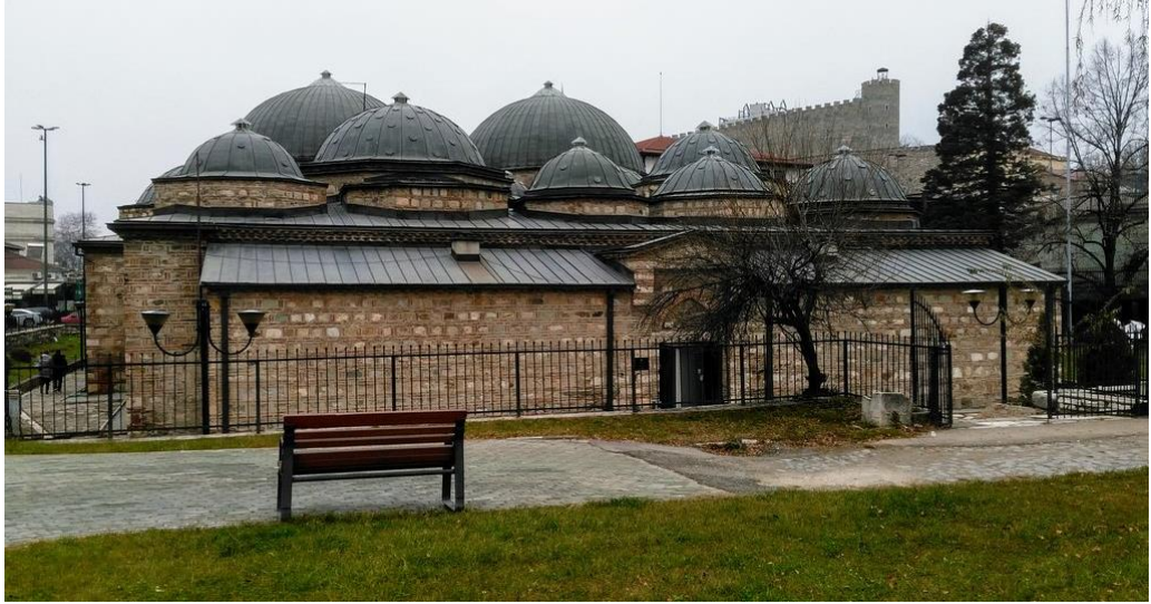
Resim 2.31. Davut Paşa hamamı genel görünüm
