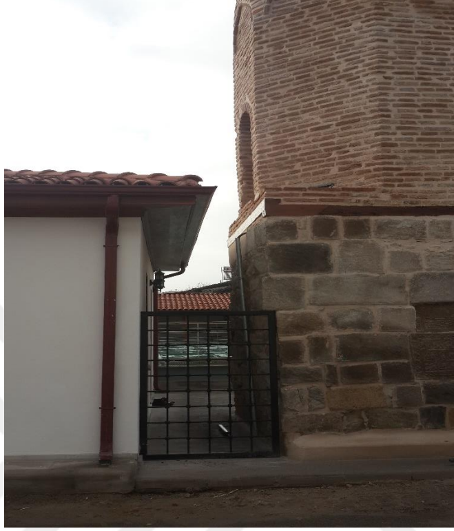
Şekil 3.4: Restorasyon çalışmaları sonrasında Tarihi Sunullah Melik Camisi ve Minaresinin birleşim bölgesi.
