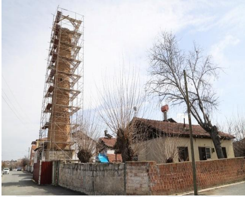
Şekil 3.5: Sunullah Melik Camii Minaresinde yapılan restorasyon çalışmaları [20].
