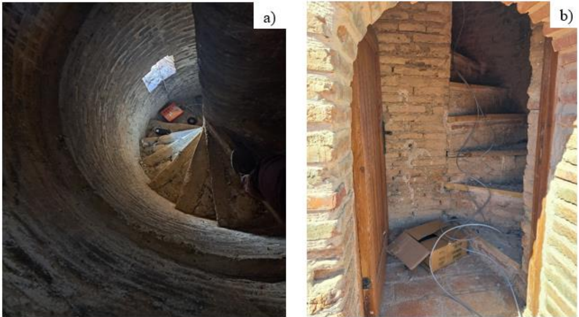
Şekil 4.3: Minarenin farklı bölgelerine ivmeölçerlerin yerleştirilmesi.
