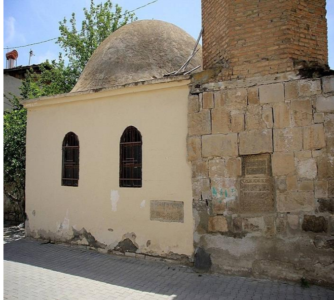
Şekil 3.3: Restorasyon çalışmaları öncesinde Tarihi Sunullah Melik Camisi ve Minaresinin birleşim bölgesi [18].
