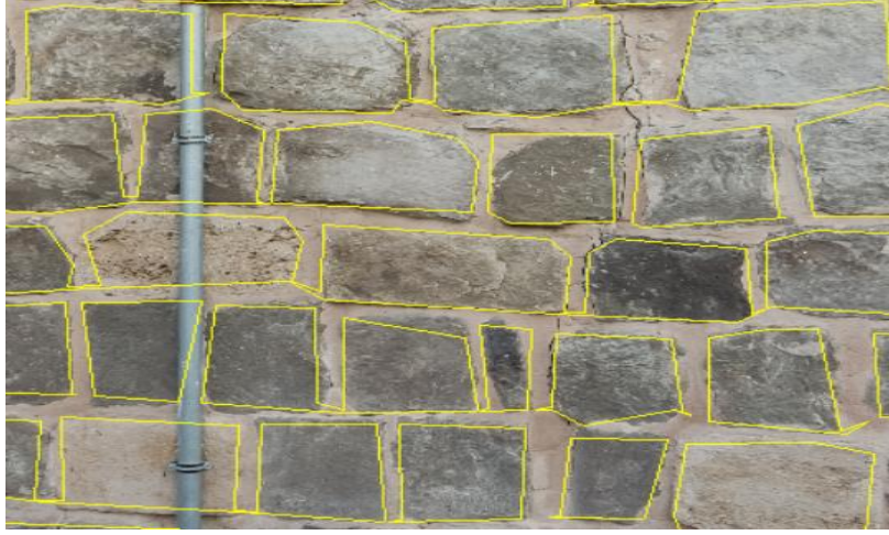
Şekil 5.5: Görüntü işleme ile doğal taş ve harç oranlarının belirlenmesi (%).
