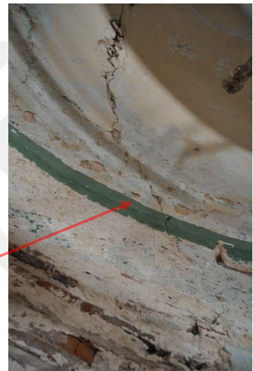
(d) Dome-drum-west wall
