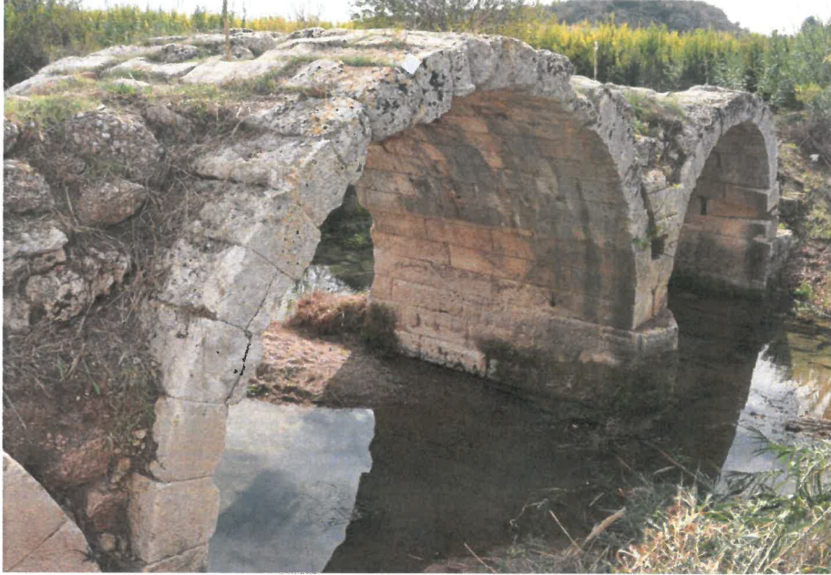
Şekil 4.1. Ayvalıkemer (Sillyon) köprüsü memba yönü
