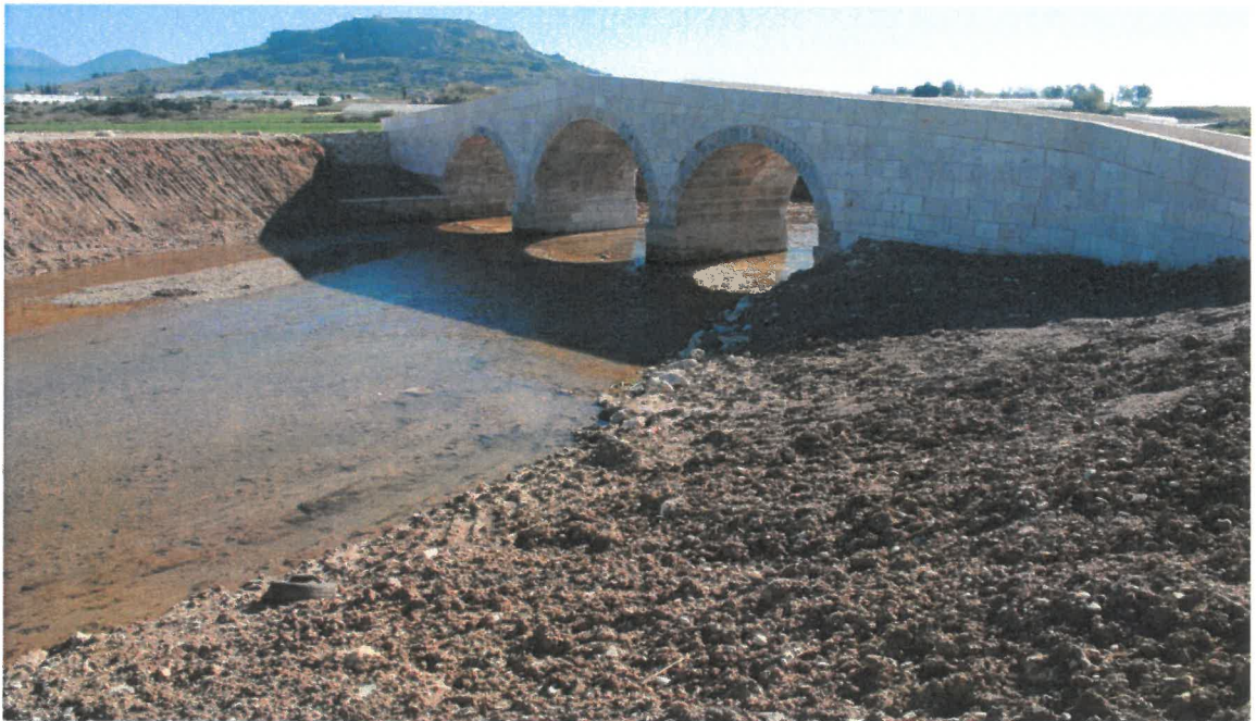
Şekil 4.10. Ayvalıkemer (Sillyon) köprüsü memba yönü restorasyon uygulaması
