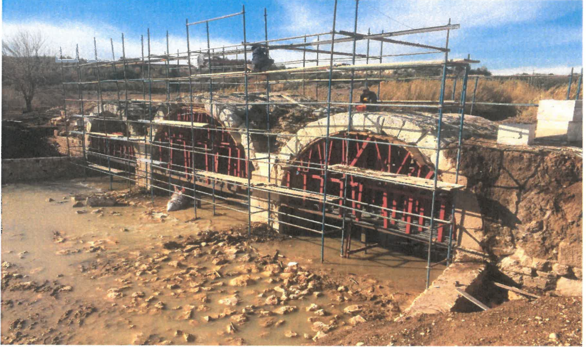
Şekil 4.9. Ayvalıkemer (Sillyon) köprüsü mansap yönü restorasyon uygulaması
