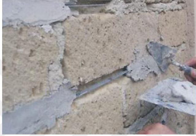
Şekil 1.30. Donatı ile derz güçlendirme uygulaması (Kara, 2009).
