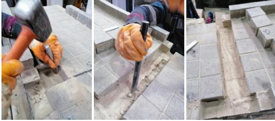
(a) Hasarlı bölgelerin açılması işlemleri
