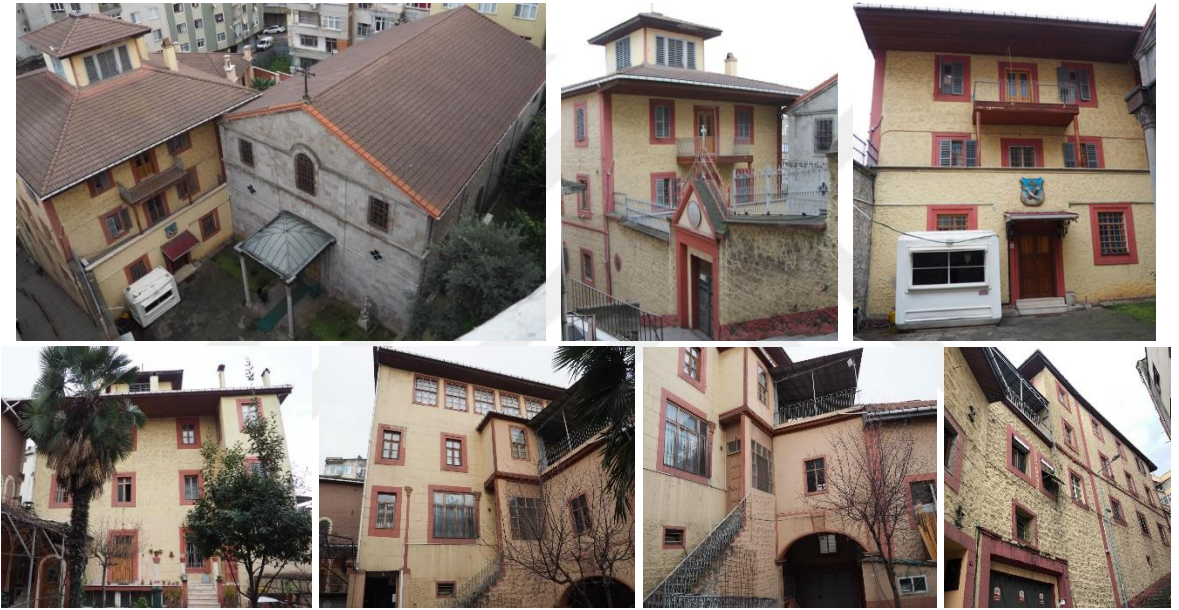
Şekil 2.45. Misafirhane binasına ait görünüşler
