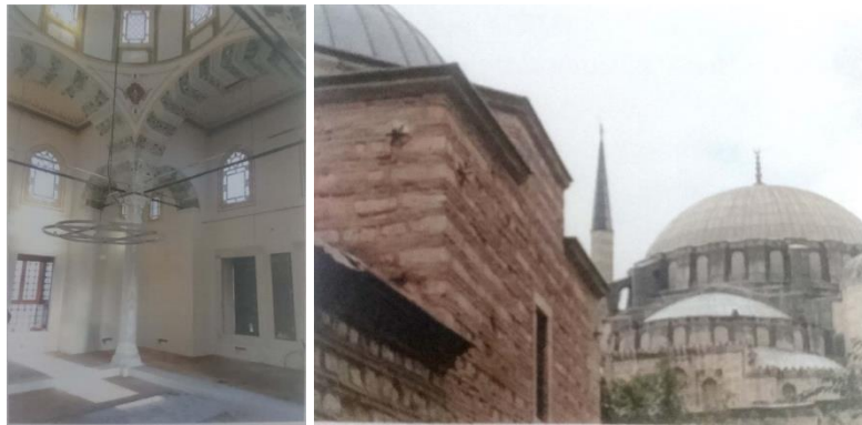
Şekil 1.32. Nevşehirli Damat İbrahim Paşa Külliyesi ve I. Mahmut Kütüphanesi yapılarında öngerme çubukları (Ahunbay, 2019).
