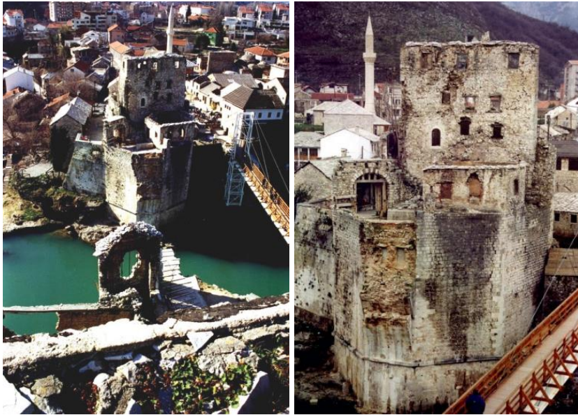
Şekil 1.24. Bosna Savaşı sırasında hasar gören Mostar Köprüsü (Colak, 2016).
