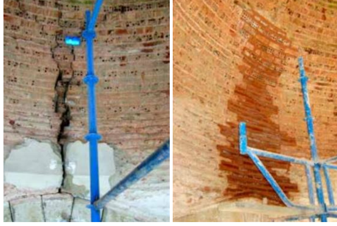
Şekil 1.27. Fatih Camii (İstanbul) kubbesindeki çatlakların onarımı (Ceylan ve Ocakcan, 2013).
