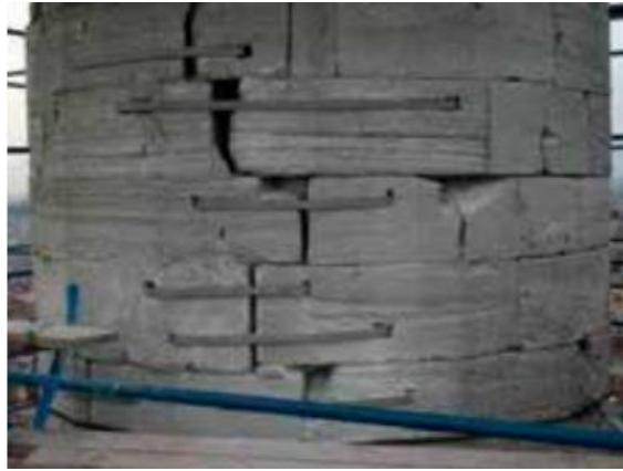
Şekil 1.28. Fatih Camii minaresinde dikiş yöntemi uygulaması (Çılı ve Yıldız, 2013).
