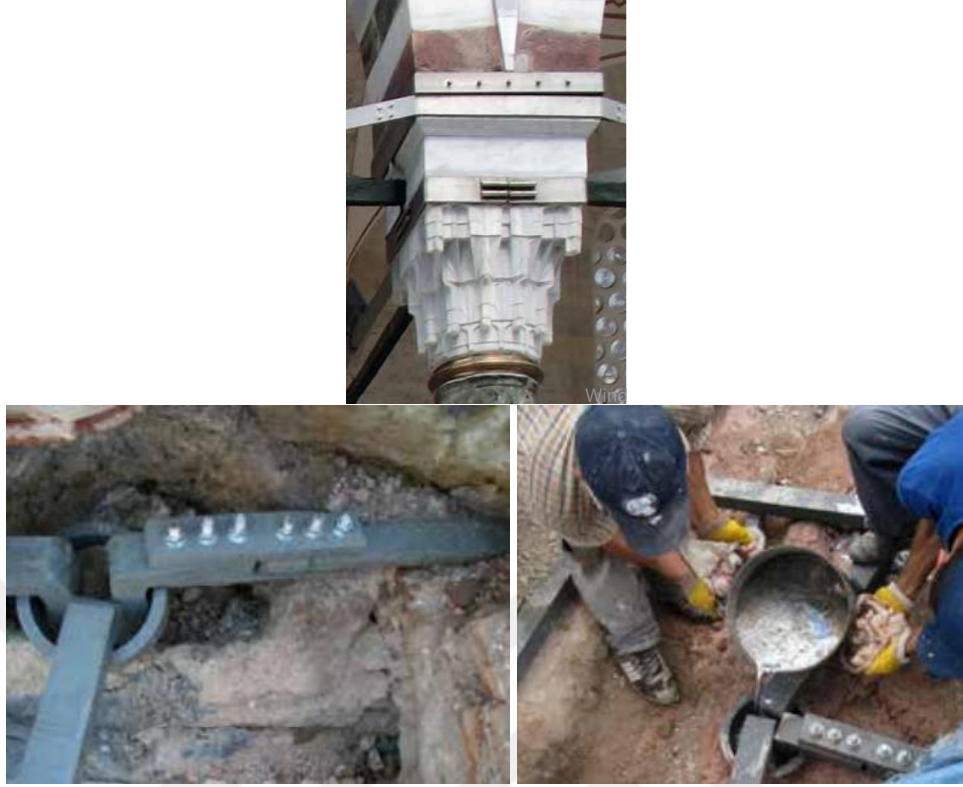
Şekil 1.31. Fatih Camii sütun başı gergi sistemi, duvar içi gergi sistemi birleşim detayı ve kurşun ile dolumu (Çılı ve Yıldız, 2013).
