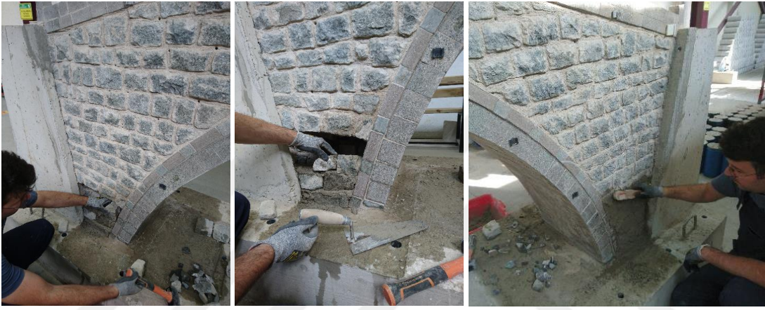
(b) Tempan duvarların tamamlanması
