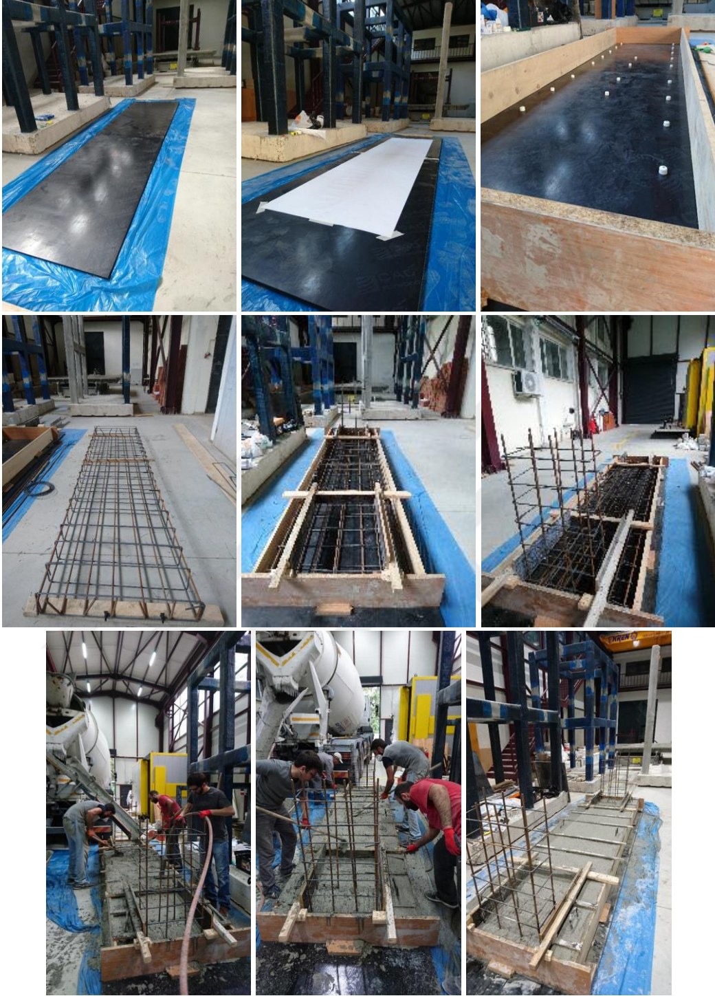
Şekil 2.69. Temel kalıbının hazırlanması ve beton dökümüne ait fotoğraflar
