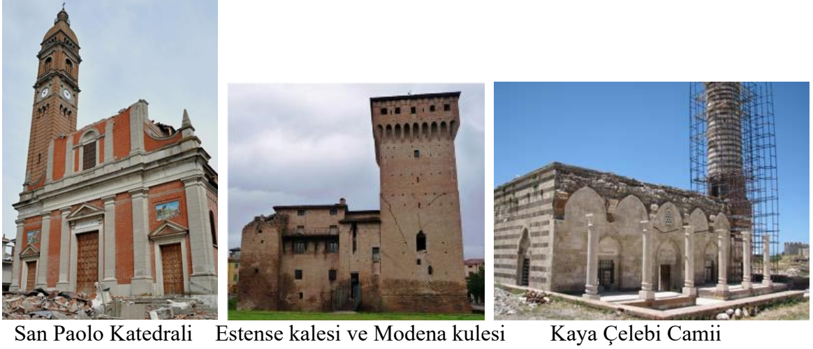
Şekil 1.22. Depremlerden hasar görmüş tarihi yapı örnekleri (Parisi ve Augenti, 2013; Altunışık vd., 2016a).
