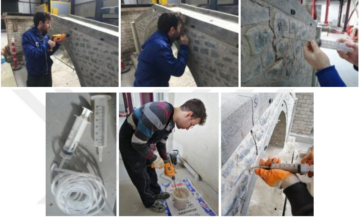
Şekil 2.83. Enjeksiyon işlemlerine ait görünüşler
