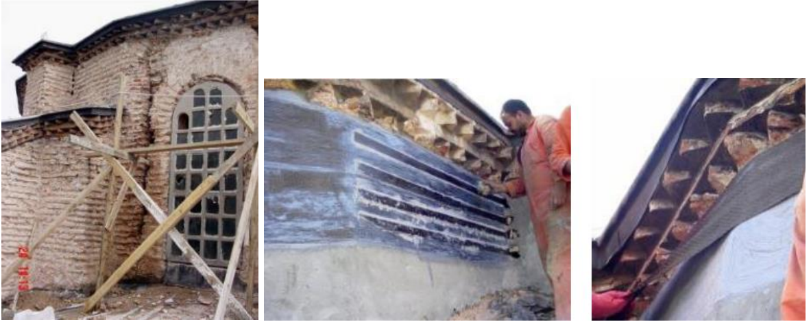
Şekil 1.37. Küçük Ayasofya Cami Kubbe kasnağında FRP uygulaması (Güler vd., 2004).
