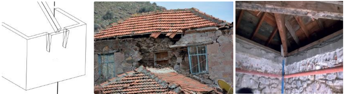
(b) Yanlış uygulama örneği, gerçek hasar durumu ve çatı elemanlarının hatıla mesnetlenmesi
