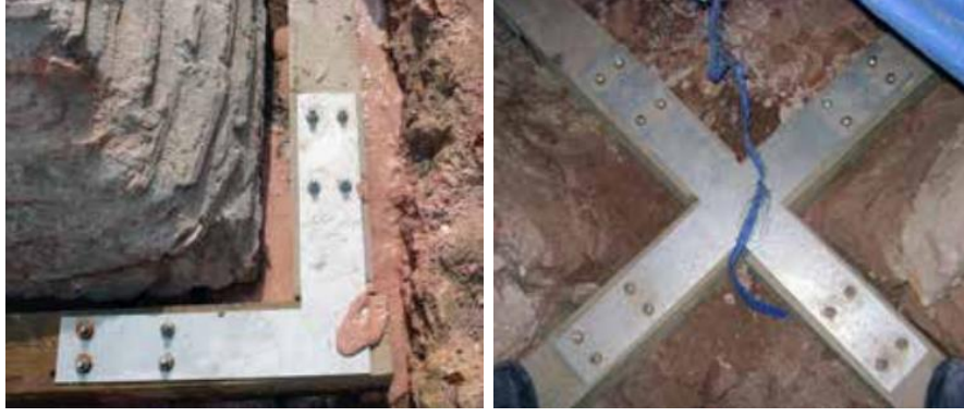
Şekil 1.34. I. Mahmut Kütüphanesi tonoz çevresi ahşap hatıl sistemi (Çılı ve Yıldız, 2013).
