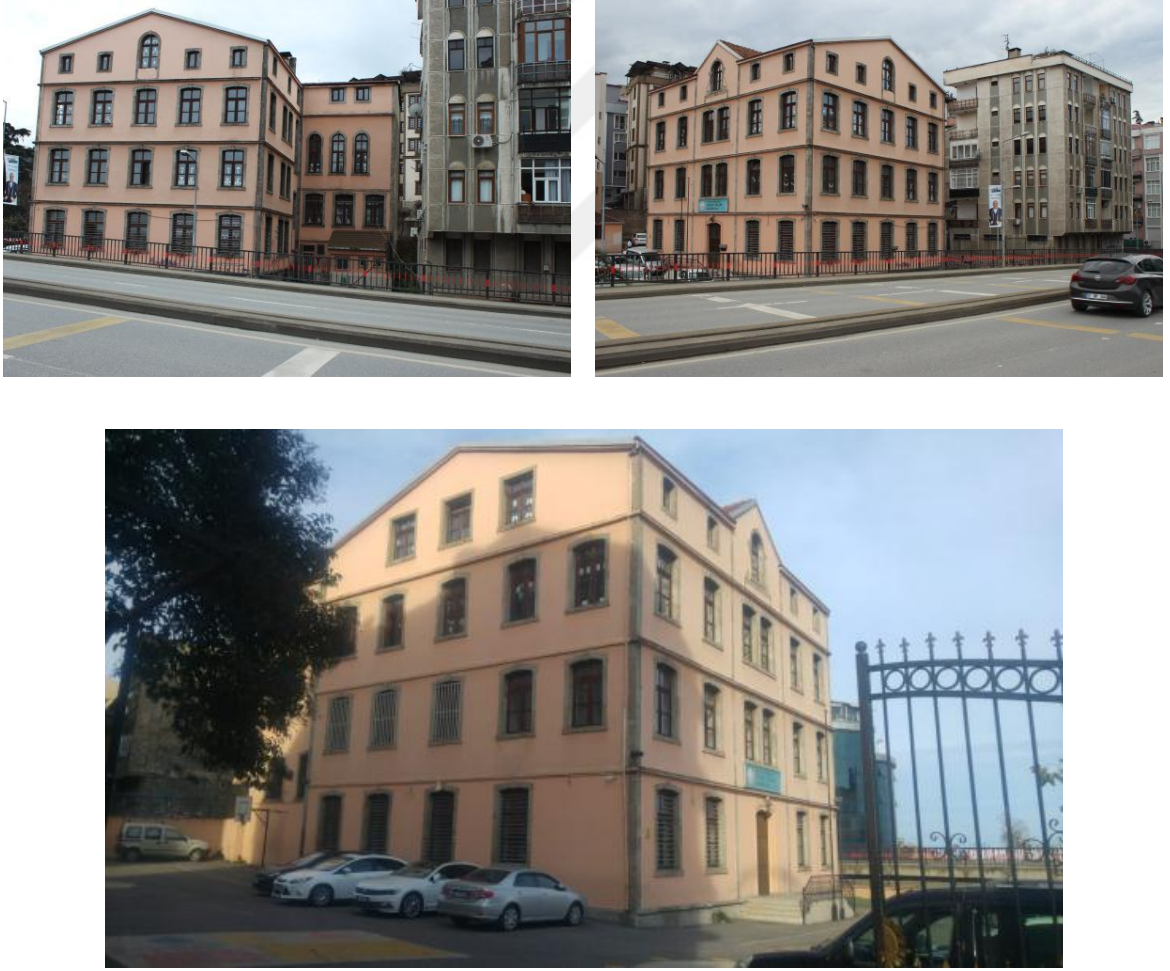
Şekil 2.20. Yavuz Selim Okul Binası’na ait bazı görüşler
