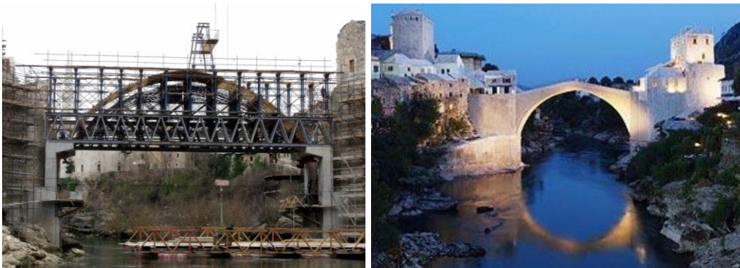
Şekil 1.40. Savaşta yıkılan Mostar Köprüsü'nün yeniden yapımı (Colak, 2016).
