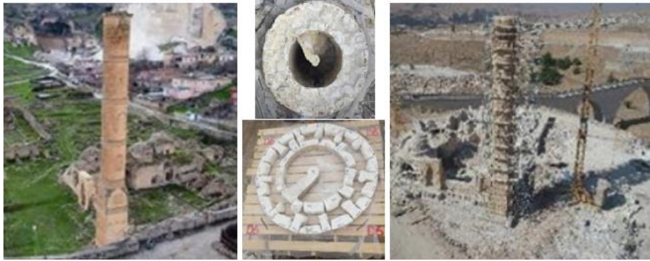
Şekil 1.41. Süleyman Han Camii minaresi söküm, numaralandırma ve tekrar kurulumu işlemleri (KVMGM Arşivi, (2019-2021)).
