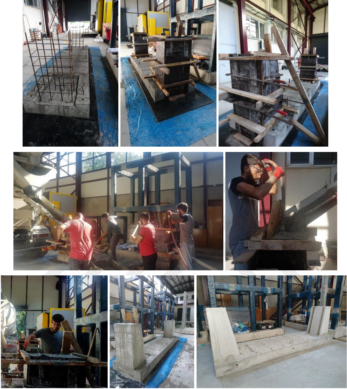
Şekil 2.70. Kenar beton bloklar için kalıp ve beton dökümlerine ait fotoğraflar
