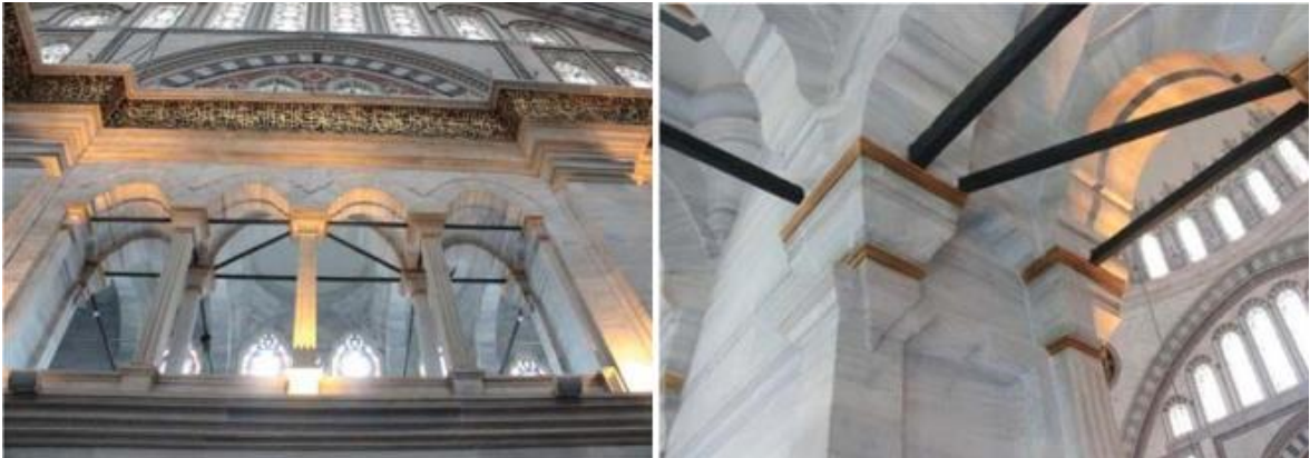
Şekil 1.8. Nur-u Osmaniye Cami demir kuşak seviyeleri ve görünüşleri (Dabanlı, 2016).
