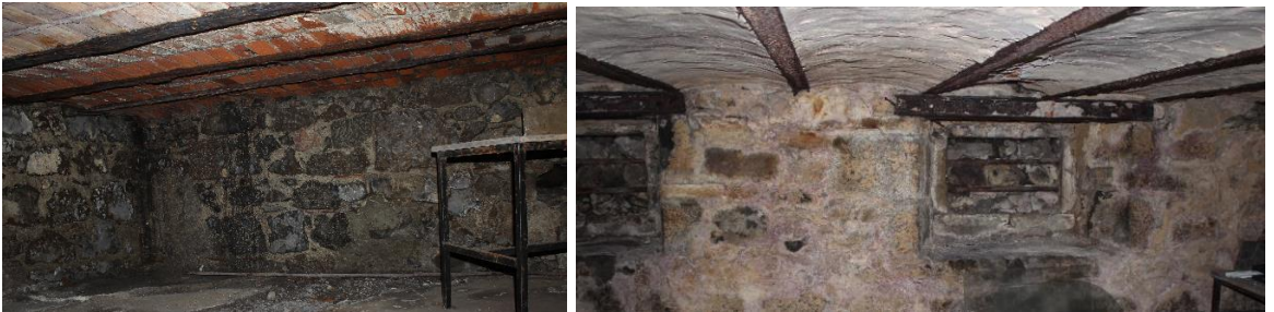
Şekil 1.19. Adi volta döşeme örneği (Trabzon Yavuz Selim Binası)
