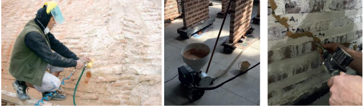
Şekil 1.29. Kubbede (Küçük, 2010) ve duvarlarda enjeksiyon uygulaması (Oktay, 2017).
