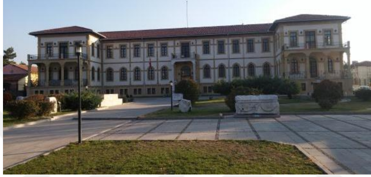
Şekil 1.39. Yangın sonrası yenilenen Çorum Müze binası
