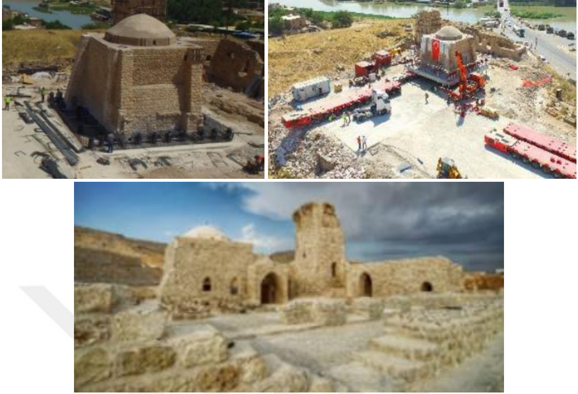
Şekil 1.42. İmam Abdullah Zaviyesi türbe bölümünün bütün olarak taşınması ve yeni konumu görünüşleri (KVMGM ve DSİ Arşivi, (2017-2019)).
