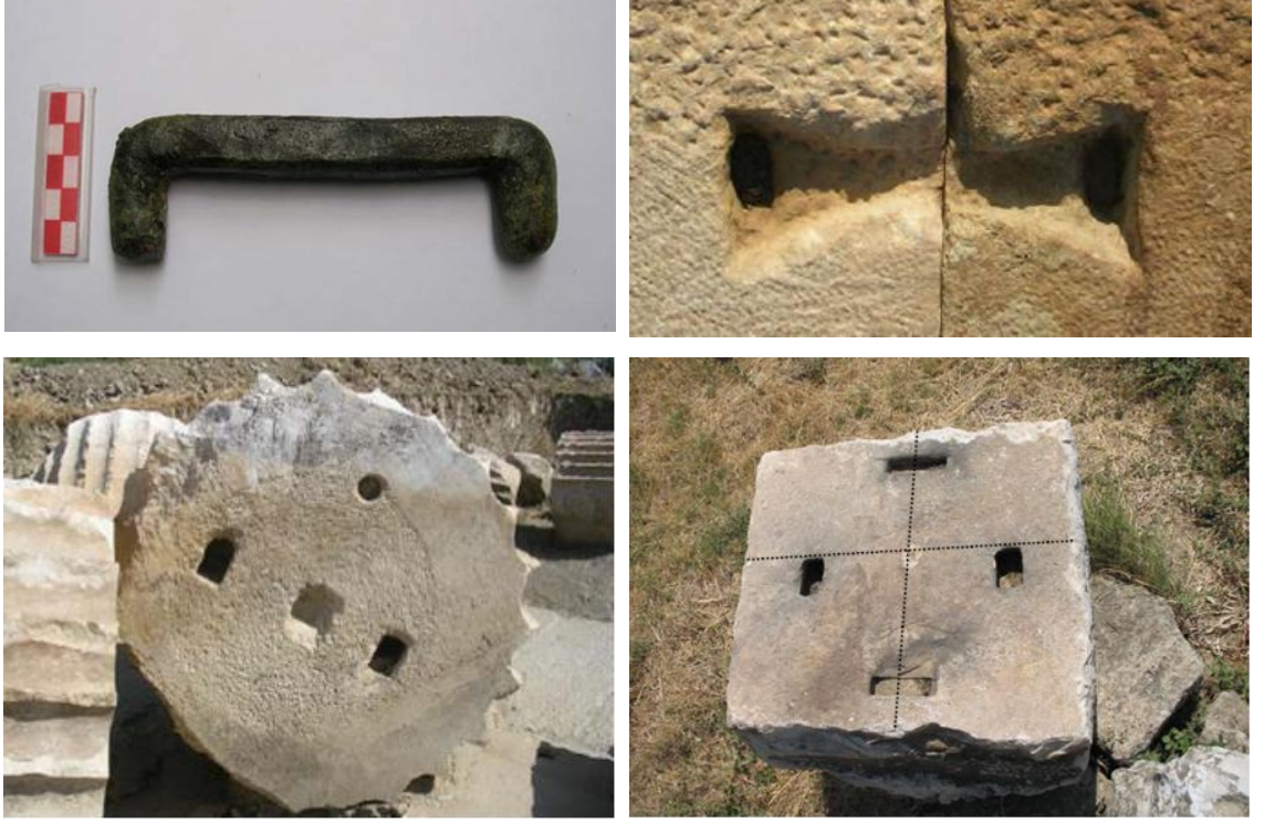
Şekil 2.2. Magnesia Artemis Tapınağındaki metal bağlantı uygulamaları (Demirtaş, 2006)
