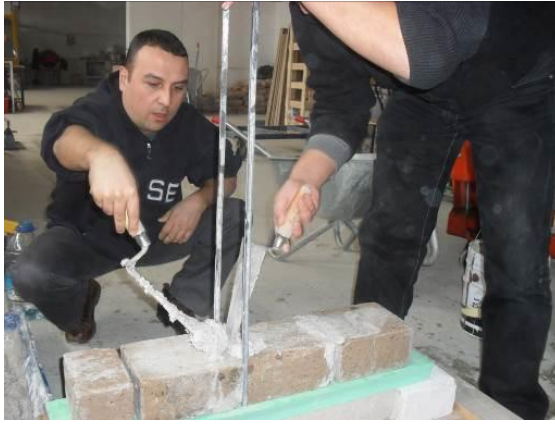
(c) Düşey derzlerin harç ile doldurulması
