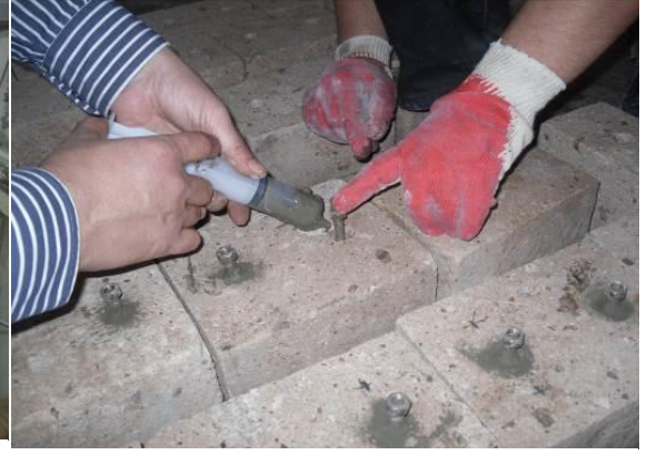
(b) Zıvana deliklerinin çimento şerbetiyle doldurulması
