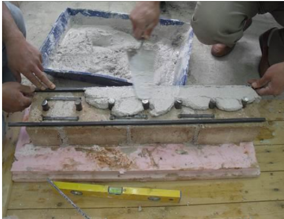
(e) Yatay derzlerin harç ile doldurulması
