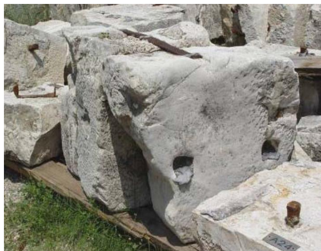
(b) Mostar Köprüsü taşlarındaki metal elemanlar (KGM, 2010)
