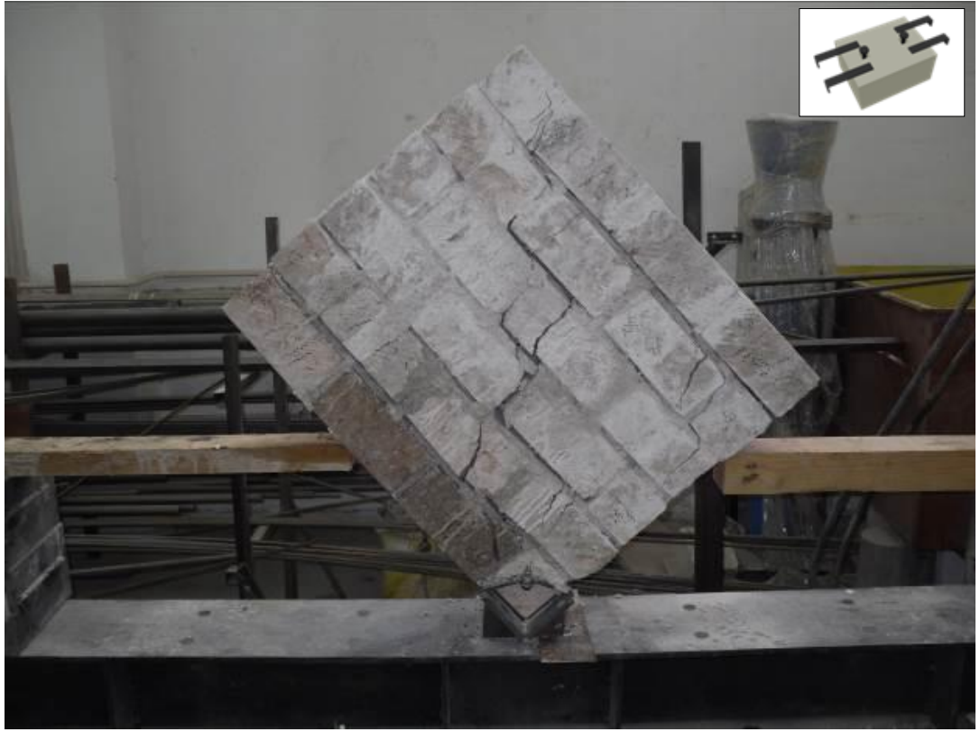
Şekil 4.33. M42 duvar numunesinin deney sonucu görüntüsü
