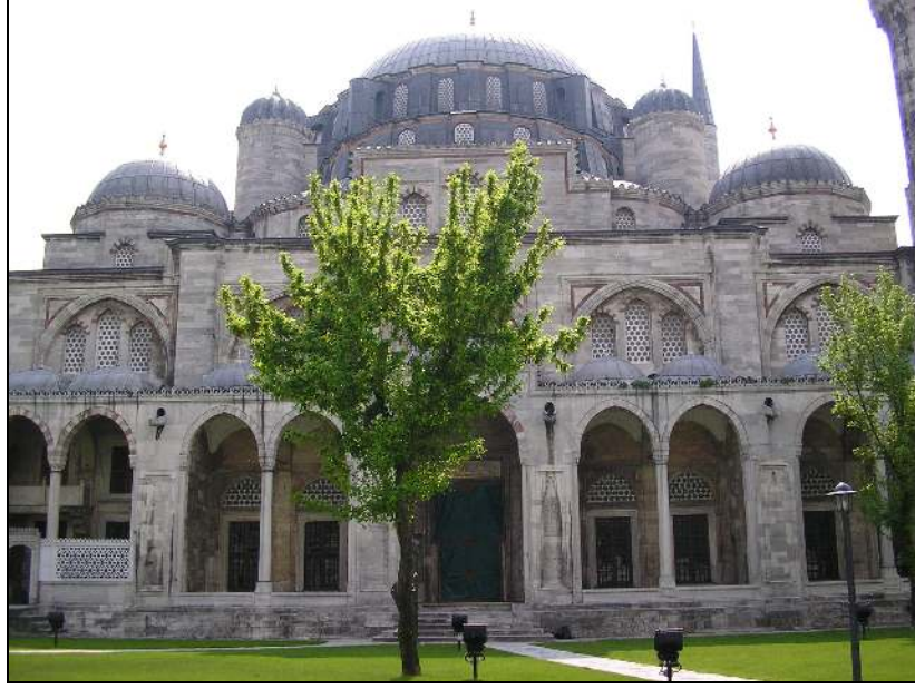
Resim 4. 31. Şehzade M.Camii Revaklı Doğu Cephesi .
