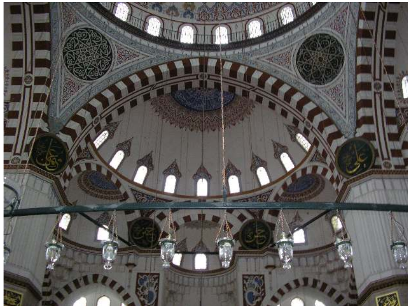
Resim 4. 12. Fil ayaklarına pandantiflerle bağlanan kubbe.
