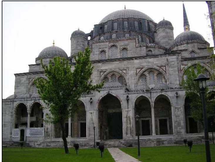
Resim 4. 24. Şehzade M. Camii Revaklı Doğu Cephesi .
