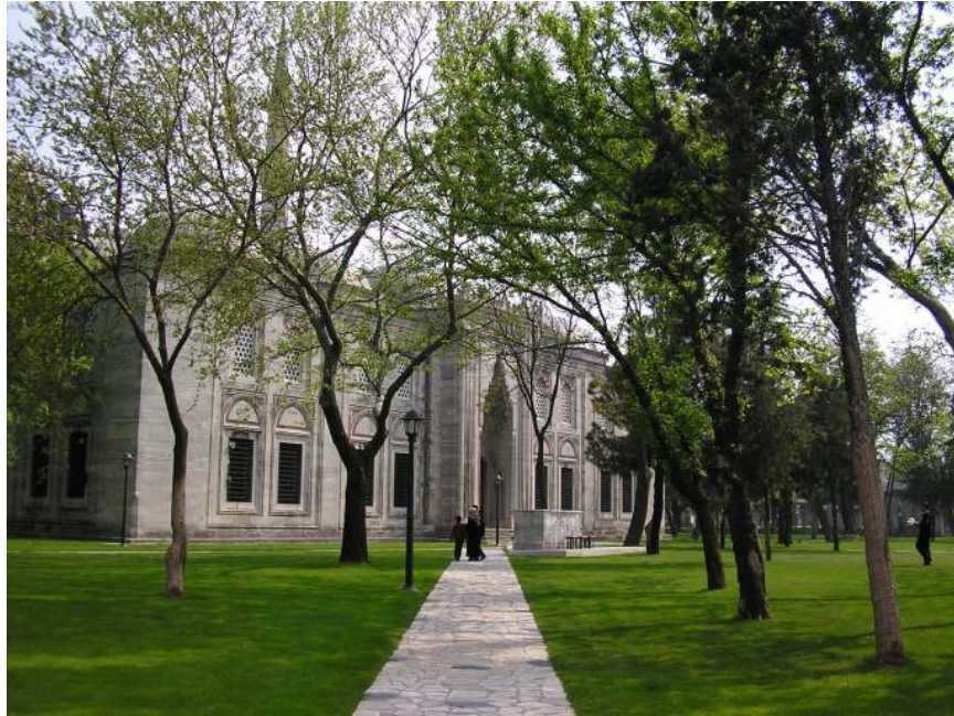
Resim 4. 15. Şehzade M.Camii Kuzey Cephesi
