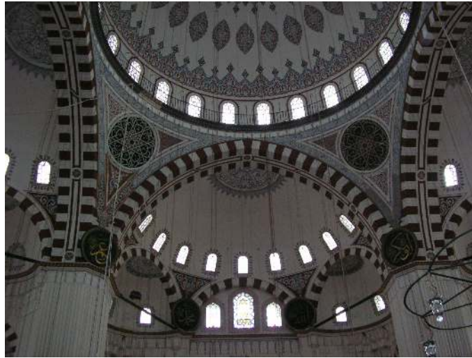
Resim 4. 20. Ana kubbeye geçiş ögesi olarak kullanılan pendantifler ve yarım kubbedeki tromp.
