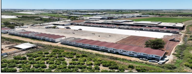
Şekil 4.65. Çandır Mahallesi'ndeki toptancı hali ticari alanı (Anonim 2023b)
