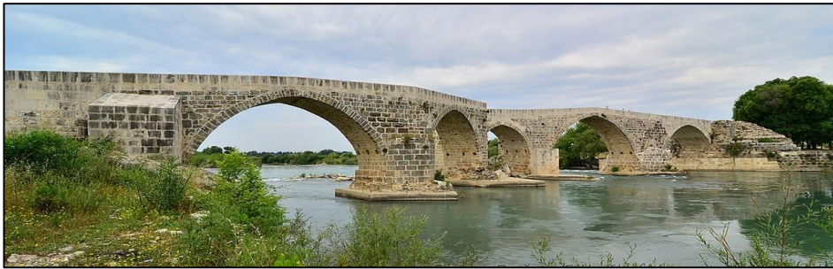
Şekil 4.16. Tarihi Aspendos Köprüsü (Doğan 2016)
