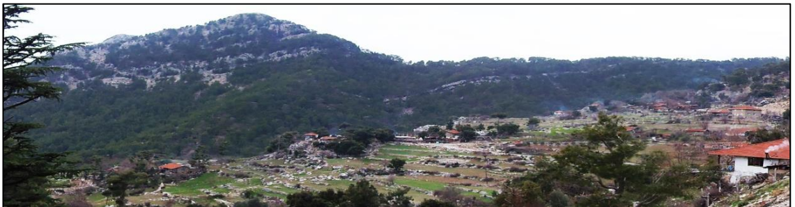
Şekil 4.41. Demirciler Mahallesi taş duvarlı teraslar (Orişinal 2015)
