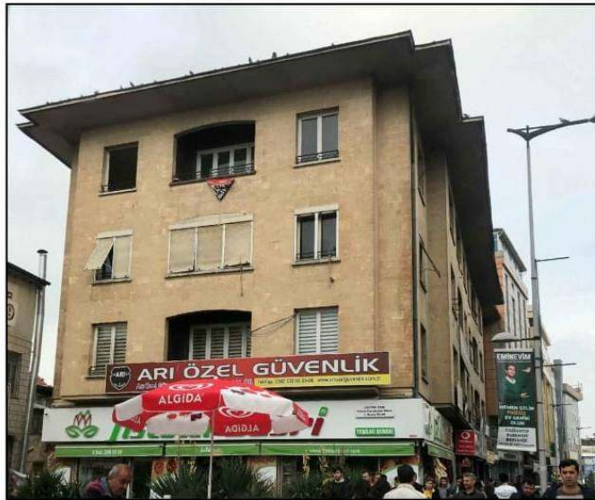
Abdülkadir Göksel Apartmanı Günümüz (Foto: Erbalcı, 2021)
