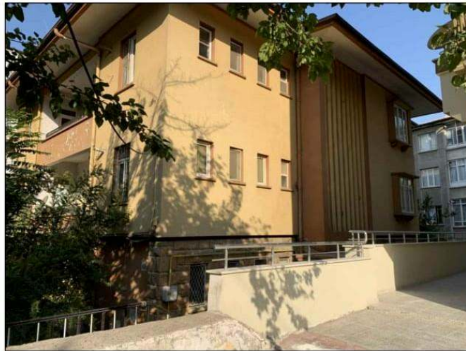
Bahçelievlerde Bulunan Bir Apartman Örneği (Foto: Erbalcı, 2021)
