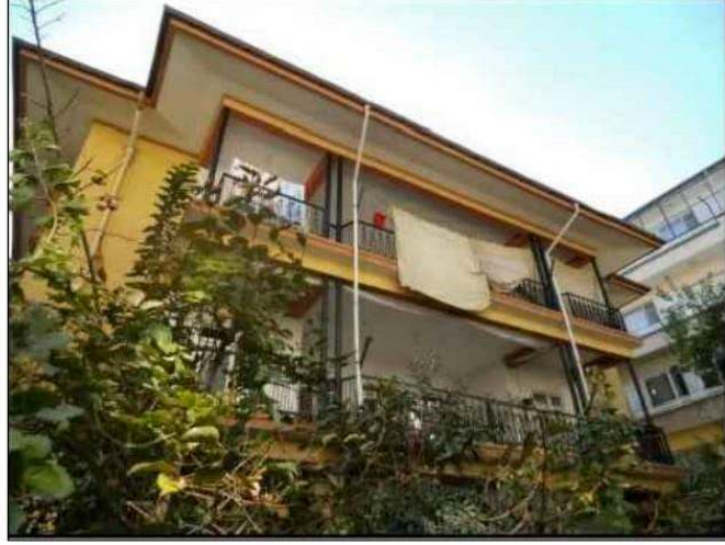
Bahçelievlerde Bulunan Bir Apartman Örneği (Kuyucu, 2019)
