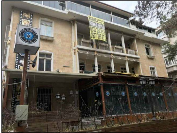
Ömer Ersoy Apartmanı Günümüz (Foto: Erbalcı, 2021)
