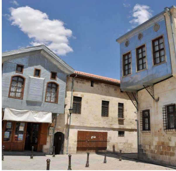
Şekil 3.10: Köşklü Ev (URL-31)
