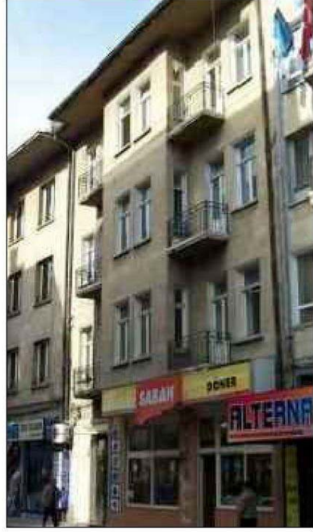
Mahmut Ersoy Apartmanı, 2005 (Özsoy, 2006)
