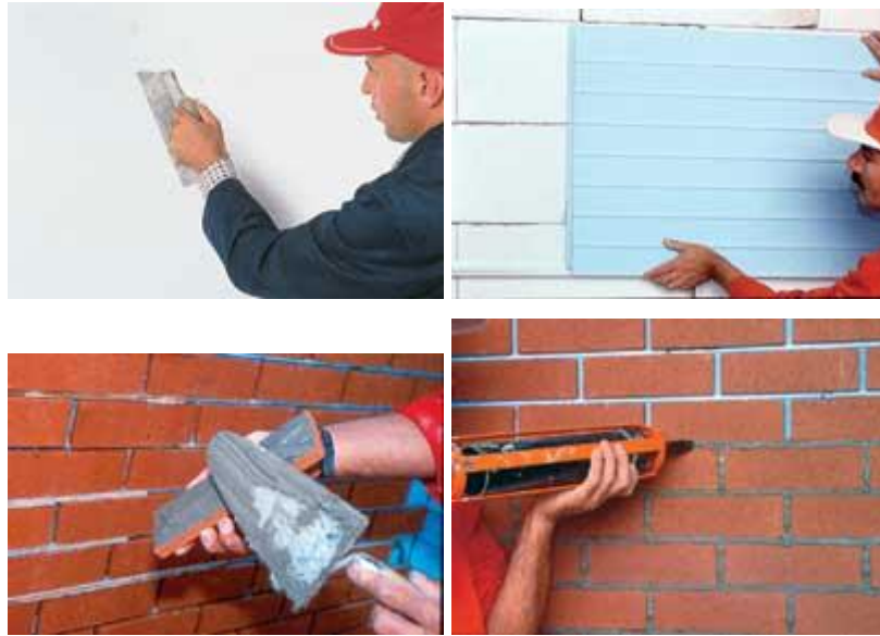
Şekil 3.2 Tuğla kaplama aşamaları ( http://building.dow )
