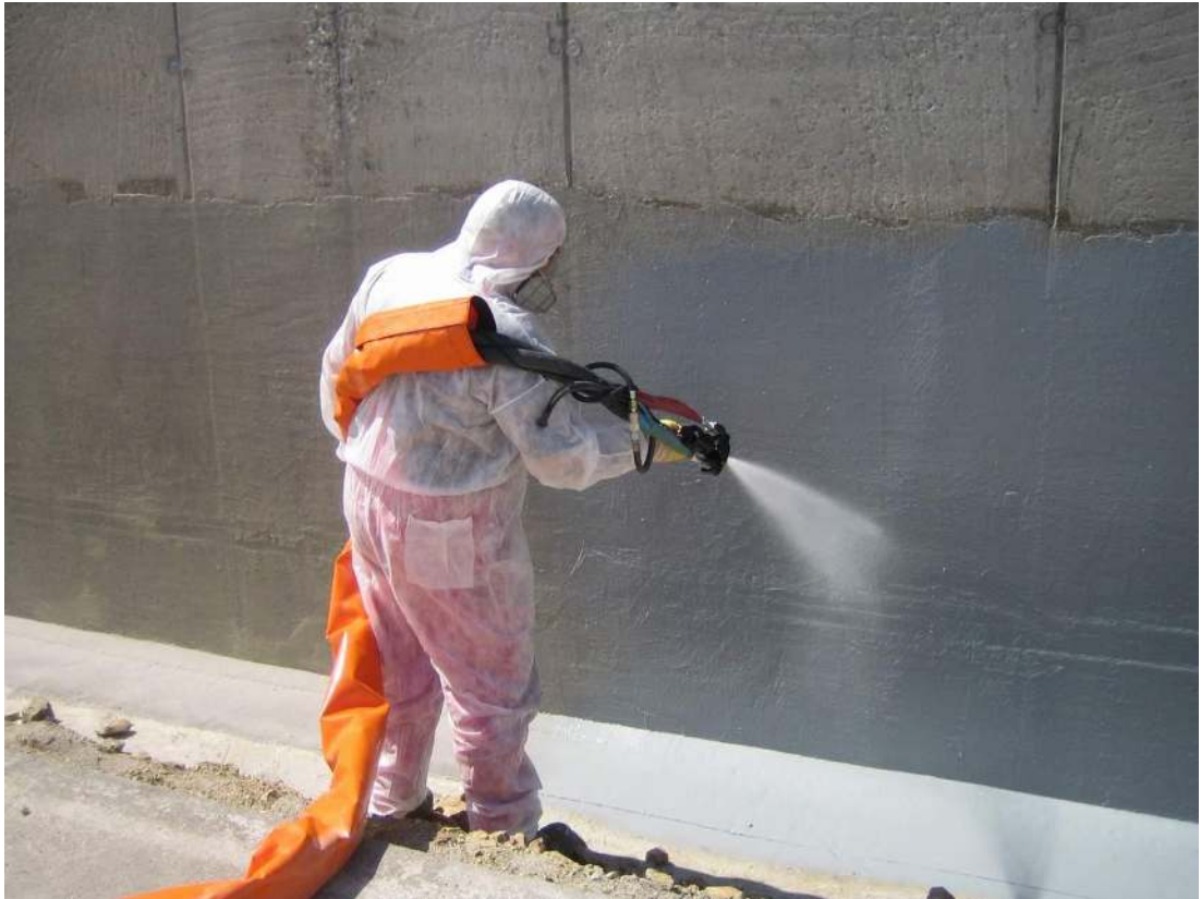
Şekil 3.64 Poliüretan sprej uygulaması ( http://www.putechmagazine.com )
