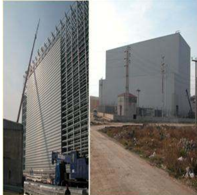
Şekil 3.33 Trapez sac uygulaması. Kaset sistem taşıyıcı + tek kat trapez sac. (İsko – Sanko Hold. Teknoloji Lojistik Depo İnegöl / Bursa http://www.artikelmuhendislik.com )
