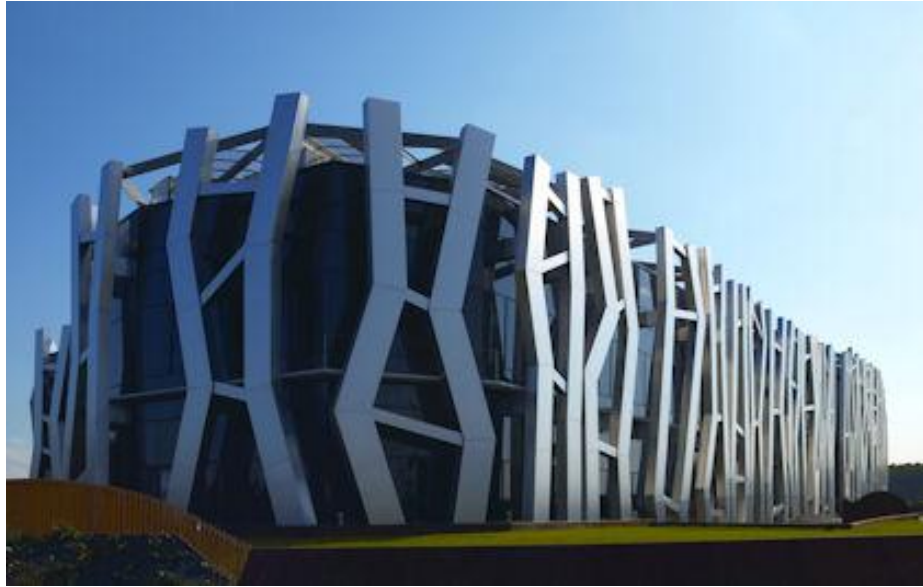
Şekil 3.37 Paslanmaz çelik dış cephe malzemesi kullanımı ( www.raf.com.tr )
