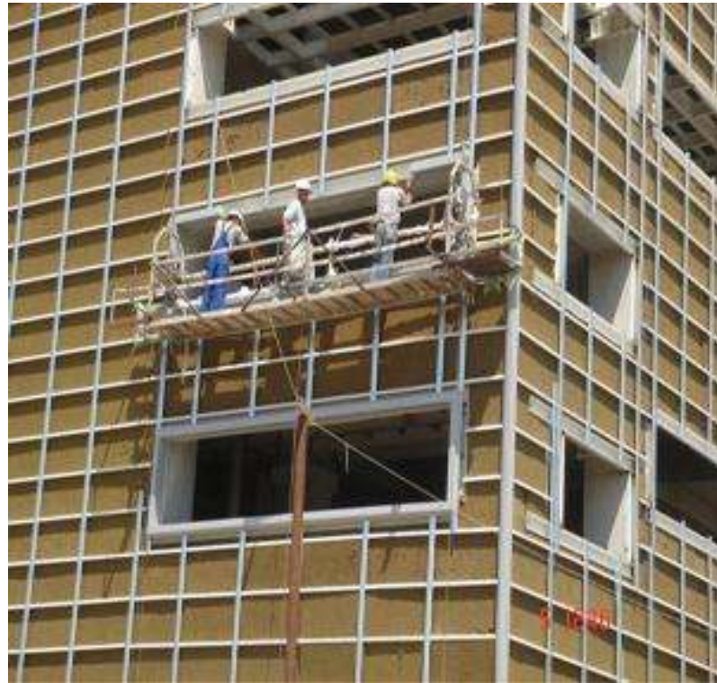
Şekil 3.31 Trapez sac uygulaması. Kaset sistem taşıyıcı + tek kat trapez sac (Polyplex Folyo Fabrikası / Çorlu, http://www.artikelmuhendislik.com )
