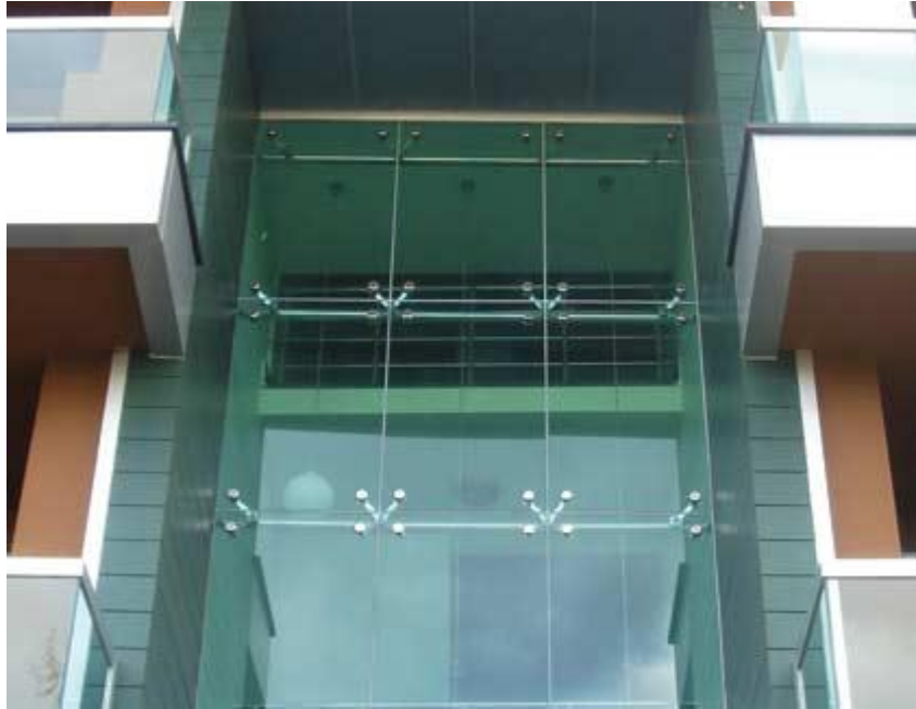
Şekil 3.18 Noktasal bağlantılı sistem giydirmce cephe (discephegiydirmce.net, 2012)
