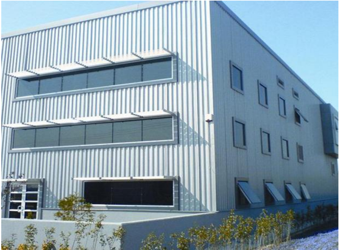
Şekil 3.28 Trapez sac cephe kaplaması örnek (artikelmuhendislik.com, 2012)
