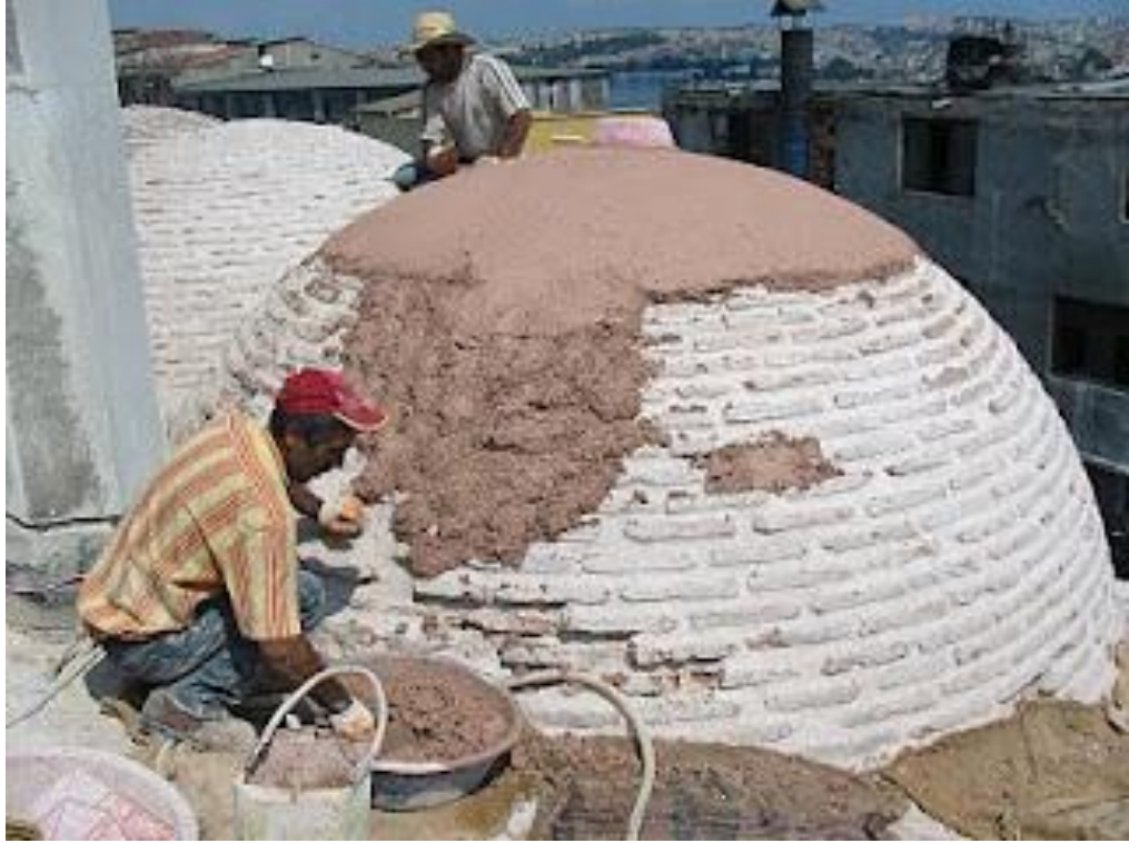
Şekil 2.3 Horasan harcı ile restorasyon çalışması ( http://www.renovanews.com )
