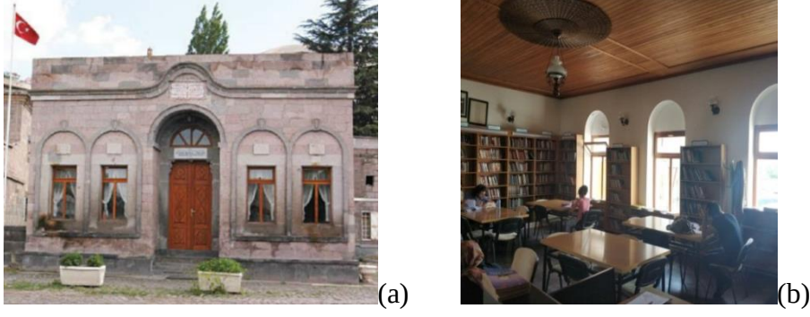
Resim 3.26. Rüştîye Mektebi, 2020 a) Kuzey cephesi b) Ana derslik alanı (kütüphane)
