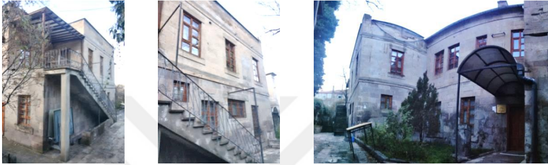
Resim 3.63. Dispanser Binası doğu cephe, 2020
