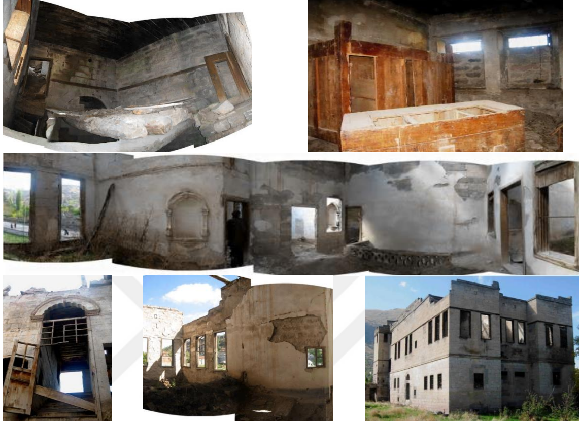
Resim 3.30. Restorasyon öncesi mevcut durum (Ünlüdil, 2018)
