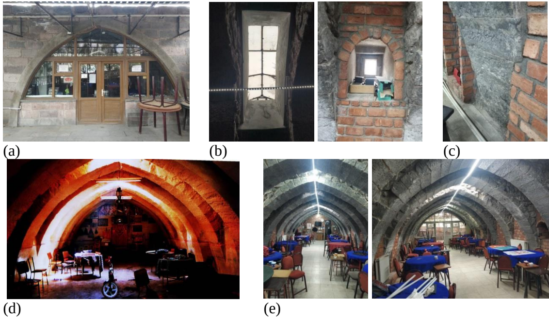
Resim 3.13. Harman Hanı a) Han Giriş b) Tonoz arası ve duvar penceresi c) Üzengi d) 1997 (Türkmen, 1997) e) 2020
