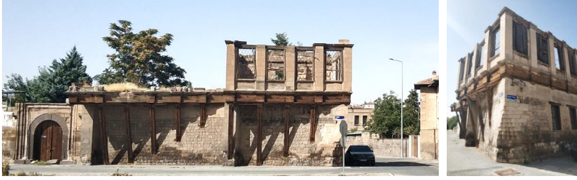
Resim 3.33. Dr. Behçey Bey Evi, 2020 (güney ve doğu cephe)
