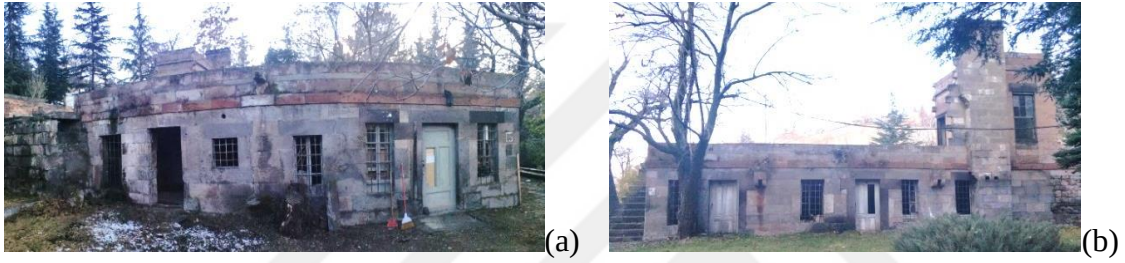
Resim 3.66. Büyük Hastane, 2020 a) Kuzey cephe b) Güney cephe
