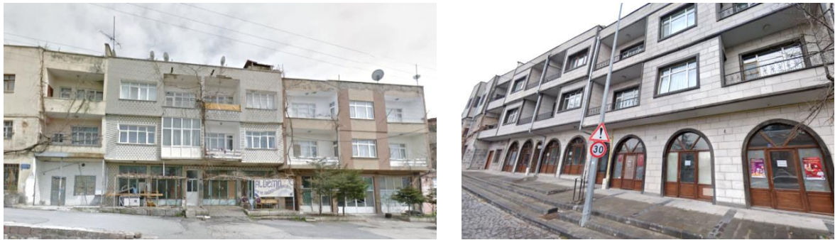
Resim 4.5. Yeni inşa edilen çok katlı niteliksiz yapılar ve makyajlama çalışmaları
