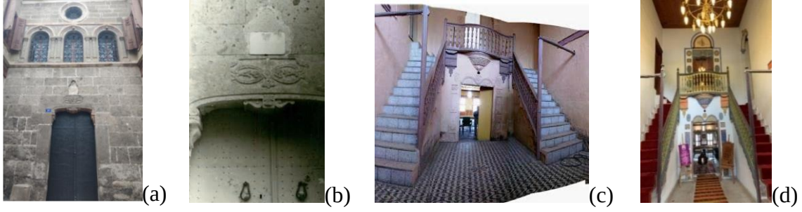
Resim 3.51. H. Ali Kürtüncü Konağı girişi ve giriş holü a) Doğu girişi, 2020 b) Kitabe, 1979 49 c) Giriş (Ünlüdil, 2018) d) Giriş, 2020
