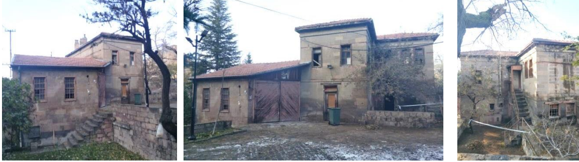
Resim 3.72. Hemşire Evi ve Ahır yapısı güney ve doğu cephe, 2020
