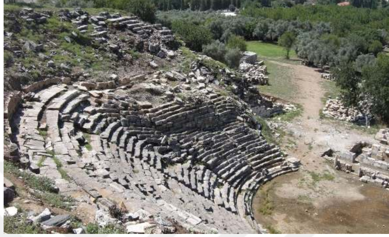
Res. 51. Tiyatro, Batı Bölümündeki Çökme (Url-41)
