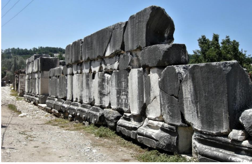
Res. 40. Kuzey Anta Duvarı, Dış Cephe (Url-41)
