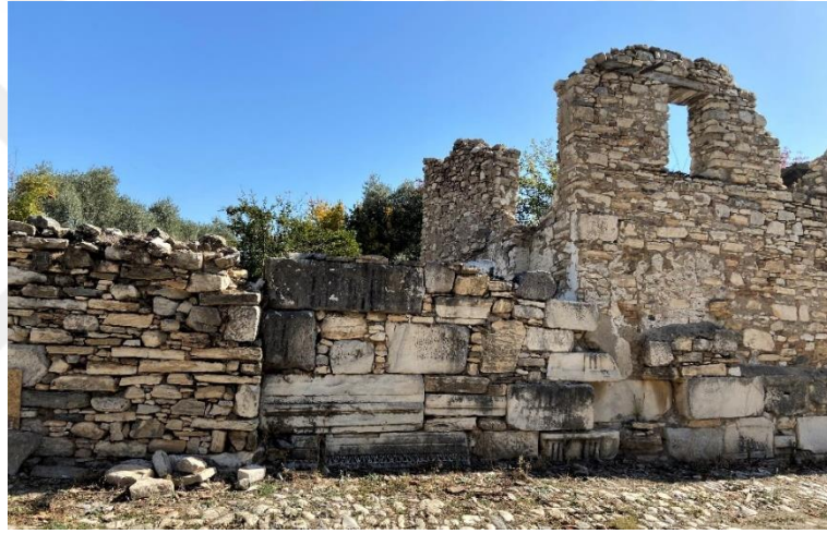
Res. 87. Tuğla Malzemeli ve Mermer Blok Entegreli Cephe Görünümü (Yazarın Arşivinden, 28.10.22)
