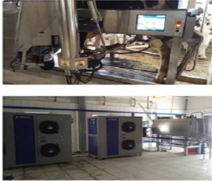
Şekil 72. Robotik sağım sistemi (Laranda Tarım Hayvancılık, 2021).
