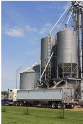
Şekil 2.20. Tahıl silosu (URL-18)
