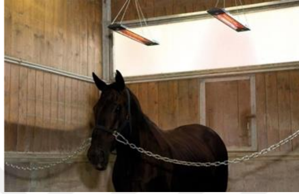
Şekil 4.21. Doğru konumlandırılmış muhafazalı ısıtıcı (URL-32)
