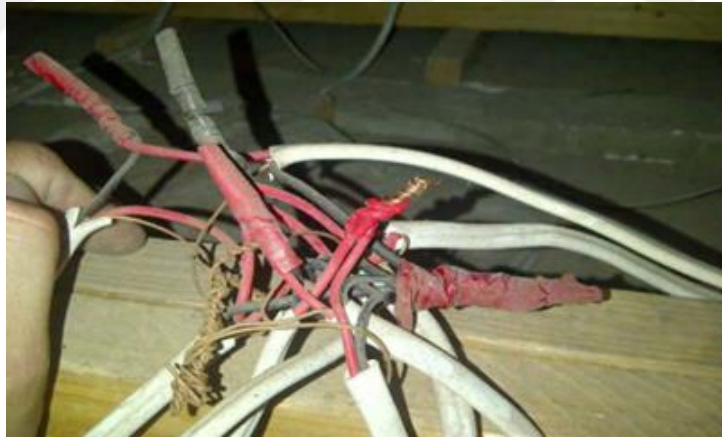
Şekil 4.7. Ahşap malzeme ile temas eden açık uçlu kablo (Keçeci vd, 2022)
