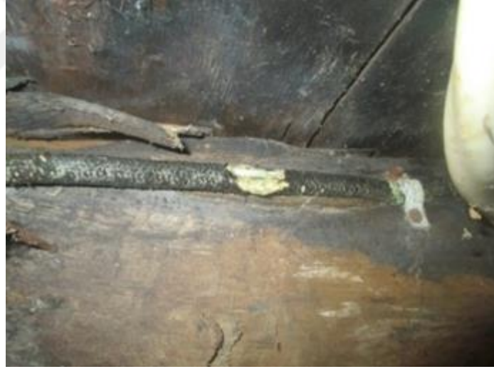
Şekil 4.12. Plastik veya çelik örtü kullanılmamış ve kemirgene maruz kalmış bir kablo. (Vegte and ets., 2021)
