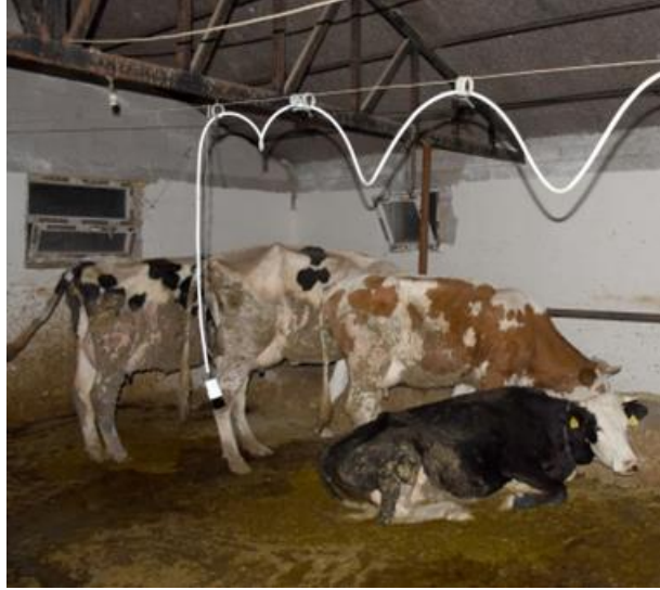
Şekil 4.17. Yanlış kablo konumu (URL-30)
