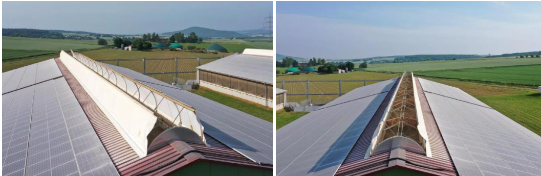
Şekil 4.45. Mekanik havalandırma örneği (açık-kapalı) (URL-41)
