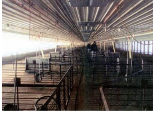
Şekil 4.8. Elektrik sorunu yaşanan ahır iç görüntüsü (Iowa FACE, 2014)
