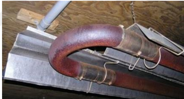
Şekil 4.22. Koruma kalkanına sahip radyant borulu ısıtıcı (OMAFRA 2011, s. 4)
