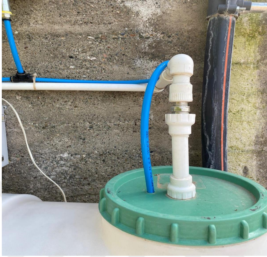
Şekil.4.6. Karıştırma Tankı Sıvı Gübre ve Saf Su Girişi
