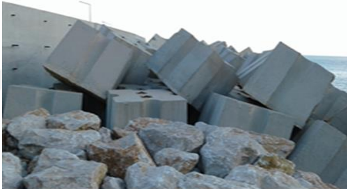
Şekil 3.6. Antiğer bloklu dalgakıran inşası
