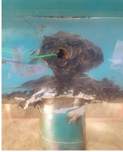
Şekil 5.25. Kolektör giriş ağzına yerleştirilen termokupl
