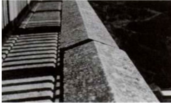
Şekil 1.9 Parapet elemanı, Val de Mare Barajı, Jersey (Poole, 1992)
