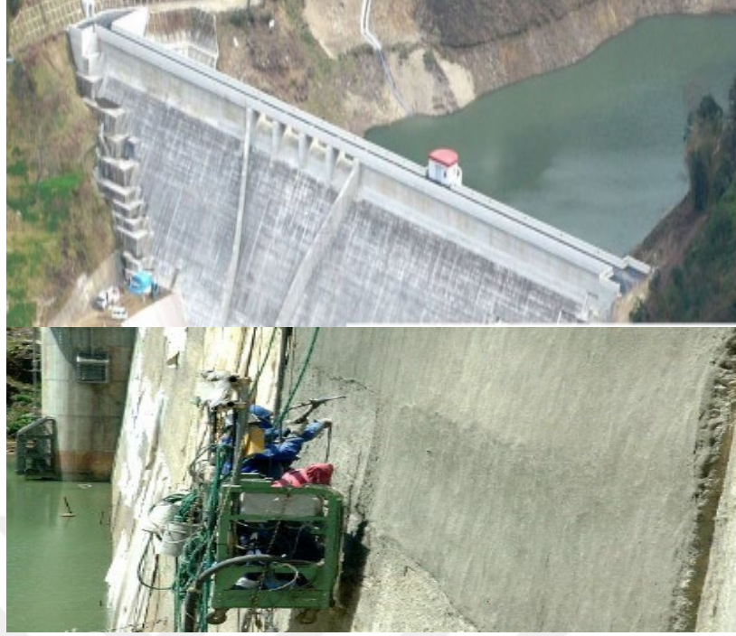
Şekil 2. 11 Mitaka Barajında su yalıtımı tadilatı amacıyla ECC uygulaması (Kojima ve diğ., 2004)
