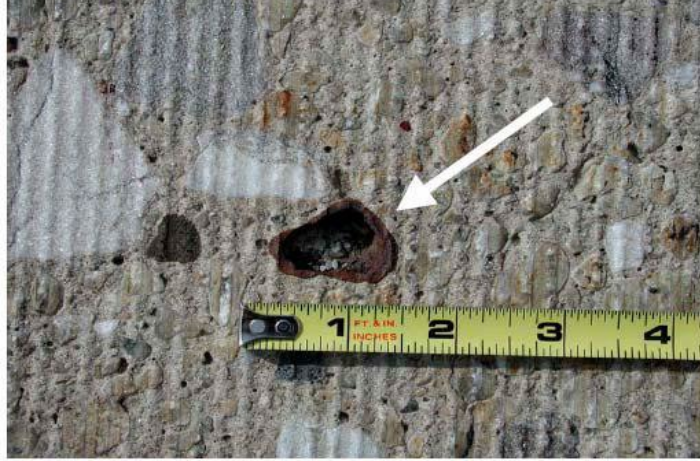
Şekil 1.8 Pop-out ile yüzeyden ayrılmış agrega tanesi (Aydın, 2012)
