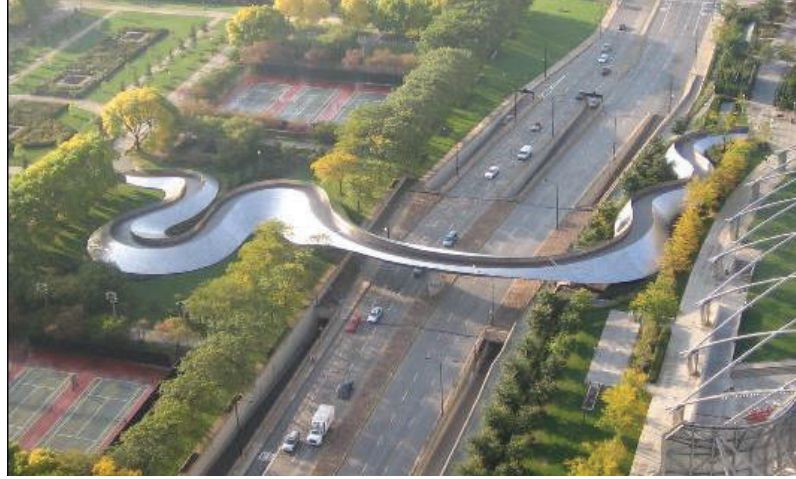
Görsel 3.16. Chicago BP Yaya Köprüsü
