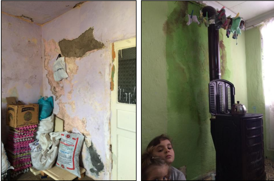
Şekil 4.43 : Ziyaret edilen konutlardaki rutubet sorununu gösteren resimler.
