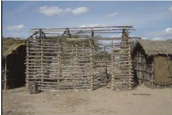
Şekil 3.13: Ağaç çubuk çerçeve sistem barınak (Sipus,2005).
