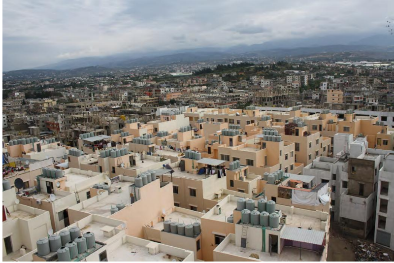
Şekil 3.21: Tamamlanan etabın bitmiş hali (UNRWA,2010).
