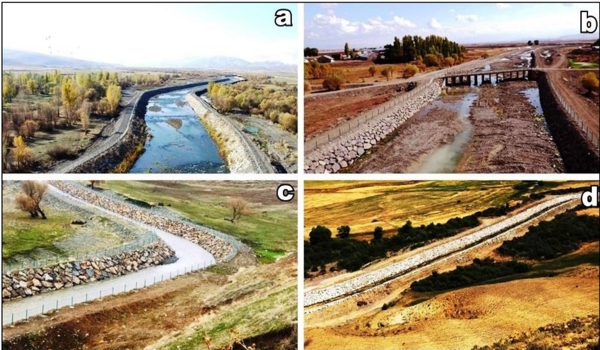
Şekil 1.17. Sedde ve istifli taş tahkimat ile taşkın koruma tesisleri Ağrı Eleşkirt Yücekapı (a), Ağrı Eleşkirt Değirmenoluğı (b), Erzurum Karayazı Çelikli (c), Erzurum Horasan Akçataş (d)
