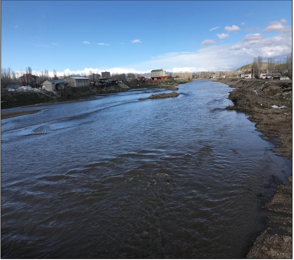
Şekil 2.8. Murat Nehri'nin kıyı kesimindeki yapılaşmayı gösteren görüntü ( Murat Köprüsü'nden membaya doğru).
