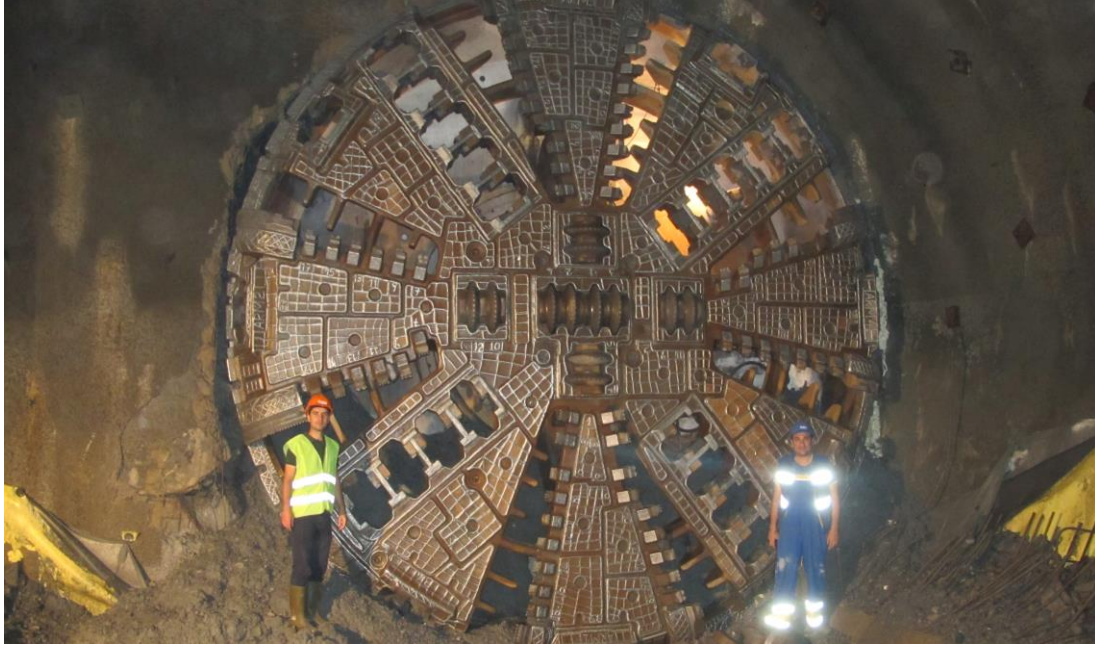
Şekil 5.73 : Üsküdar – Ümraniye – Çekmeköy metro tüneli kazısında kullanılan TBM.
