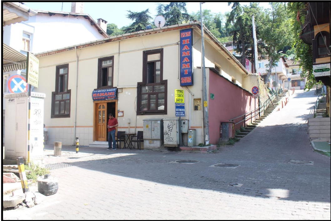
Şekil 3.49. Yahudiler Hamamı Giriş Cephesi (Asiltürk, 2023)
