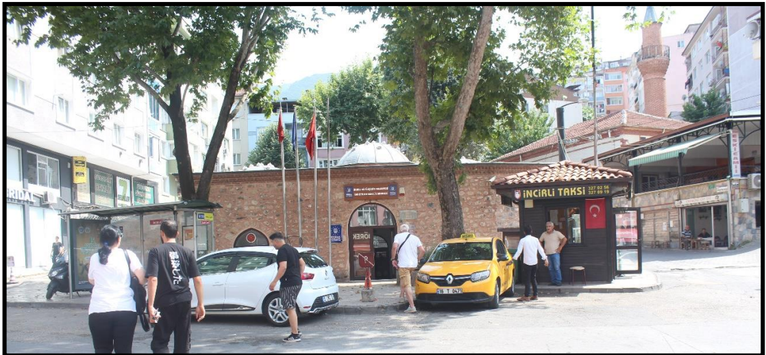
Şekil 3.124. Muallimzade Hamamı Giriş Cephesi (Asiltürk, 2023)
