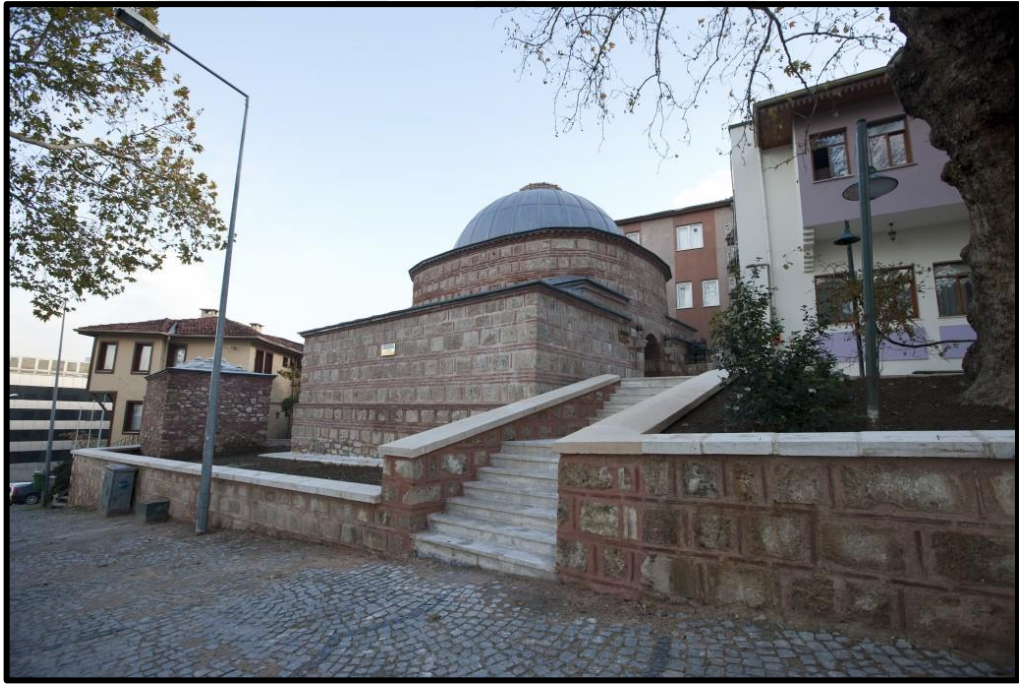
Şekil 3.68. Cık Cık Hamamı'nın Batı Cephesine Yapılan Merdiven (URL-15)
