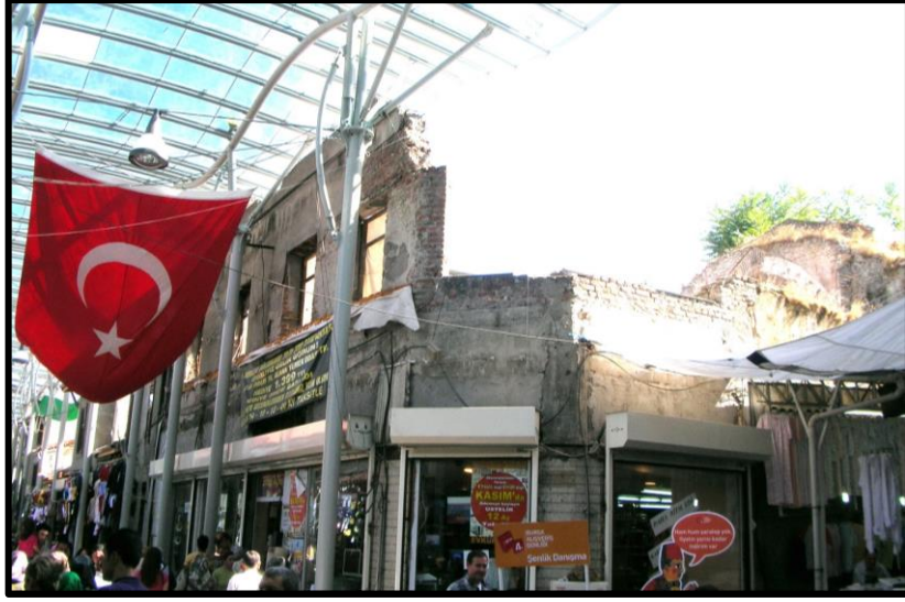
Şekil 3.144. Nalıncılar Hamamı'nın Kuzey Cephесinin 2008 yılındaki Görünümü (B.B.B Arşivi, 2008)
