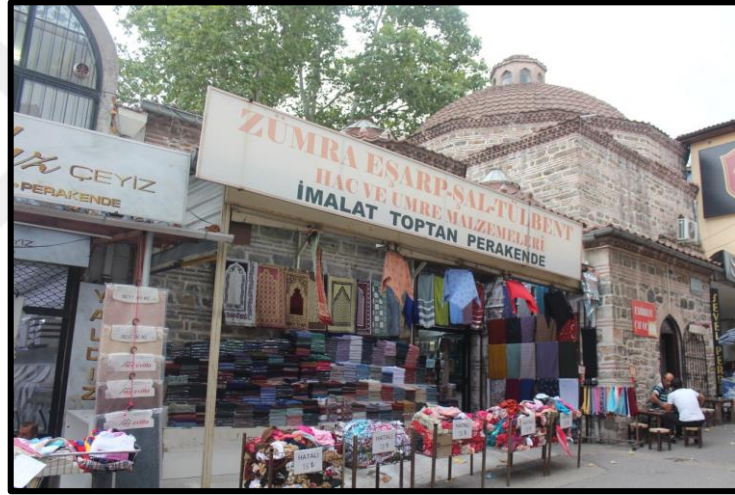
Şekil 3.178. Perşembe Hamamı'nın Batı Cephesi (Asiltürk, 2023)
