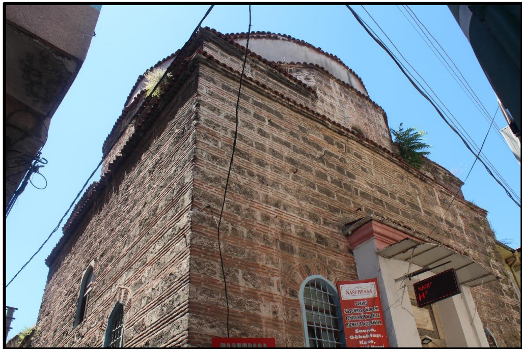
Şekil 3.37. Nasuhpaşa Hamamı'nın Giriş Cephesi (Asiltürk, 2023)
