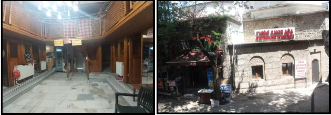
Şekil 3.5. Çakırağa Hamamı Kadınlar Kısmı Soyunmalık Bölümü (Asiltürk, 2023)
