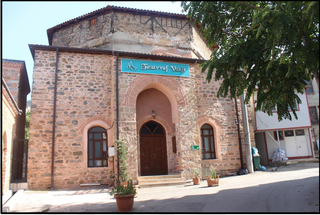
Şekil 3.58. Başçı İbrahim Bey Hamamı Cephesi (Asiltürk, 2023)
