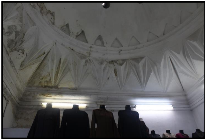
Şekil 3.201. Tavukpazarı Hamamı'nda Meydana Gelen Bozulmalar (Asiltürk, 2023)
