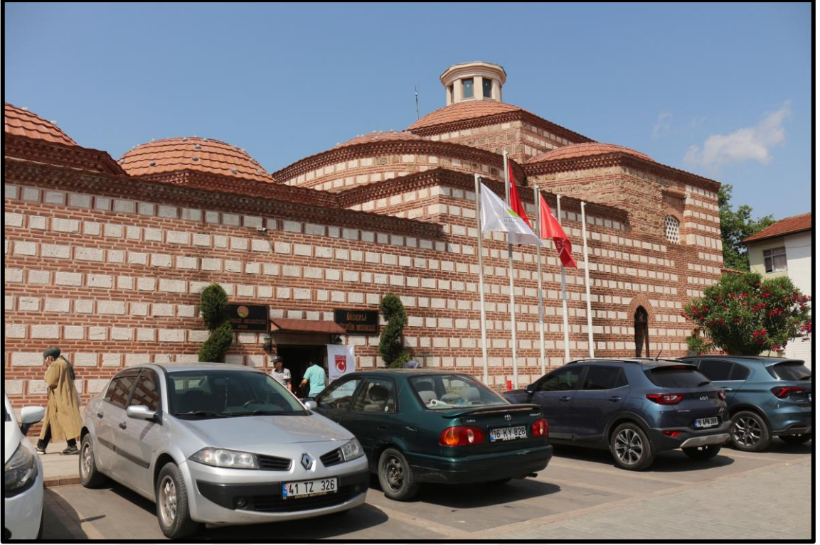
Şekil 3.159. Ördekli Hamamı Kuzey Cephesi (Asiltürk, 2023)
