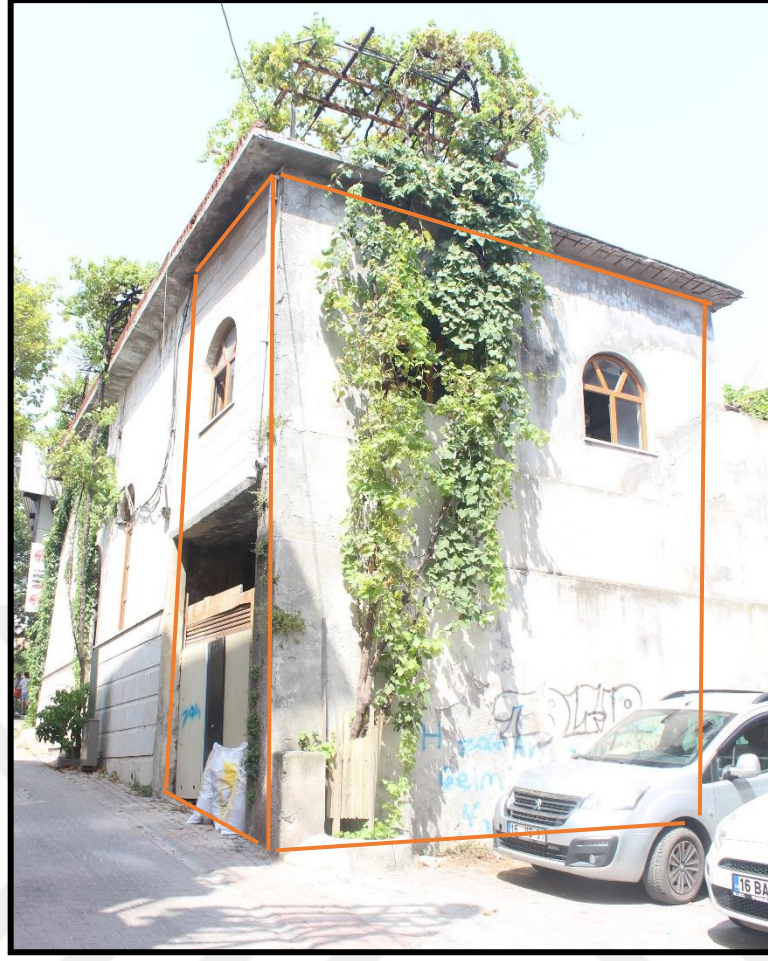
Şekil 3.55. Yıldırım Hamamı'nın Güney Cephesine Yapılan Ek (Asiltürk, 2023)
