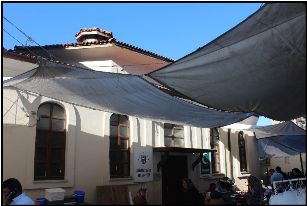
Şekil 3.182. Reyhanpaşa Hamamı Giriş Cephesi (Asiltürk, 2023)
