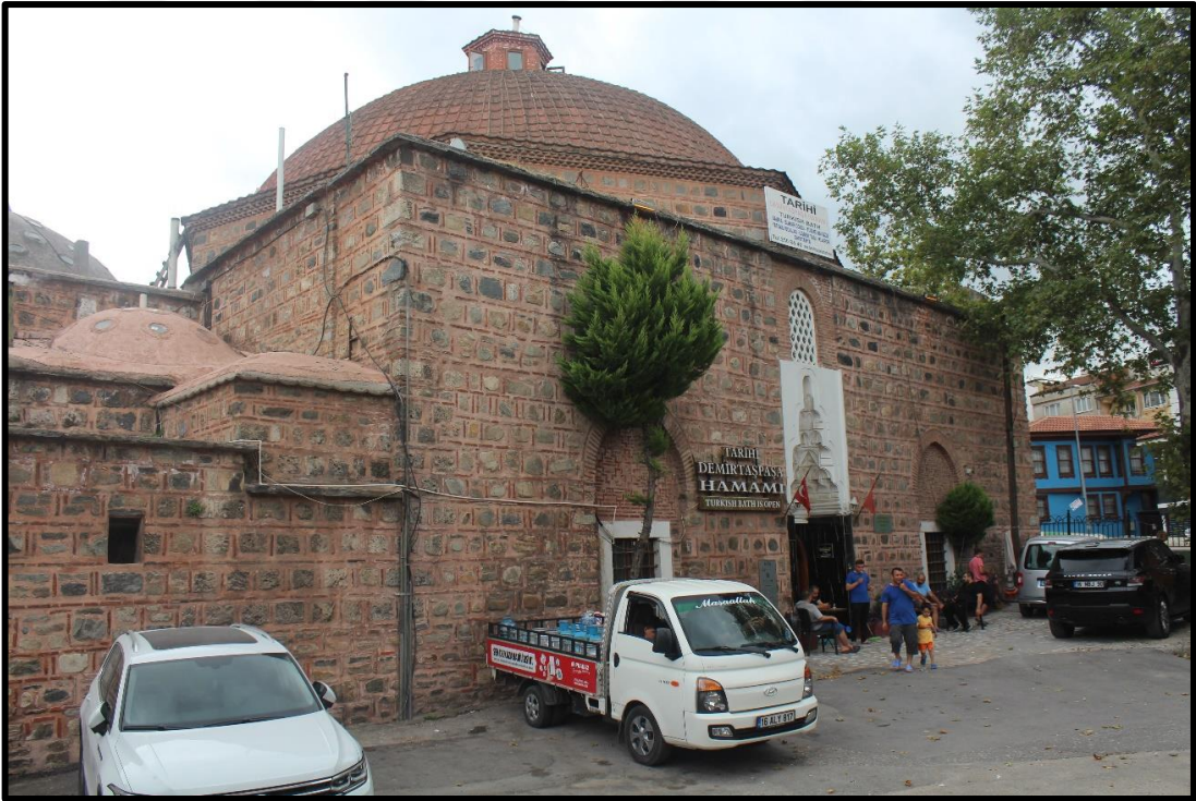
Şekil 3.16. Demirtaş Hamamı'nın Kuzey Cephesi (Asiltürk, 2023)
