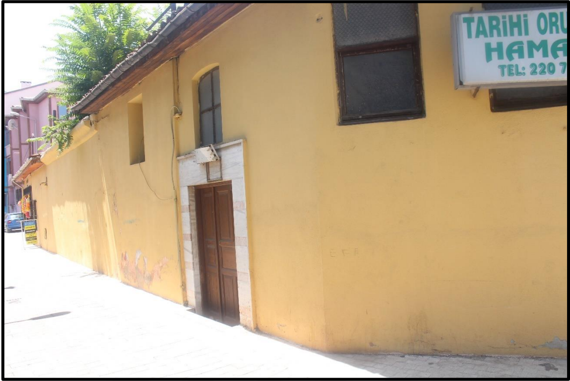
Şekil 3.23. Eski Orhan Hamamı'nın Doğu Cephesi (Asiltürk, 2023)
