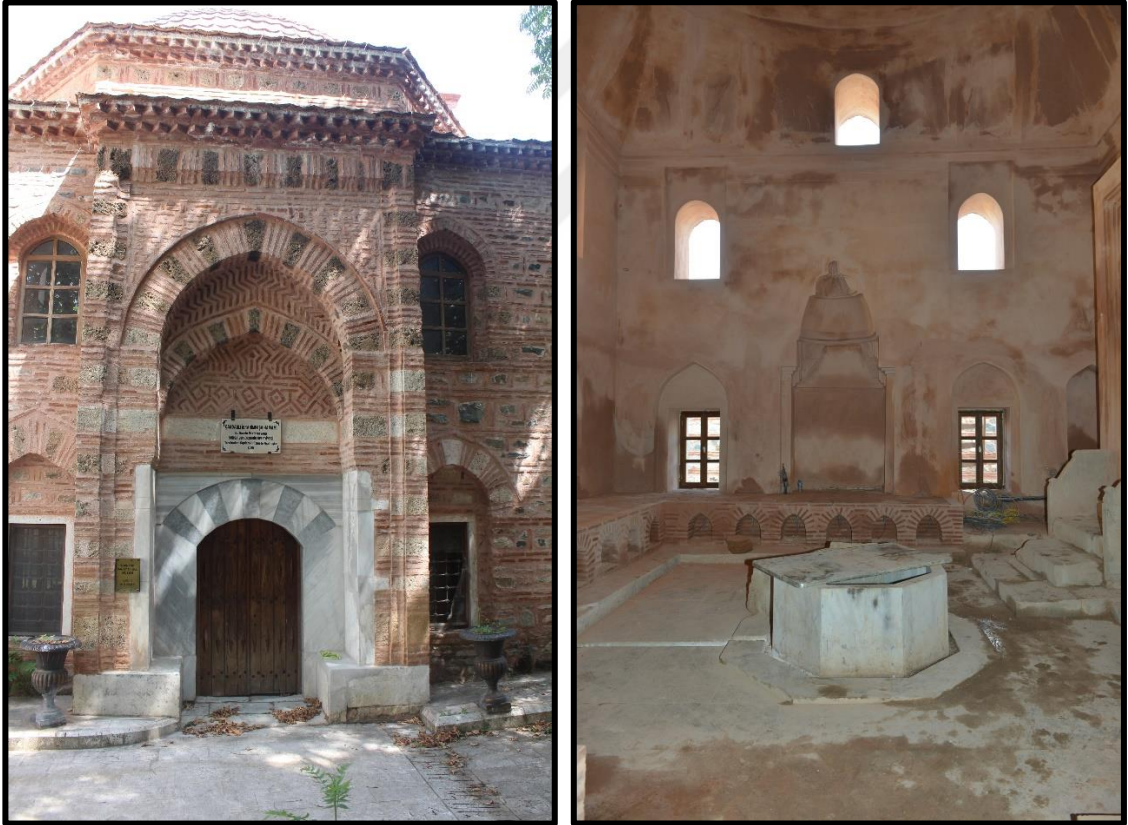
Şekil 3.83. Çandarlı İbrahimpaşa Hamamı Girişi (Asiltürk, 2023) Şekil 3.84. Çandarlı İbrahimpaşa Hamamı Soyunmalık Bölümü (URL-20)
