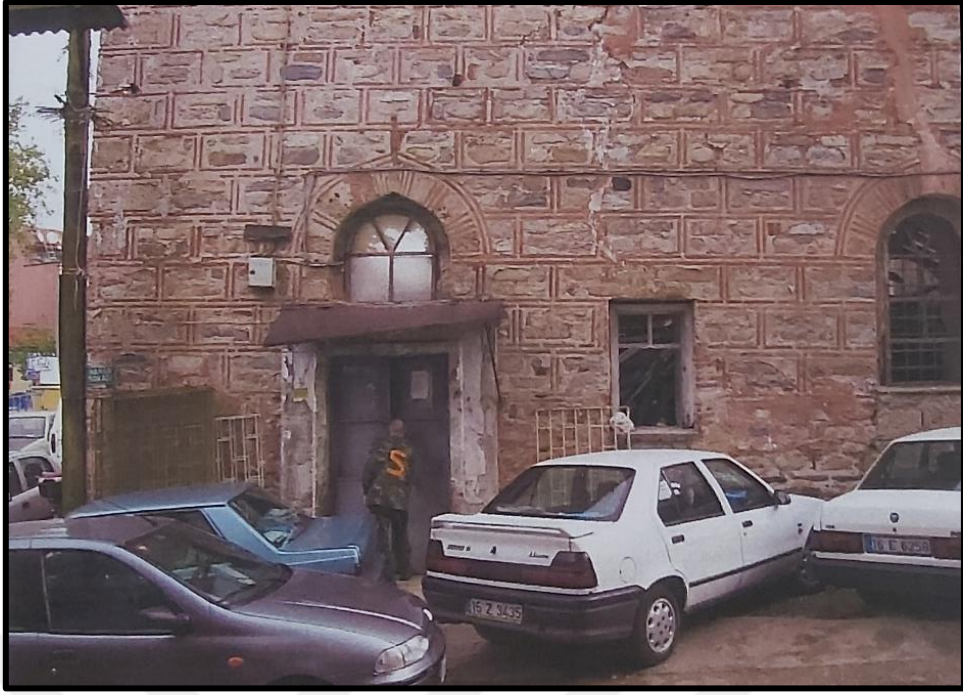
Şekil 3.78. Emir Sultan Hamamı Batı Cephesi (K.T.V.K.K. Arşivi, 2006)
