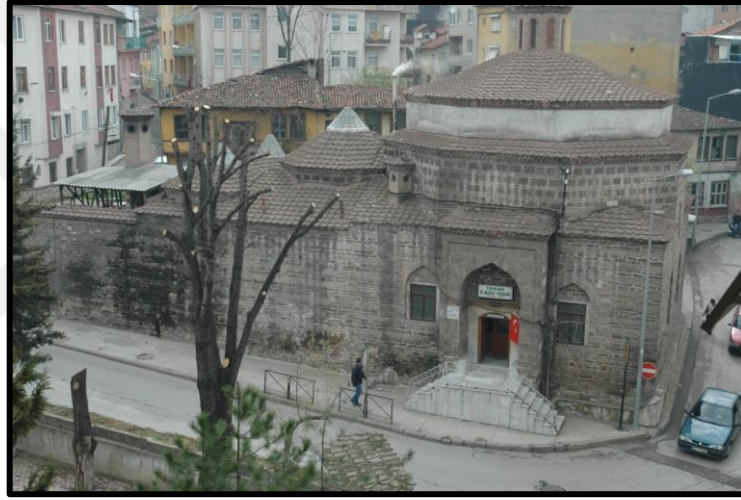
Şekil 3.138. Muradiye (II. Murat) Hamamı'nın Batı Cephesinin 2005 yılındaki Görünümü (B.B.B Arşivi, 2005)
