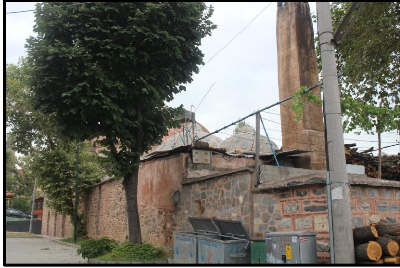
Şekil 3.18. Demirtaş Hamamı'nın Sonradan Yapılan Külhan Duvarı (Asiltürk, 2023)
