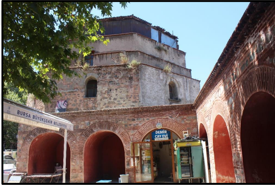
Şekil 3.217. Davutpaşa Hamamı'nda Bulunan Sıralı Dükkânlar (Asiltürk, 2023)
