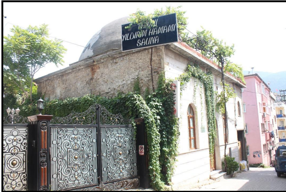
Şekil 3.56. Yıldırım Hamamı Batı Cephesinin Görünümü ve Soyunmalık Kubbesi (Asiltürk, 2023)
