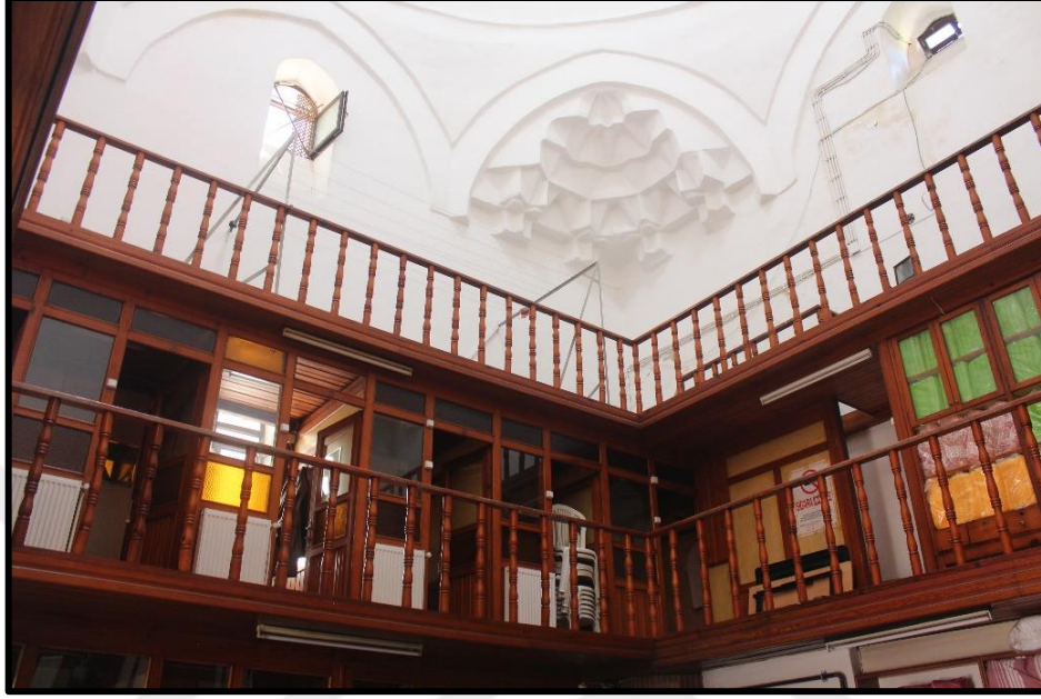
Şekil 3.40. Nasuhpaşa Hamamı Soyunmalık Kısımındaki Ahşap Bölmeler (Asiltürk, 2023)
