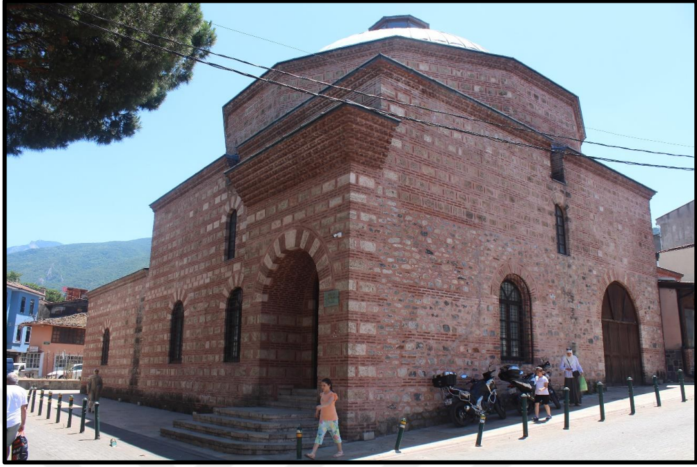
Şekil 3.100. Kayhan Hamamı Kuzey Cephesi (Asiltürk, 2023)
