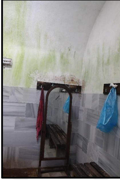
Şekil 3.33. Küplüce Hamamı'nın İç Mekanındaki Bozulmalar (Asiltürk, 2023)
