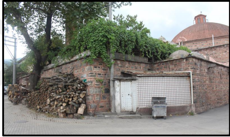
Şekil 3.19. Demirtaş Hamamı'na Sonradan Yapılan Depo (Asiltürk, 2023)
