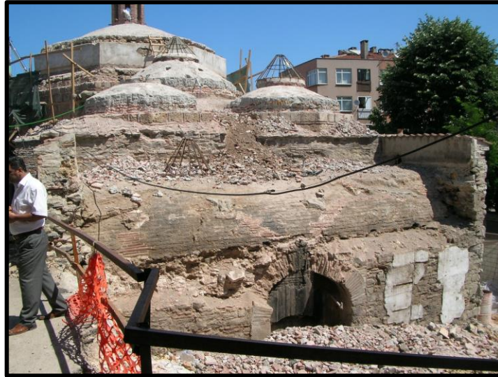
Şekil 3.139. Muradiye (II. Murat) Hamamı'nın Restorasyon Çalışması (B.B.B Arşivi, 2008)
