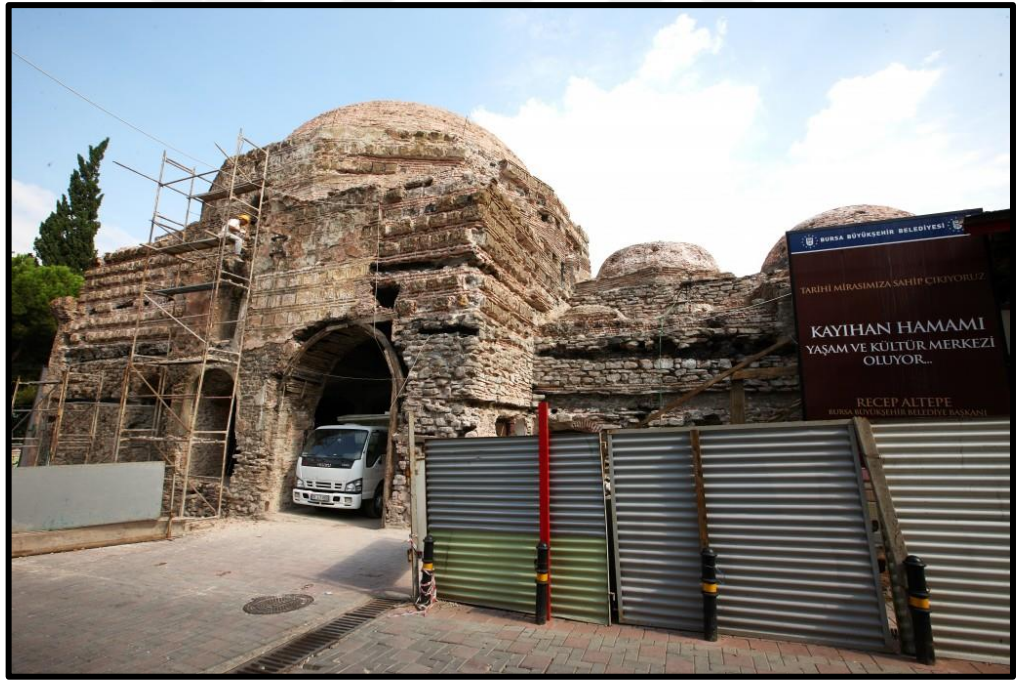
Şekil 3.103. Kayhan Hamamı Kuzeybatı Cephesi Restorasyon Çalışması, 2010 (URL-29)
