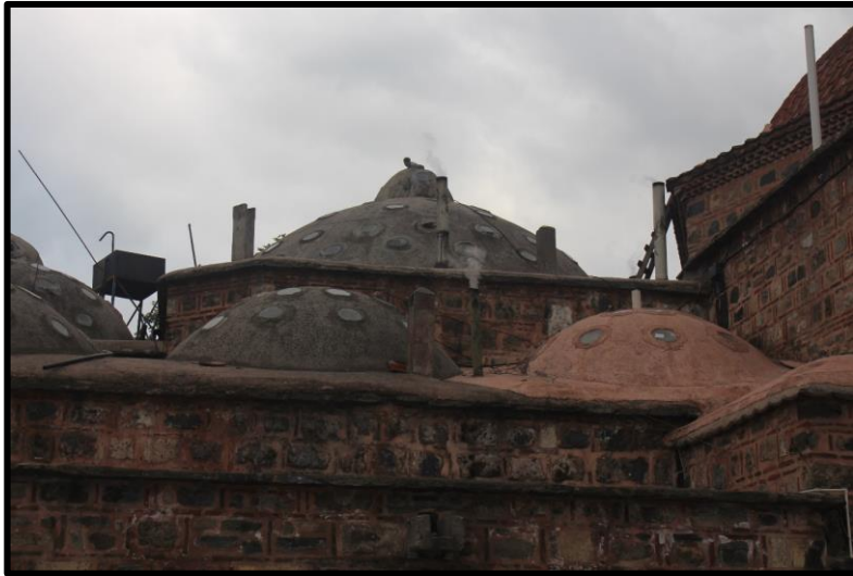
Şekil 3.20. Demirtaş Hamamı Kubbelerinin Betonla Sıvalı Durumu (Asiltürk, 2023)
