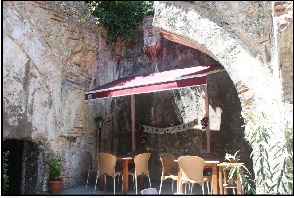
Şekil 3.46. Nasuhpaşa Hamamı Kadınlar Kısımına Ait Eyvan (Asiltürk, 2023)
