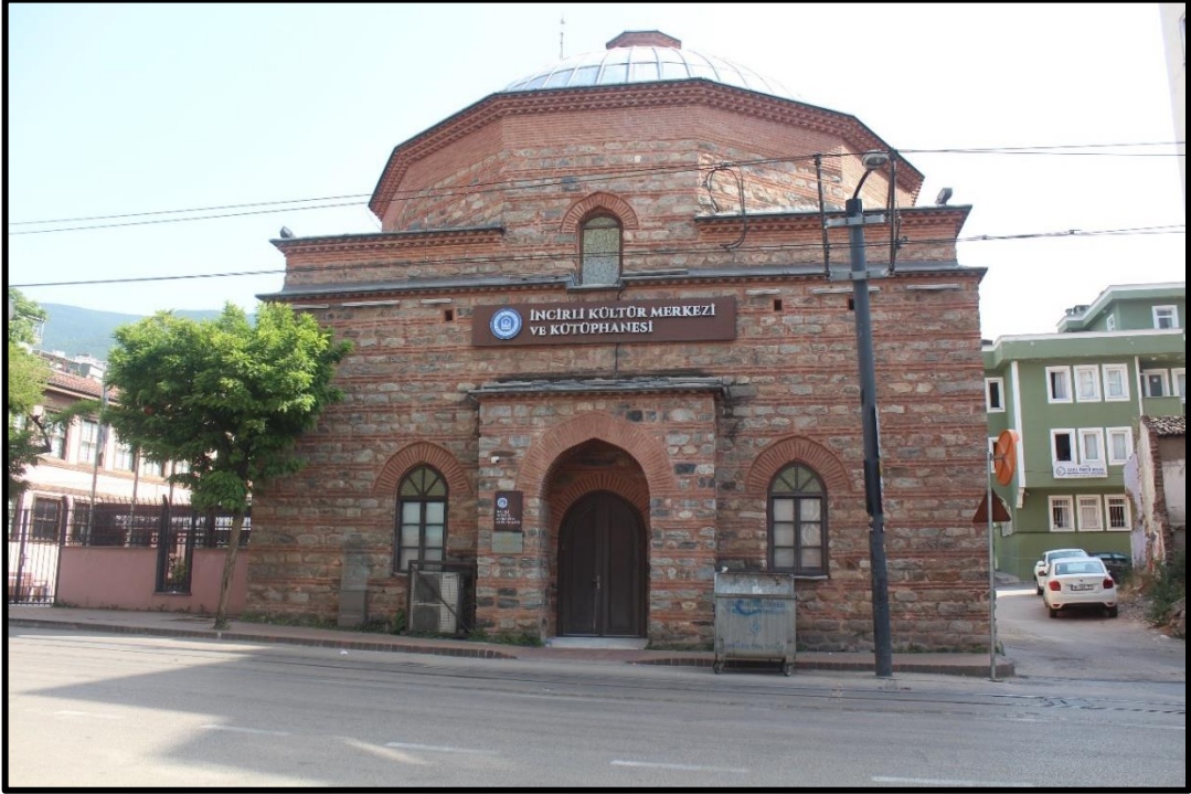
Şekil 3.87. İncirli Hamamı Kuzey Cephesi (Asiltürk, 2023)
