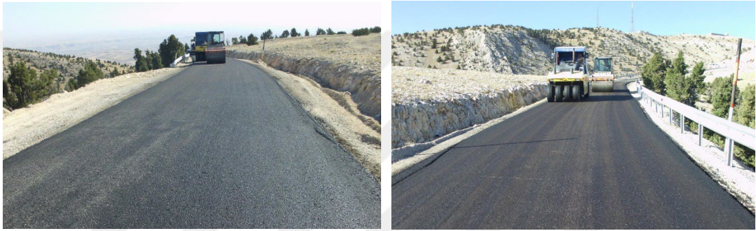
Şekil 5.11. Silindiraj İşlemleri (Fotoğraf: Eskişehir YİKOB)
