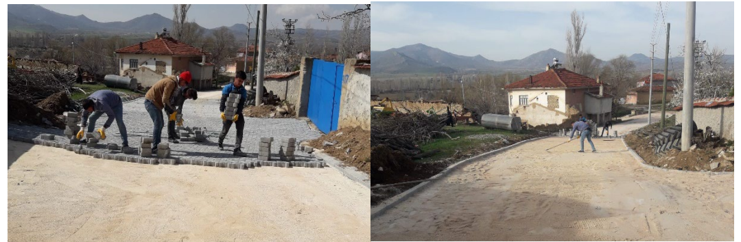
Şekil 2.7. Kilitli Parke Taşı Yapım Çalışmaları (Fotoğraf: Eskişehir YİKOB)
