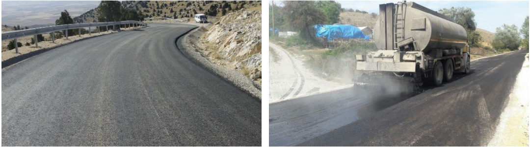
Şekil 2.6. Asfalt Yol Yapım Çalışmaları (Fotoğraf: Eskişehir YİKOB)
