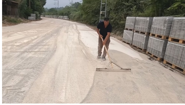
Şekil 5.5. Serilen Taş Tozunun Tesviye İşlemi (Fotoğraf: Eskişehir YİKOB)
