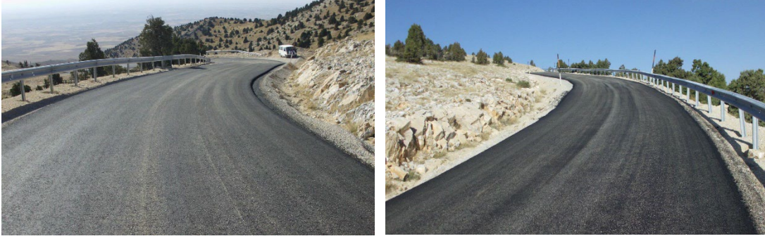
Şekil 5.12. Uygulama Örnekleri ( Fotoğraf: Eskişehir YİKOB )
