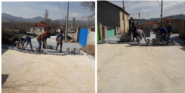
Şekil 5.6. Kilitli Parke Taşlarının Yerleştirilmesi İşlemi (Fotoğraf: Eskişehir YİKOB)
