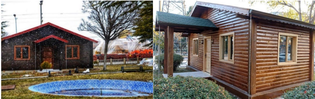
Şekil 2.3. Seyitgazi İlçesi Ahşap Mahalle Konağı (Fotoğraf: Eskişehir YİKOB)
