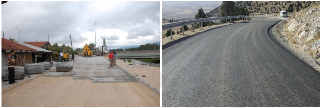
Şekil 4.2. Kilitli Parke Taşı ve Asfalt Yol Yapımı (Fotoğraf: Eskişehir YİKOB)
