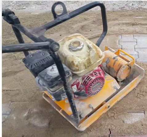
Şekil 5.7. Kompaktör Yardımı ile Sıkıştırma İşlemi (Fotoğraf: Eskişehir YİKOB)
