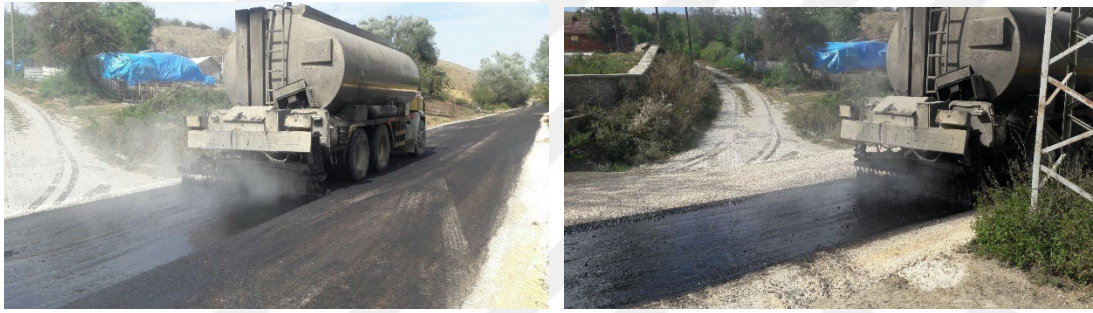
Şekil 5.9. Astarlama İşlemi (Fotoğraf: Eskişehir YİKOB)
