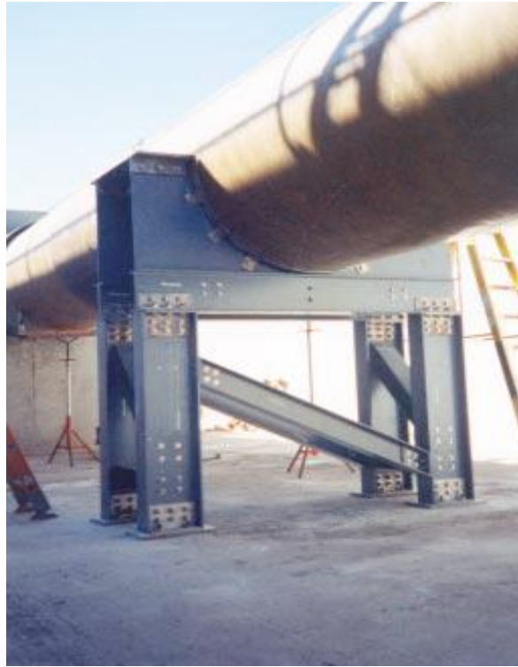
Şekil 1.2 : 300 metre uzunluğunda 140 cm çapında boru desteđi için kullanılan kompozit profiller [10].
