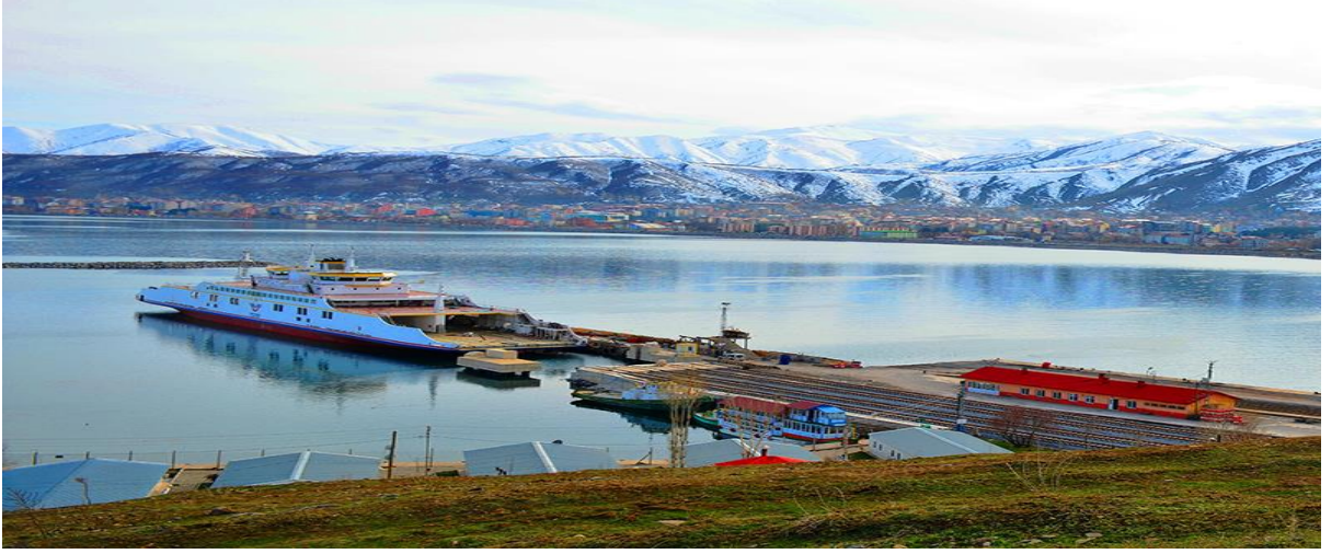
Şekil 2.4. Van Gölü Feribot İşletmesinde Tren İstasyonu
