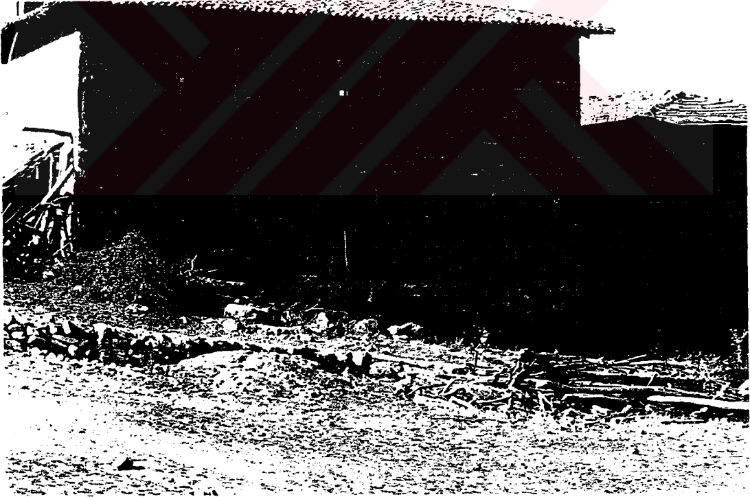
Foto: 12- Tavşanlı'da ağaç ve çamur çok kullanılan yapı malzemelerindendir. Genellikle ahşabın yapı malzemesi olarak kullanıldığı konutlarda, alt kat taşdan, üst kat ise ağaçtan yapılır. Dışı ise çamurla sıvalıdır.
