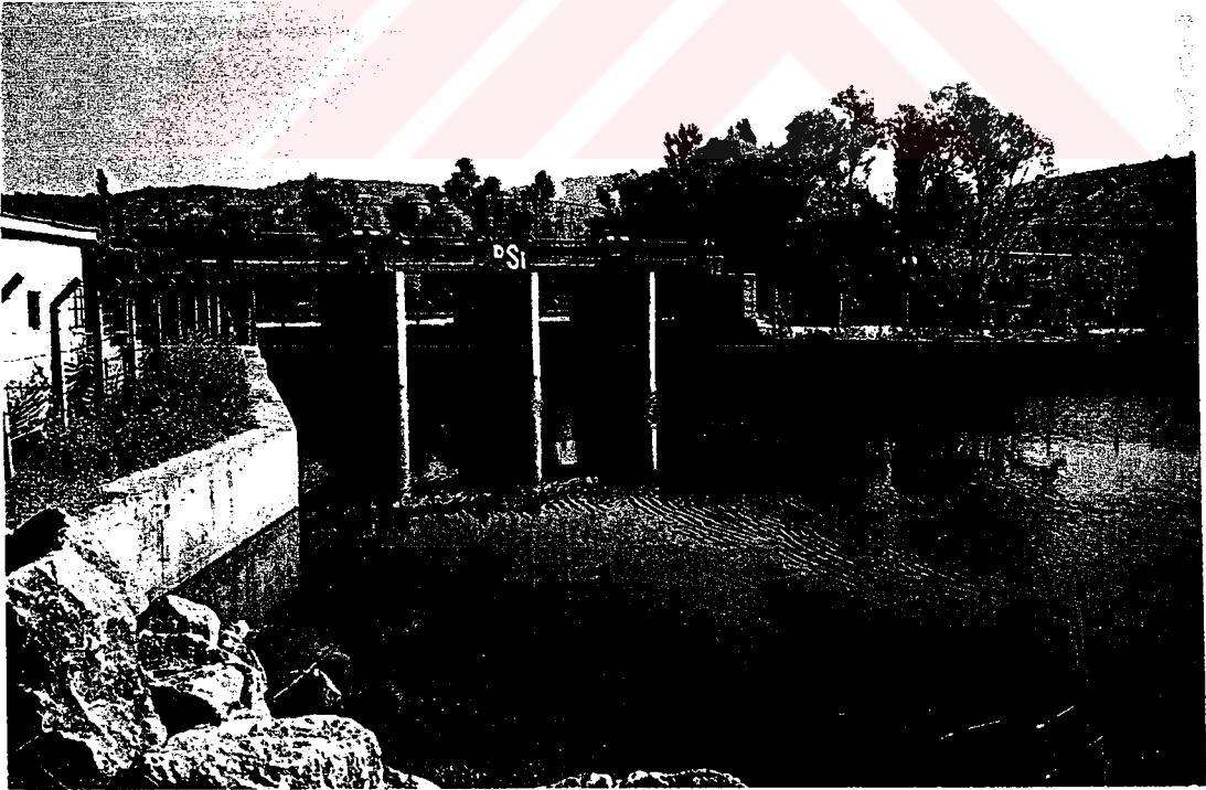
Foto: 19- Araştırma alanında sulamalı tarım için önemli olan Kayaboğazı barajı, Yağmurlu köyü yakınlarındaki regülatörden kanallara aktararak sulamada kullanılmaktadır.
