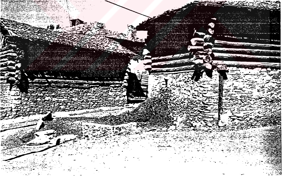
Foto: 16- Ağaç ve taşın kullanılarak yapılan bir hayvan ahır. Kozluca köyünde bu tür yapılar oldukça yaygındır. Taşın çoğunlukta kullanılması ise çevrede kalker ve marn gibi kolay işlenebilen kayaların olmasındandır.
