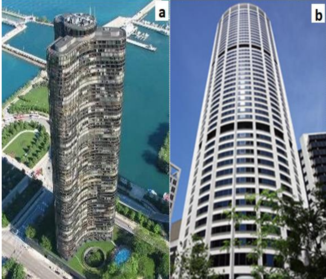
Şekil 1.5. Hafif beton kullanılmış çok katlı bina örnekleri a) Lake Point Tower (URL-2). b) Australia Square (URL-3).
