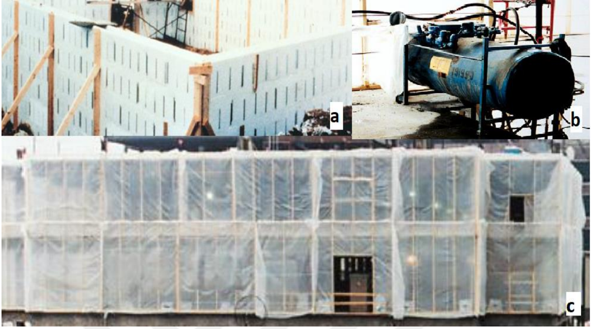
Şekil 1.21. Soğuk havada beton üretiminde alınacak bazı önlemler (URL-8) a) Yalıtımlı kalıplar b) Isıtma c) Polietilen naylon
