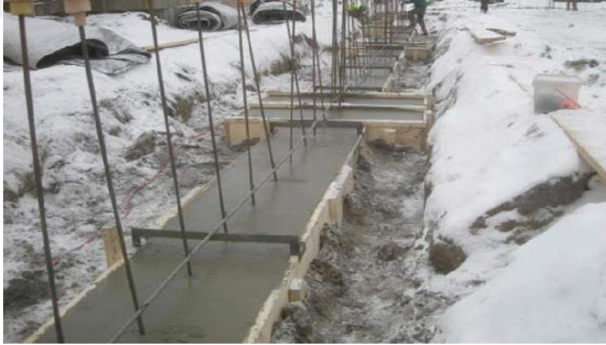
Şekil 1.20. Soğuk havada beton dökümü
