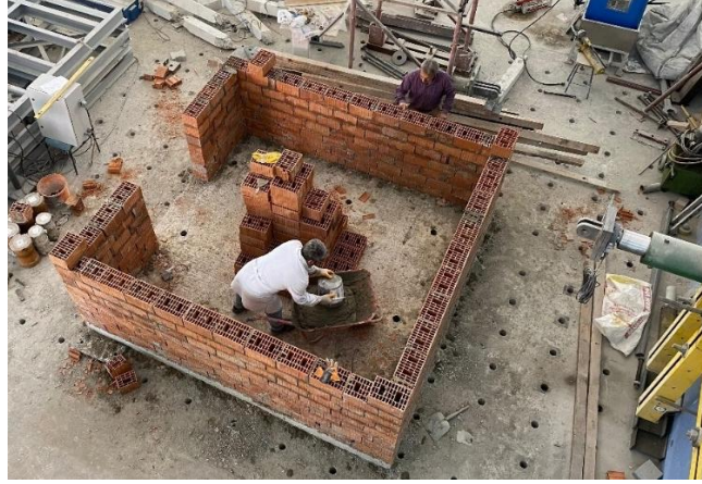
Şekil 4.14 Donatısız yığma bina duvar örülme işlemi
