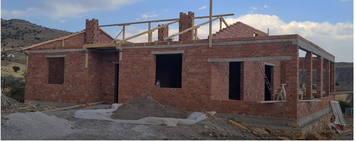
Şekil 3.11 Tuğla yığma bina örneği (Url-3, 2022)
