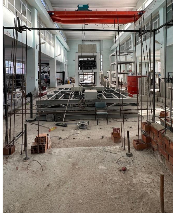
Şekil 4.22 Donatılı yığma bina duvar örülme işlemi ve ekimi yapılmış donatılar
