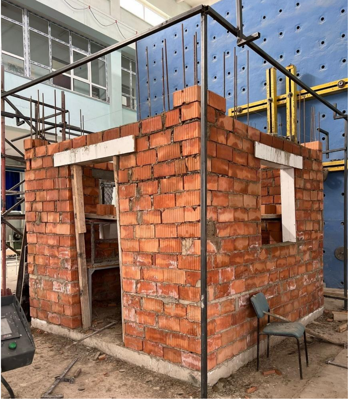
Şekil 4.26 Donatılı yığma bina lento üretimi
