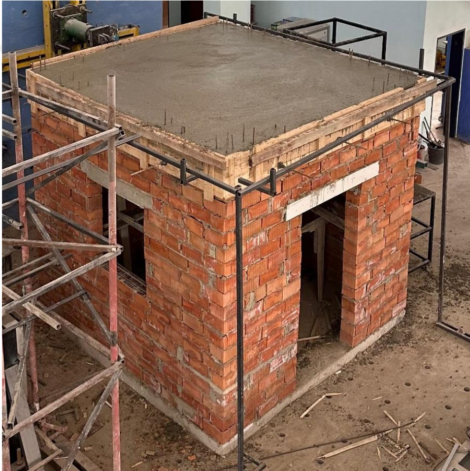
Şekil 4.31 Beton dökümü sonrası sulama işlemi yapılmış numune
