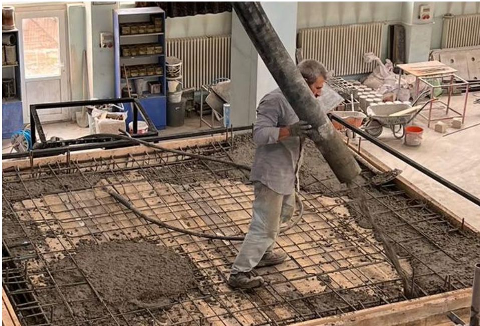
Şekil 4.18 Beton dökümü işlemi
