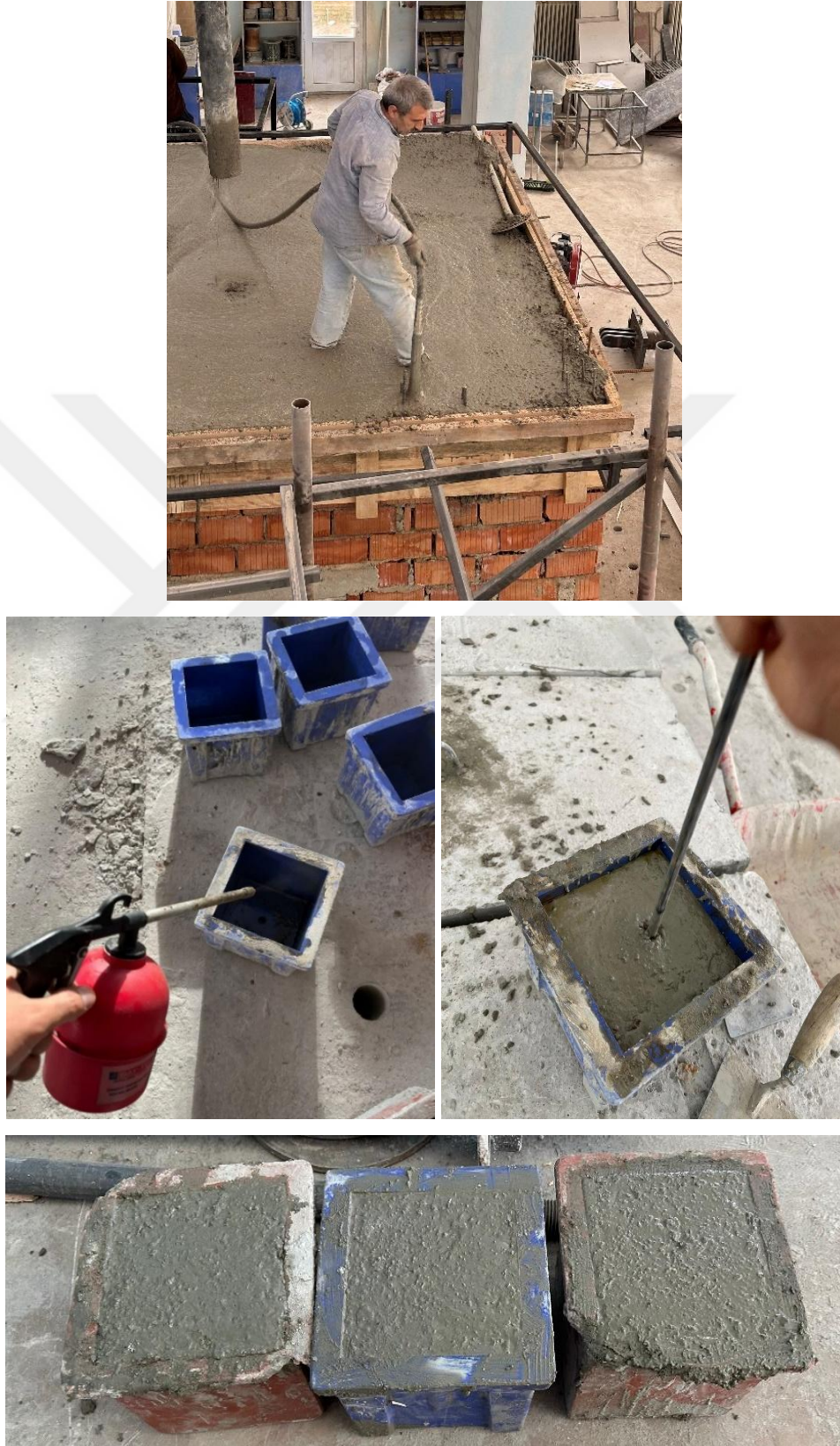
Şekil 4.30 Beton dökümü işlemi, numune alımı
