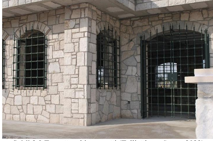
Şekil 3.9 Taş yığma bina örneği (Tellioglu ve Satıcı, 2023)
