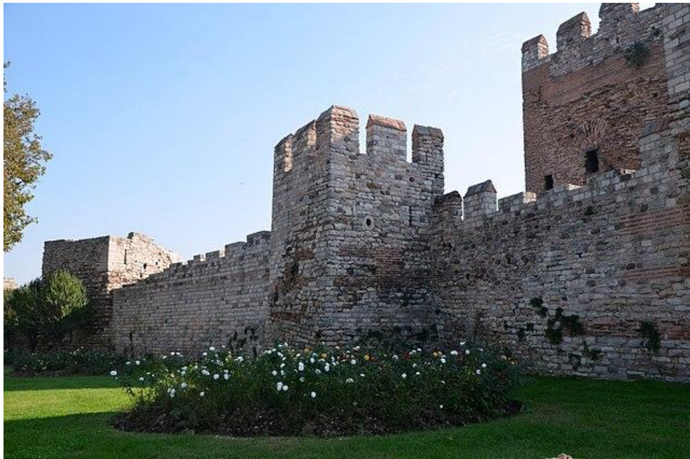
Şekil 3.1 Yığma bina örneği
