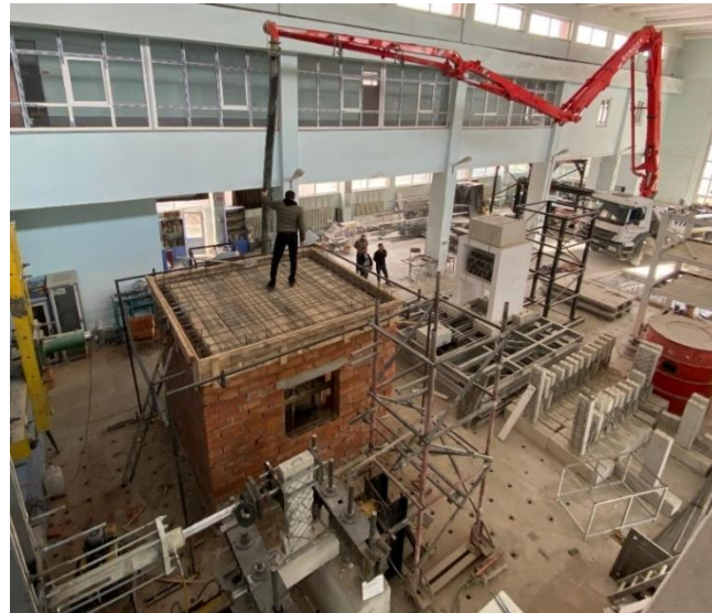
Şekil 4.29 Beton dökümü işlemi
